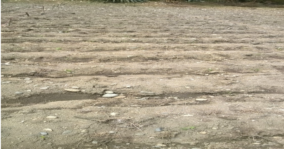
Fotografía N°01 preparación del terreno
