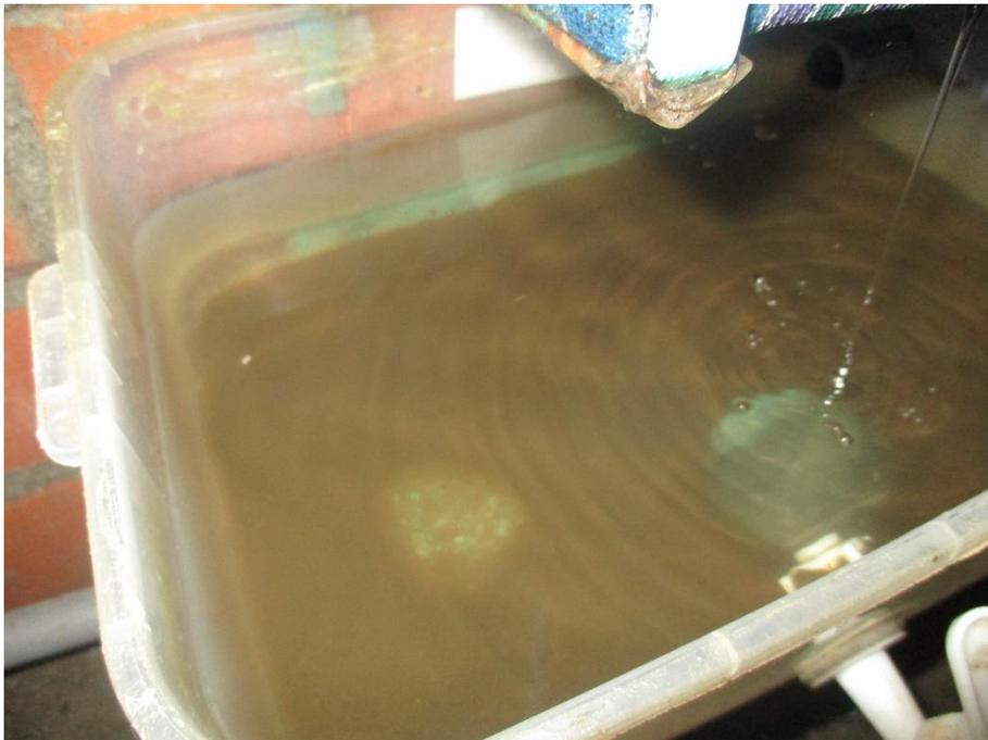
*Fotografía 48:* Agua residual tratada almacenada en el sedimentador secundario
