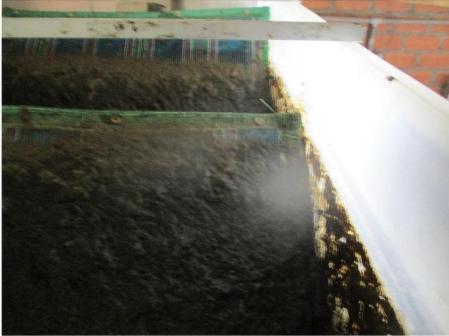
*Fotografía 53:* Colmatación de las mallas del sedimentador primario
