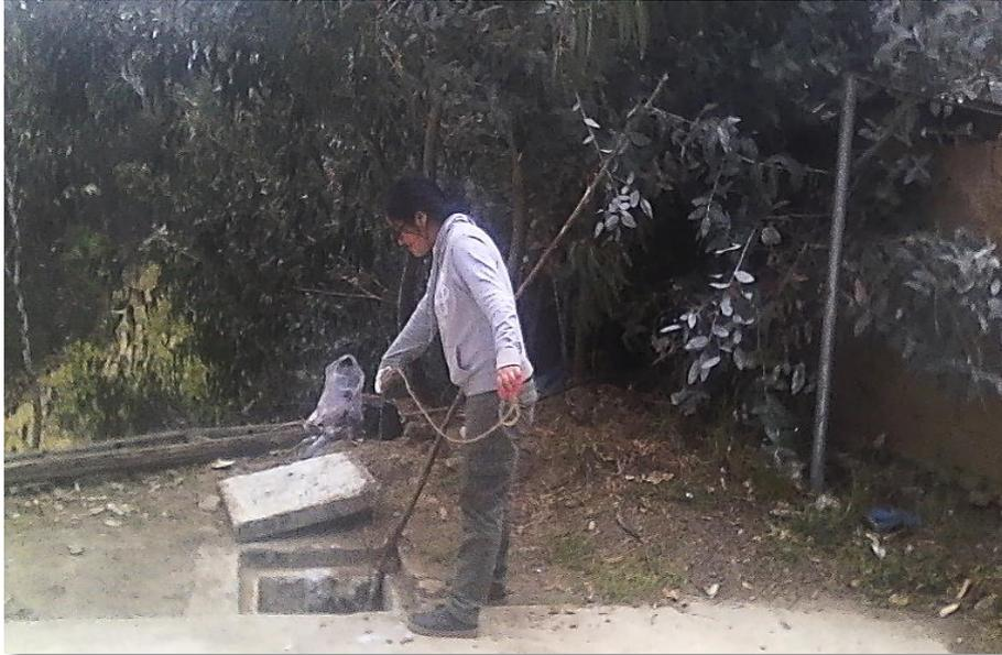
**Fotografía 23:** Aforo del caudal al ingreso del tanque séptico
