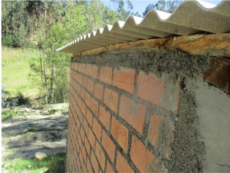
*Fotografía 7:* Tapado con mezcla de concreto pobre los exteriores de la caseta
