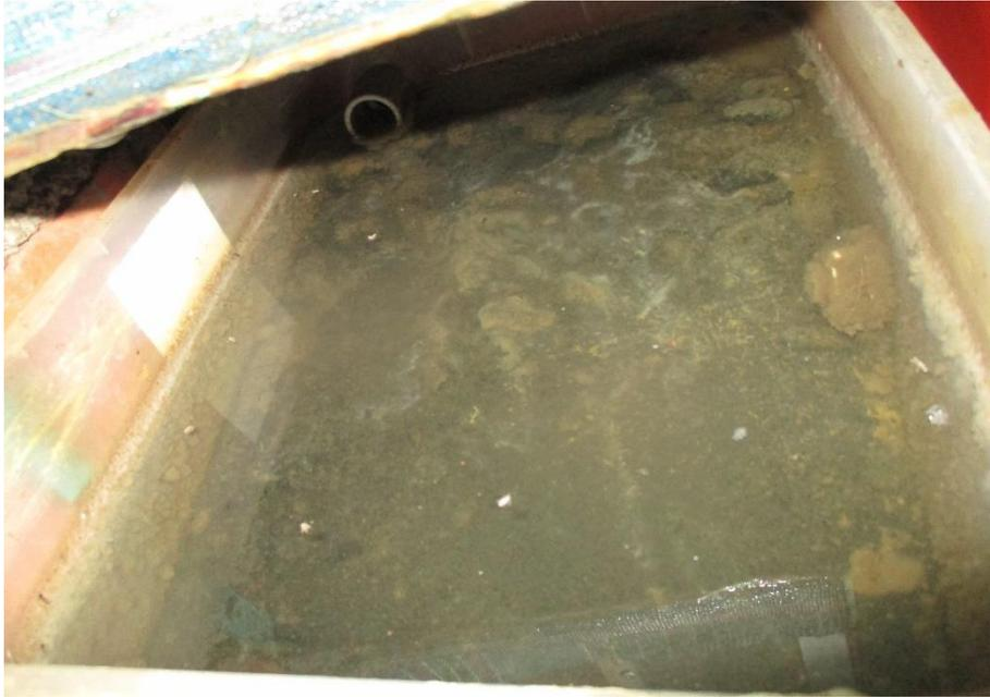
**Fotografía 49:** Acumulación de la biopelícula en el sedimentador secundario
