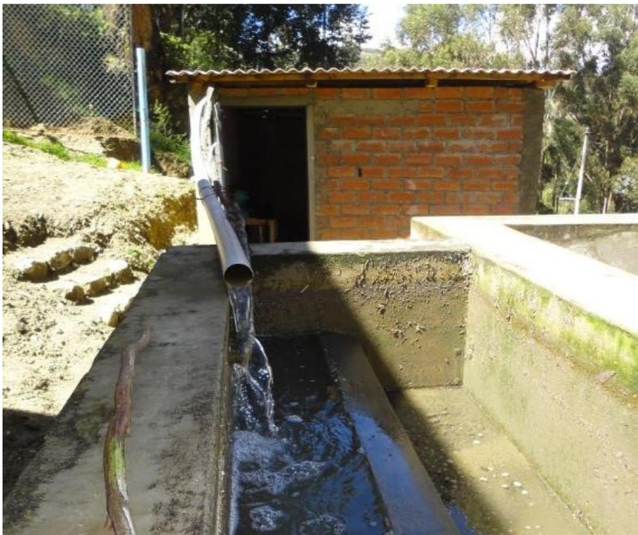
*Fotografía 32:* Tubería de rebose
