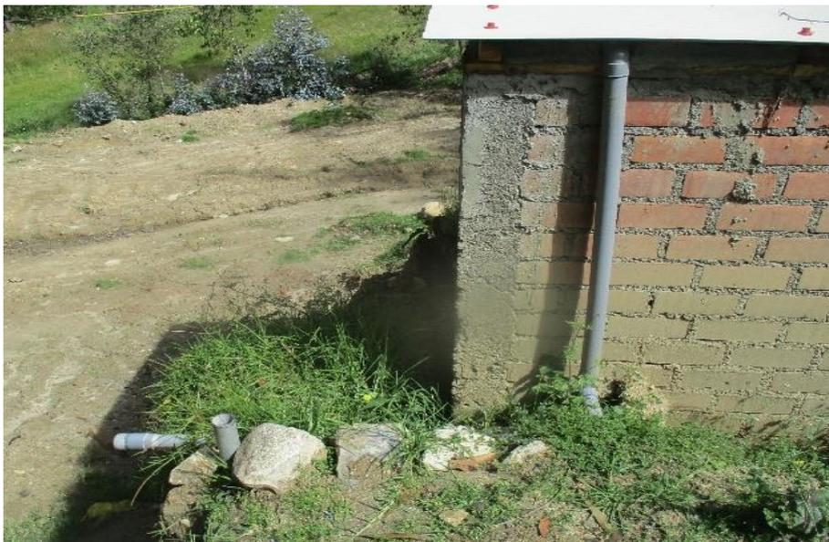
**Fotografía 30:** Tuberías de rebose para el mantenimiento del sedimentador primario
