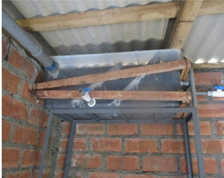
**Fotografía 8:** Sedimentador primario de 85 lt de capacidad
