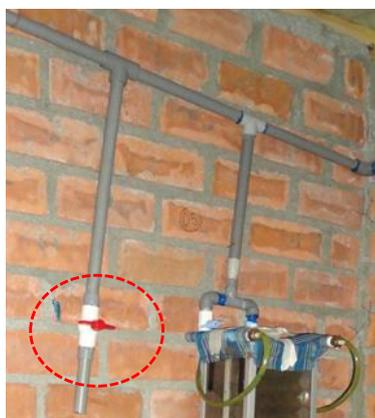
*Fotografía 12:* Implementación de la válvula de bola de PVC Ø=¾”
