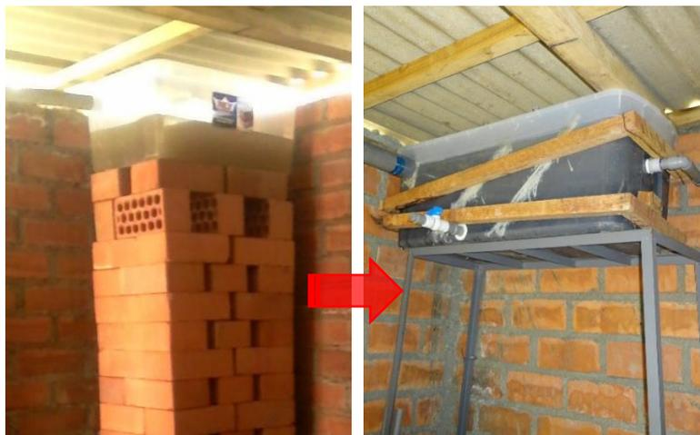
*Fotografía 11:* Implementación de un soporte fijo con ángulos de fierro para el sedimentador primario
