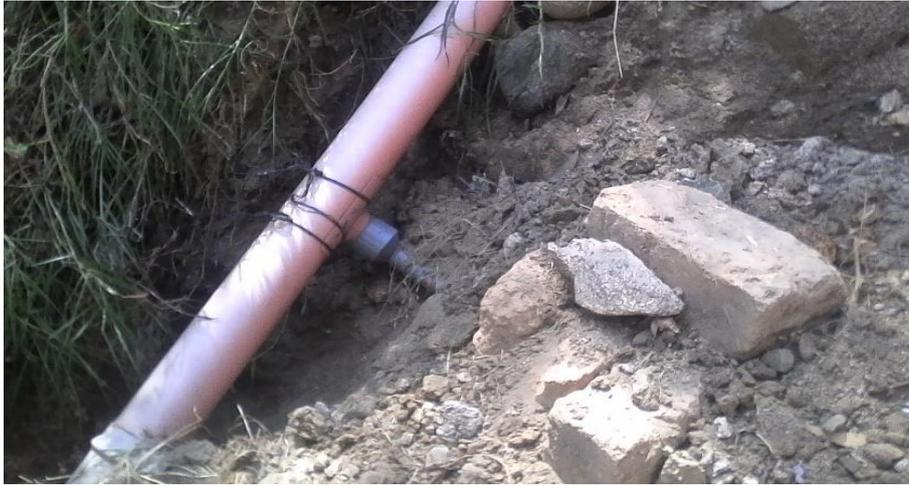
**Fotografía 29:** Instalación de la cachimba para la captación del afluente
