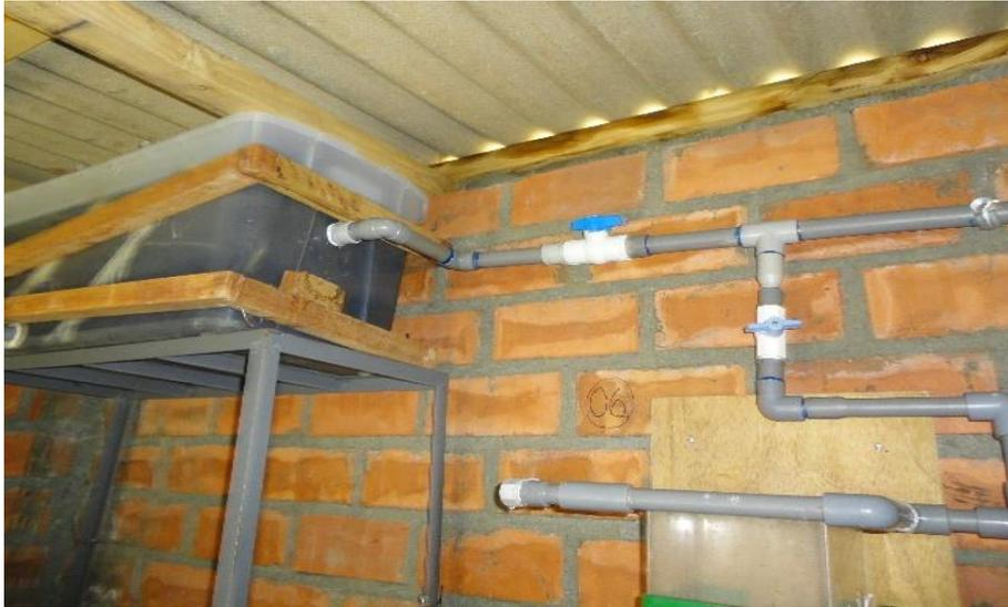
**Fotografía 33:** Tuberías de distribución al sistema de filtros esponjas colgantes continuas
