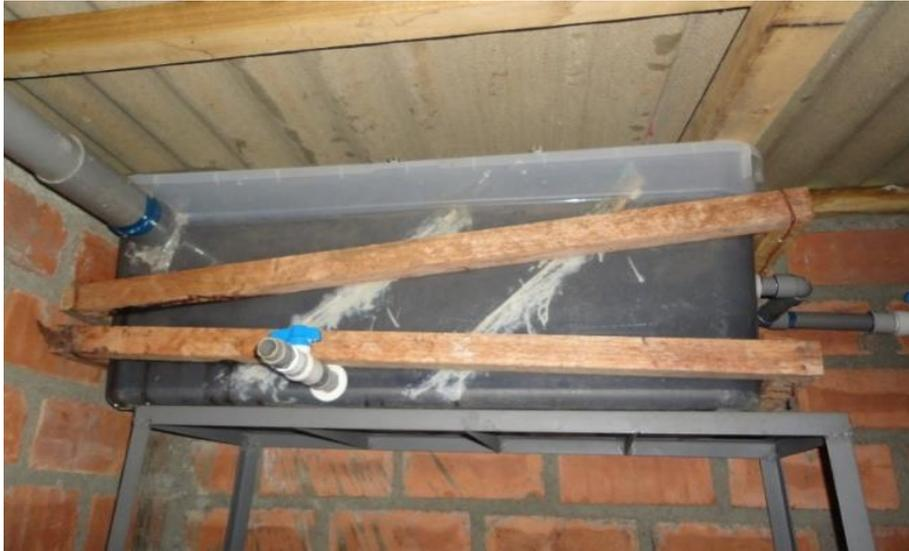
*Fotografía 31:* Instalación del sedimentador primario
