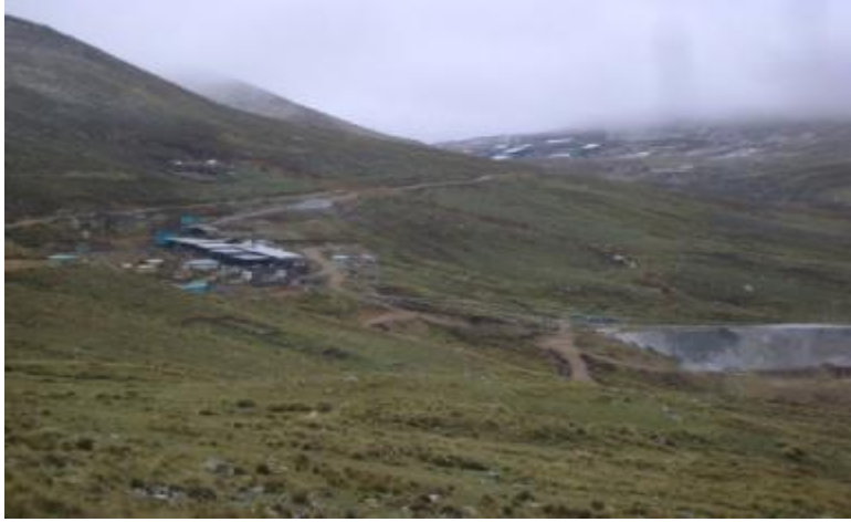
Fotografía N° 01: Planta Concentradora Huancapeti y la relavera, ubicadas al margen del riachuelo de la Quebrada de Sipchoc.
