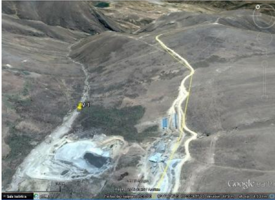
Planta Concentradora y Relavera Huancapeti
