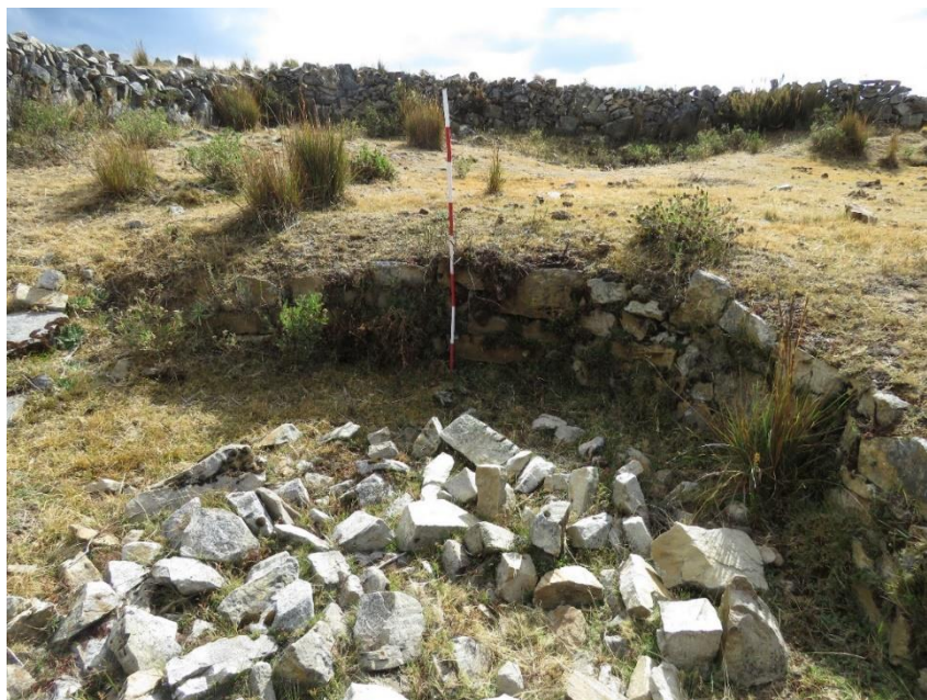
Fotografía N° 29: Vista de una de las estructuras (taller). Tomado por Ortega Mendoza Marylin, Octubre 2017.
