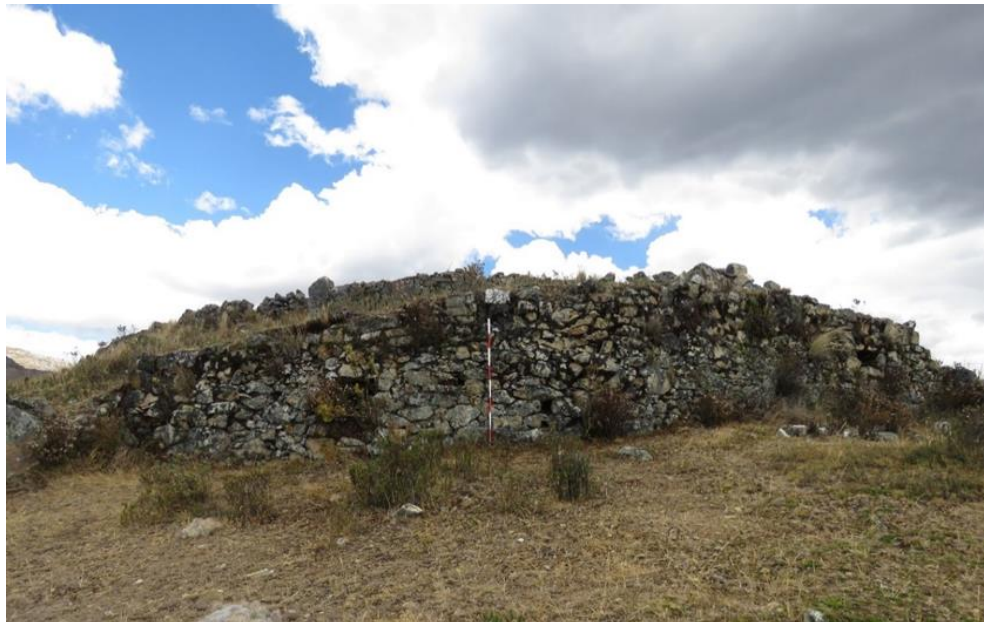
Fotografía N° 24: Vista del muro sur con nichos que circunda los recintos circulares (viviendas). Tomado por Ortega Mendoza Marylin, Octubre 2017.
