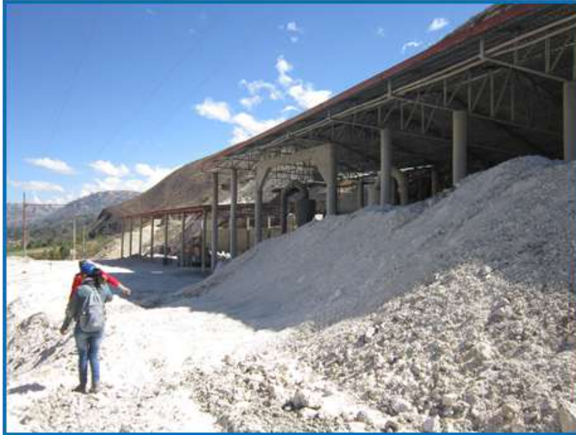
Figura N° 7. Instalaciones de la Calera Mistr S.A.
