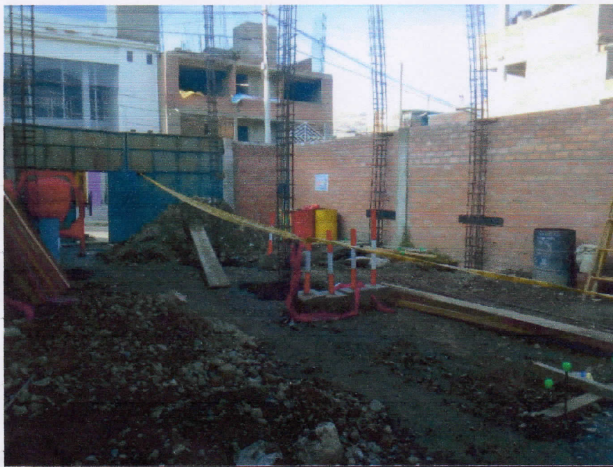
ARMADURA DE COLUMNAS EJES 2 Y 3
