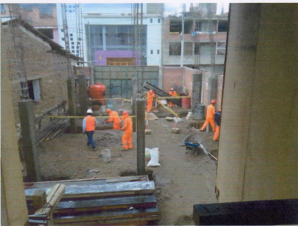
DESENCOFRADO DE COLUMNAS
