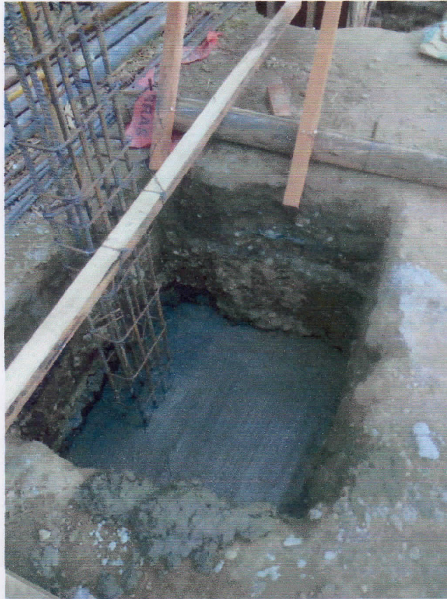
ZAPATA Y ARMADURA DE COLUMNA
