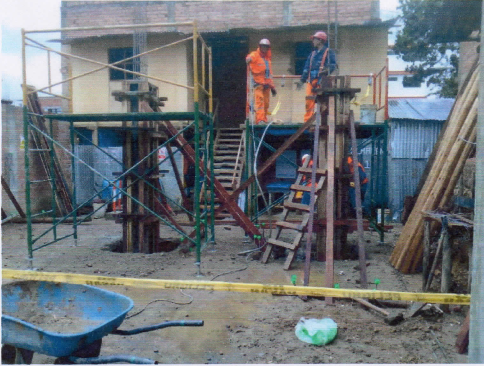
ENCOFRADO Y VACIADO DE CONCRETO EN COLUMNAS
