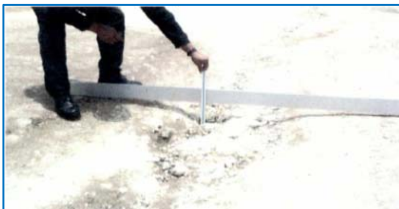
Figura N° 13: Erosión - Gravedad 3: Profundidad \geq 10 cm
