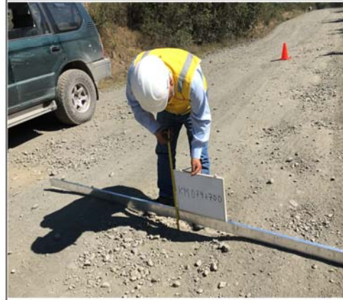
Foto 08: Inventario de fallas , en la KM 74+700 - carretera Vaqueria - Yanama
