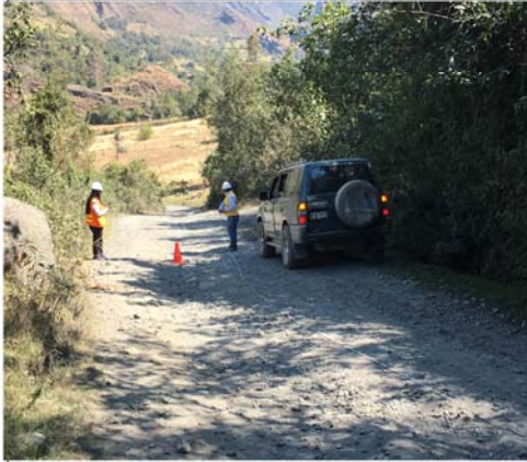
Foto 07: Inventario de fallas , en la KM 74+000 - carretera Vaqueria - Yanama
