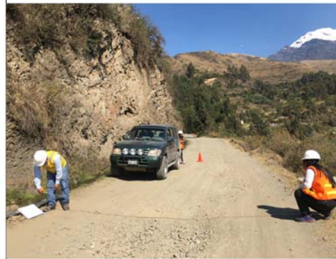
Foto 14: Inventario de fallas , en la KM 77+700 - carretera Vaqueria - Yanama
