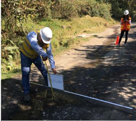
Foto 13: Inventario de fallas , en la KM 77+330 - carretera Vaqueria - Yanama
