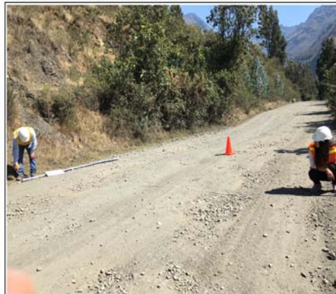
Foto 09: Inventario de fallas , en la KM 75+000 - carretera Vaqueria - Yanama
