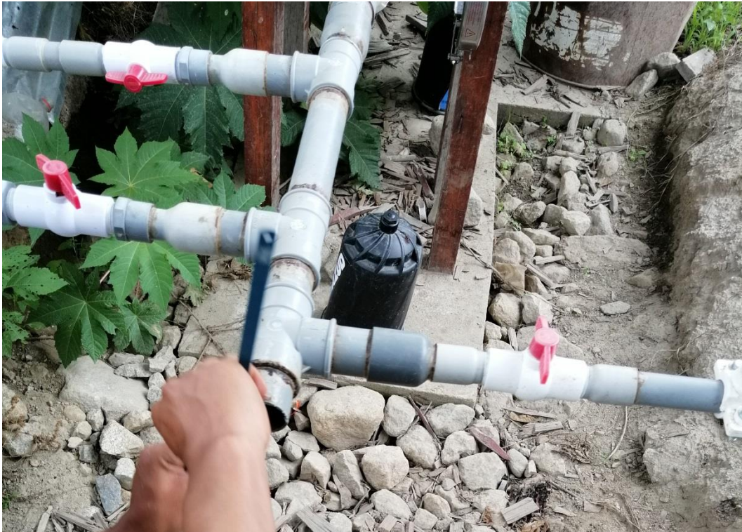
Anexo 9.6. corte de manguera para instalación de emisores.
