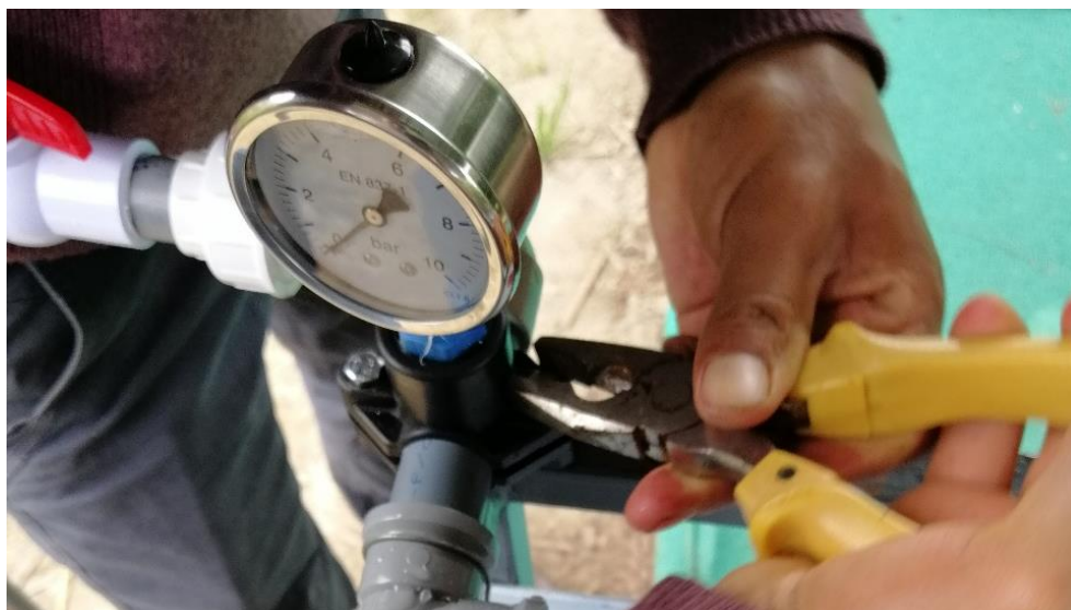
Figura 13: Instalación de manómetro
