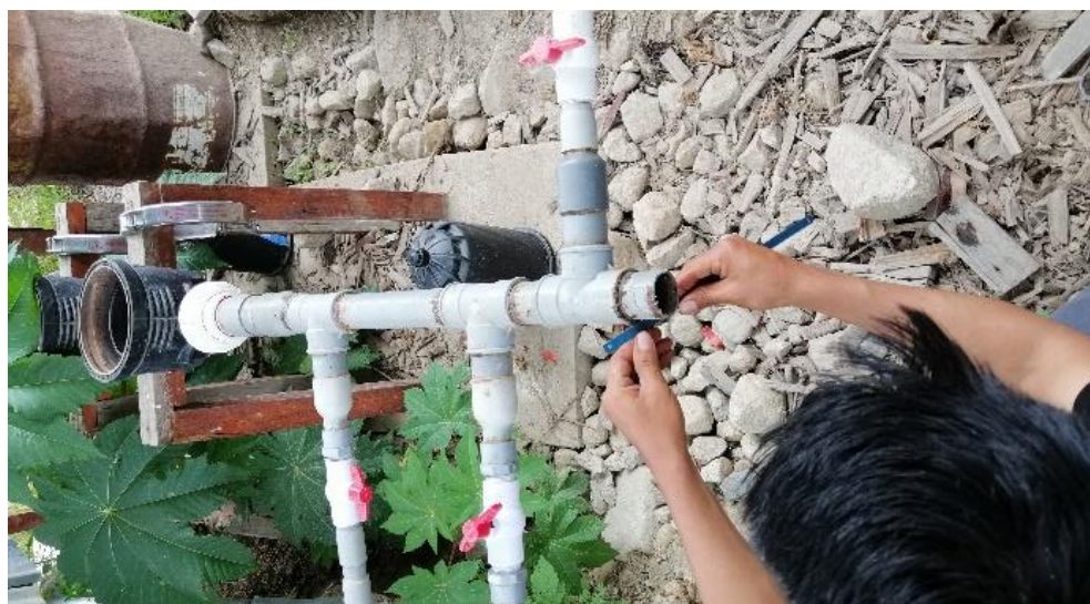
Figura 11: Adecuación de tuberías para el uso en banco de pruebas.
