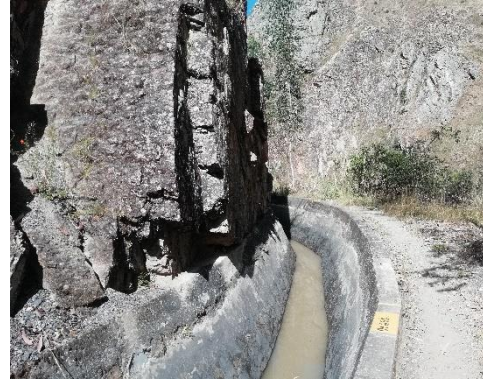
Vista del canal abierto, progresiva 0+690
