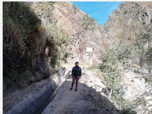
Vista del canal, progresiva 0+200
