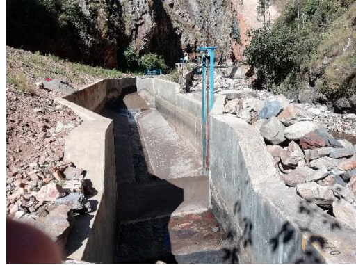
Vista del desarenador progresiva 0+070
