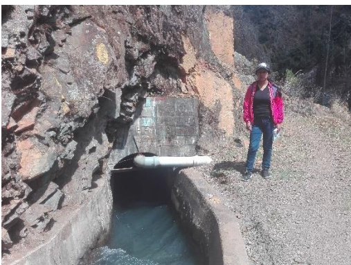
Vista del canal (túnel), progresiva 0+250
