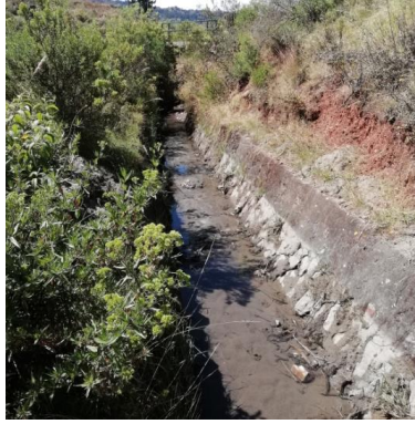
Vista del canal abierto, progresiva 2+450
