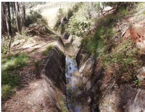
Vista del canal abierto, progresiva 2+800
