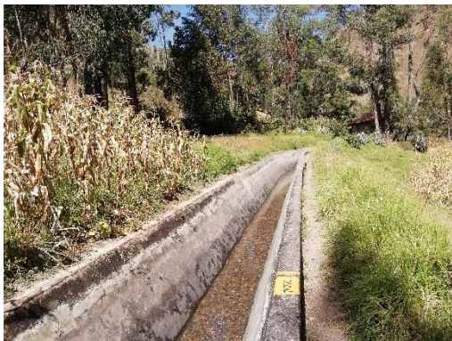
Vista del canal abierto, progresiva 1+070
