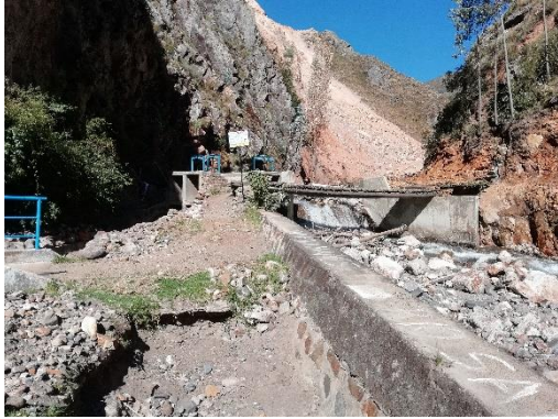
Vista de la captación progresiva 0+000
