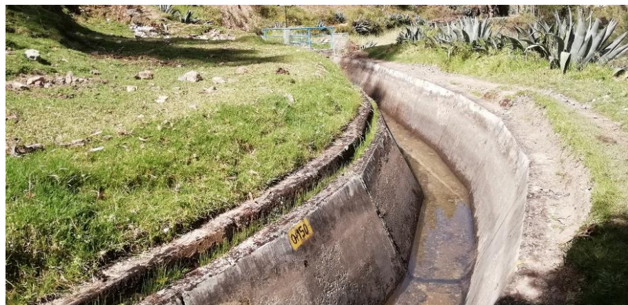
Figura 33. Canal abierto sin cerco de protección. Fuente: Fotografía tomada por Jhuliana Victoria, López Vega (2019)
