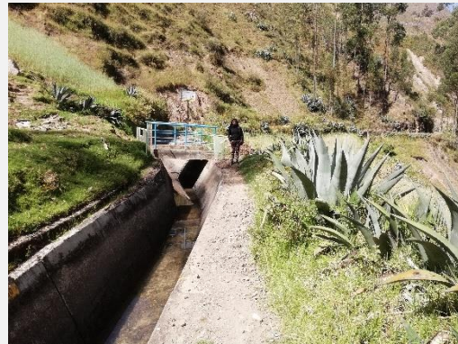
Vista del canal abierto, progresiva 0+970
