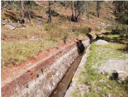
Vista del canal abierto, progresiva 2+150
