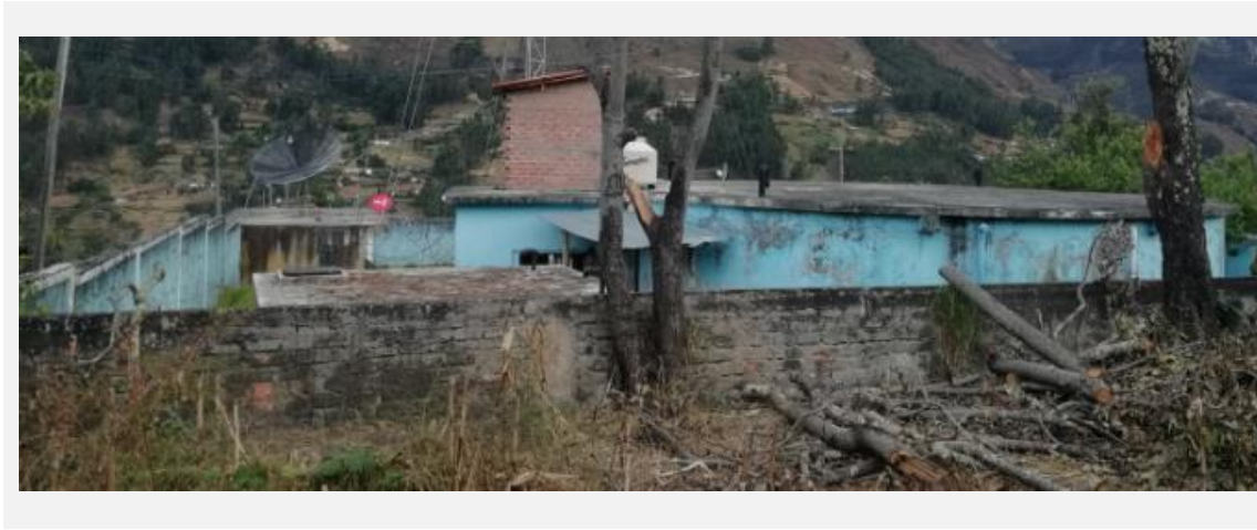
Vista del Reservorio, progresiva 4+500
