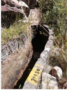
Vista del canal abierto (túnel), progresiva 1+730
