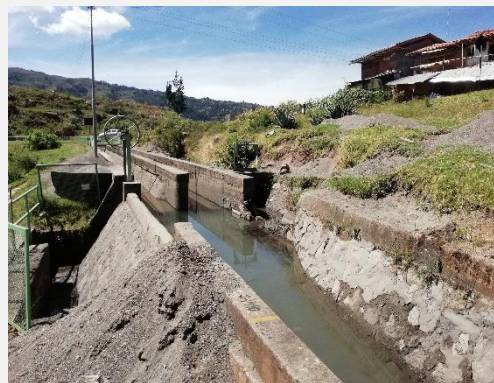
Vista del canal abierto, progresiva 2+410
