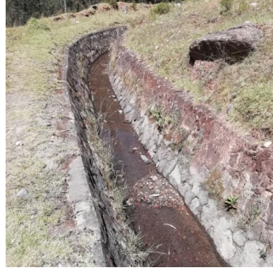
Vista del canal abierto, progresiva 2+480
