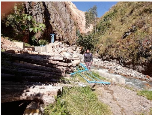
Vista la captación, progresiva 0+090
