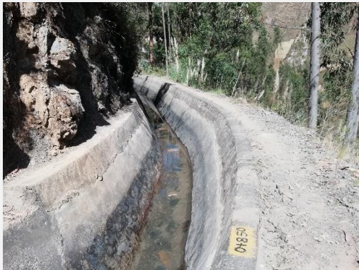
Vista del canal abierto, progresiva 0+850
