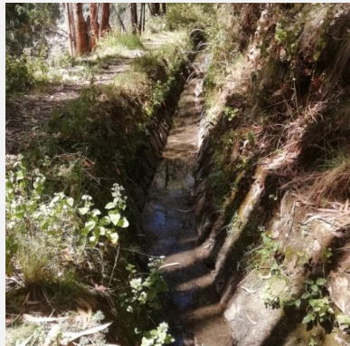
Vista del canal abierto, progresiva 2+800
