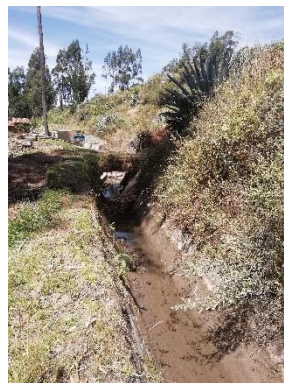
Vista del canal abierto, progresiva 3+000
