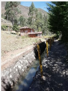
Vista del canal abierto, progresiva 2+350
