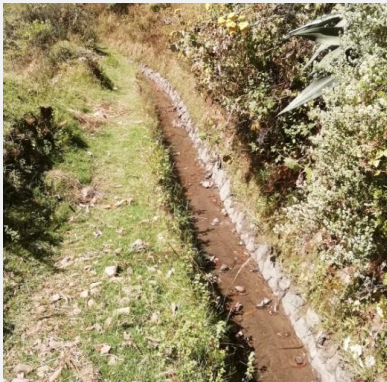
Vista del canal abierto, progresiva 2+540
