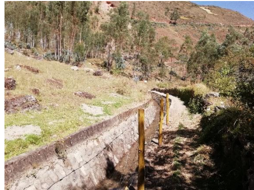
Vista del canal abierto, progresiva 2+250
