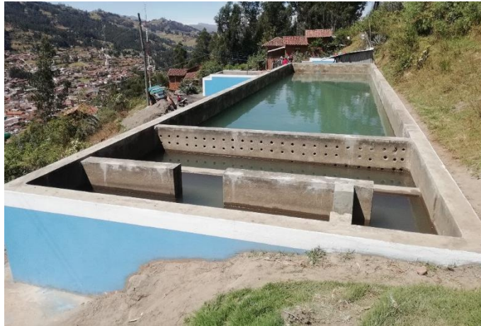
Figura 36. Sedimentador primario.
