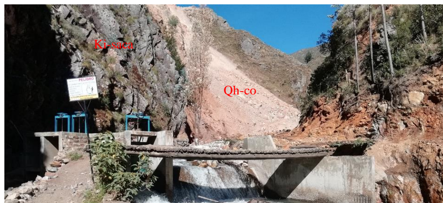
Figura 17. Depósito coluvial aguas arriba de la captación, formación Santa-Carhuaz.
