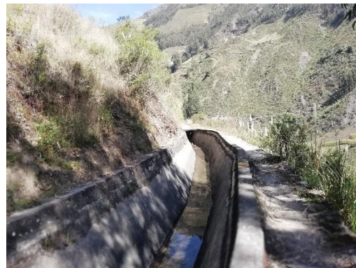
Vista del canal abierto, progresiva 1+450
