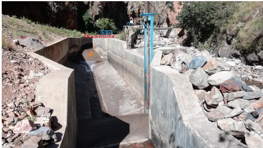
Figura 30. Desarenador
