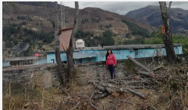
Vista del Reservorio, progresiva 4+500
