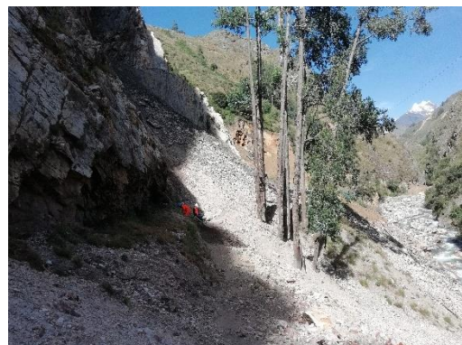
Vista del canal enterrado por el deslizamiento, progresiva 0+450
