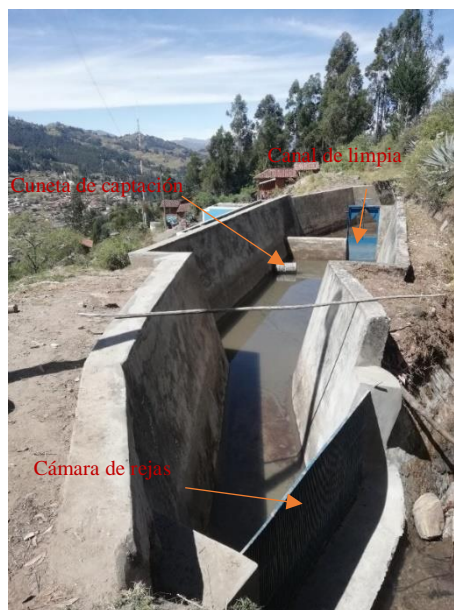
Figura 34. Partidor de caudal.
