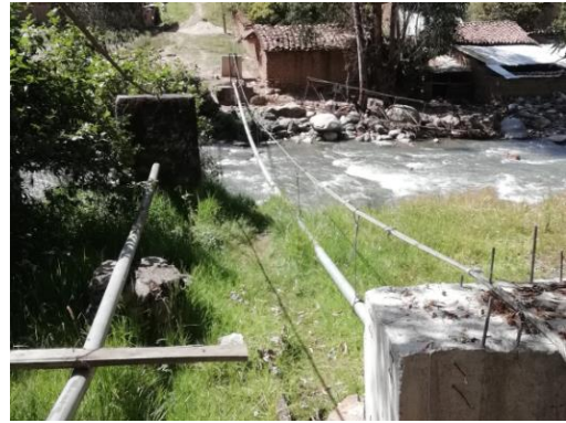
Vista de pase aéreo canal cerrado, progresiva 3+500
