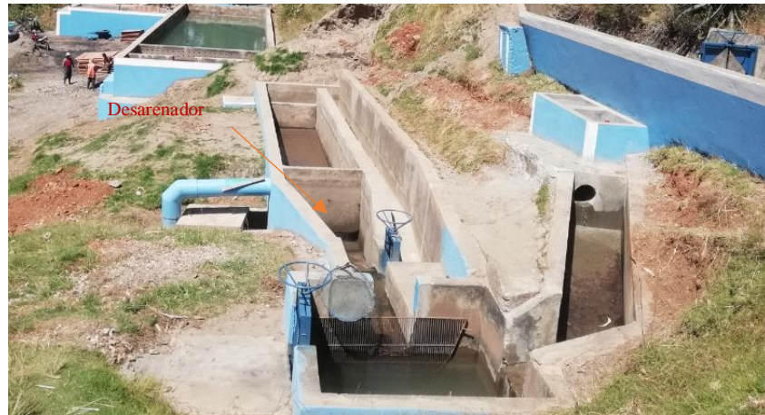
Figura 35. Desarenador.
