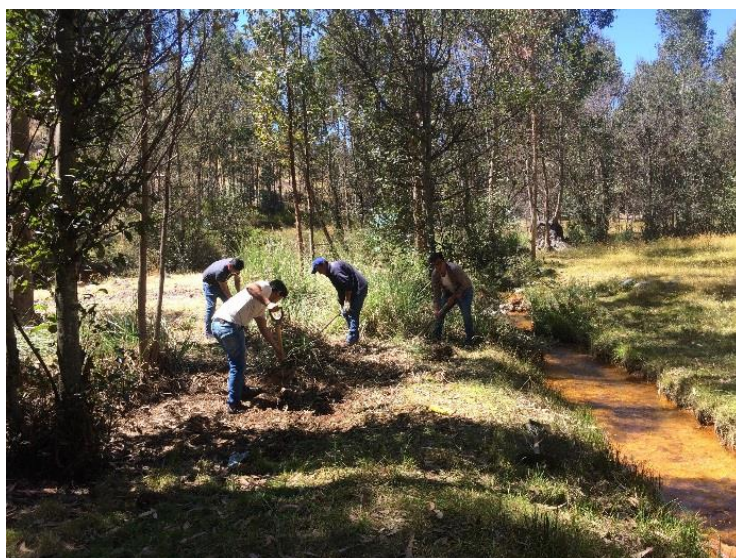
Figura 2: Limpieza y desbroce del terreno
