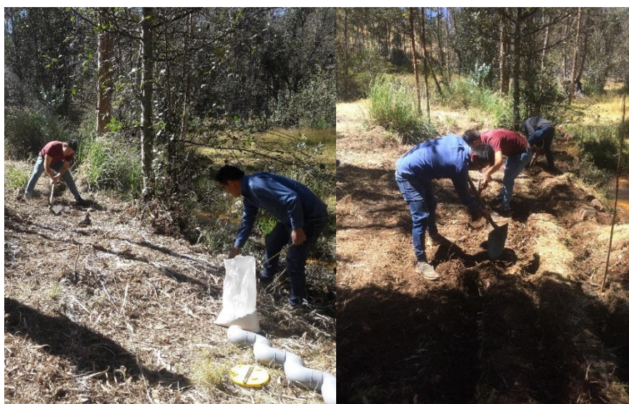
Figura 3: Trazo y excavación manual de zanja
