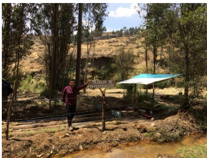
Figura 11: Instalación de cerco de protección con alambre de púas y su respectiva instalación de la cobertura.
