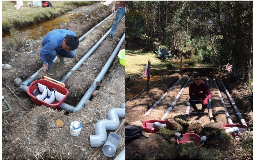
Figura 8: Instalación del desarenador y de los vertederos
