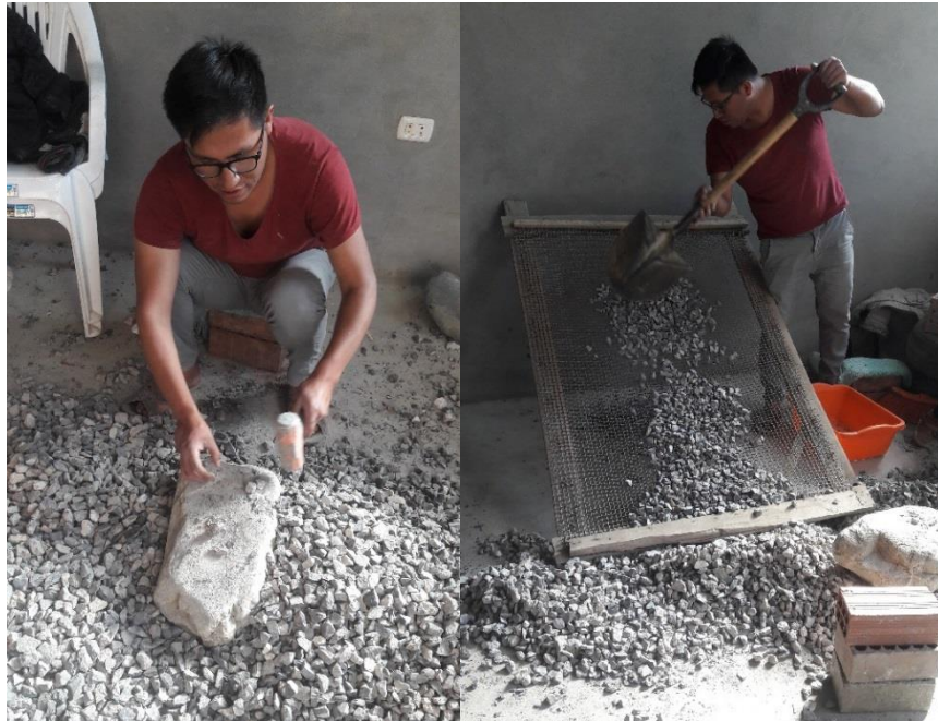
Figura 5: Tamizado y cribado de la caliza
