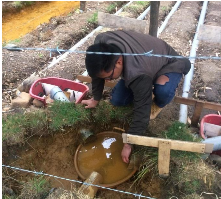
Figura 12: Limpieza de las malezas en las cribas del desarenador
