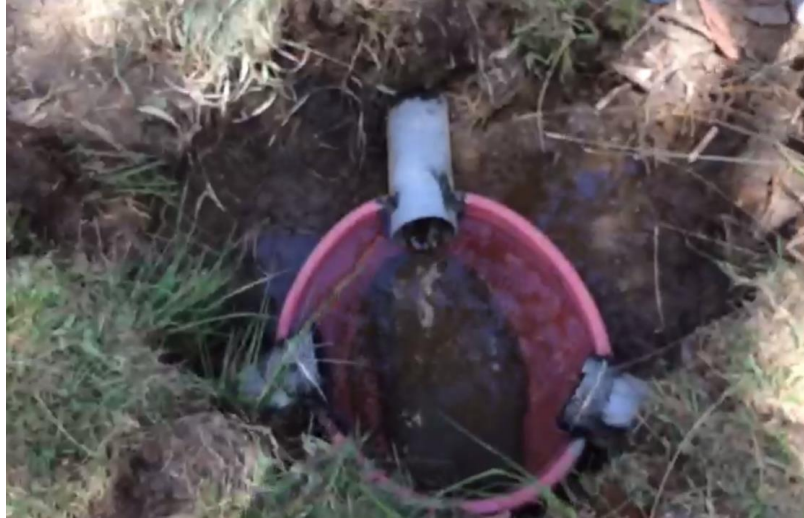
Figura 6: Instalación del sedimentador
