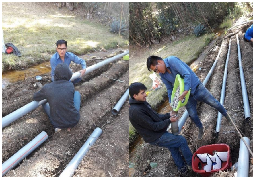
Figura 9: Instalación de canales con material de PVC de 4" de 7.5m y con pendientes constantes de 2%
