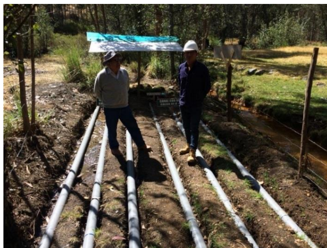
Figura 10: Instalación del sistema de canales con 3 repeticiones de cada uno
