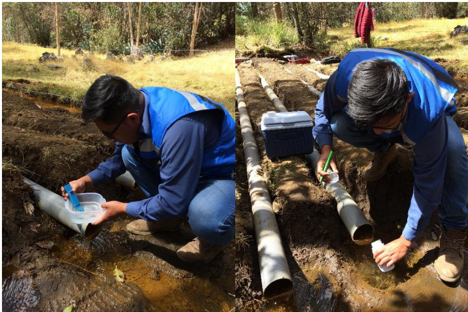
Figura 14: Medición de pH en campo y toma de muestra, a la salida del sistema de canales
