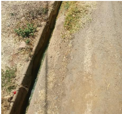
Fotografía 39. Canales en Buen Estado Funcional y Estructural.
