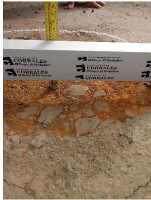
Fotografía 13. Presencia de baches de gravedad 3.
