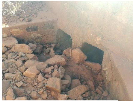
Fotografía 10. Alcantarillas parcialmente obstruidas, pero en buen estado estructural.
