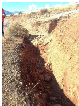
Fotografía 12. Cuneta de tierra parcialmente obstruida, pero en buen estado estructural.
