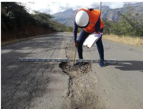
Fotografía 73. Bache de nivel de gravedad 3 en la calzada.
