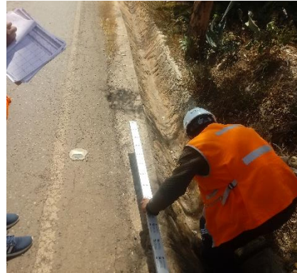
Fotografía 54. Cuneta en buen estado funcional y estructural.
