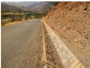
Fotografía 67. Cunetas de mampostería en buen estado estructural y funcional.
