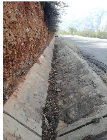
Fotografía 74. Cuneta en buen estado funcional.
