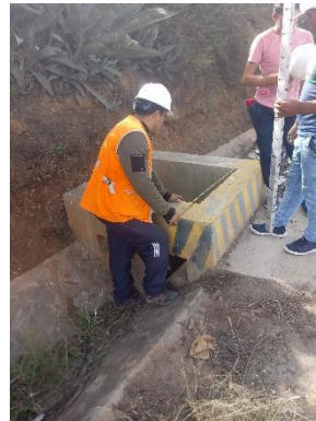
Fotografía 64. Alcantarilla de Paso, en buen estado estructural.
