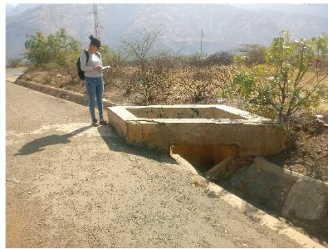
Fotografía 50. Alcantarilla de paso, en buenas condiciones estructural y funcional.
