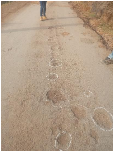
Fotografía 21. Baches de nivel de gravedad 1 y 2.
