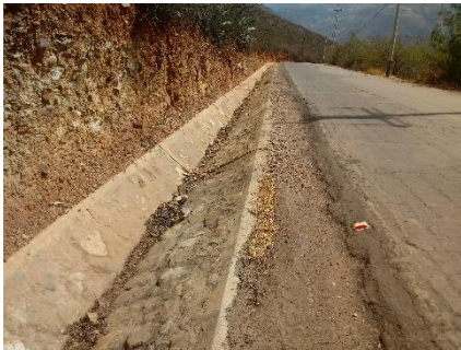
Fotografía 71. Cunetas de mampostería, en buen estado, berma deteriorada.
