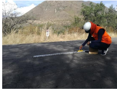
Fotografía 72. Pendiente del tramo km 141+000
