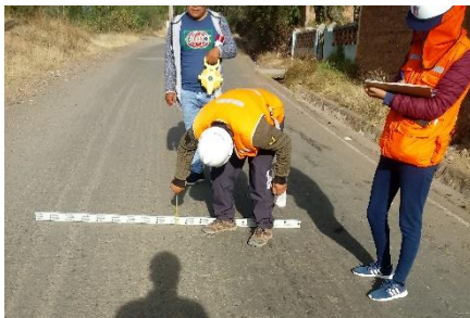
Fotografía 35. Ahuellamiento en la calzada
