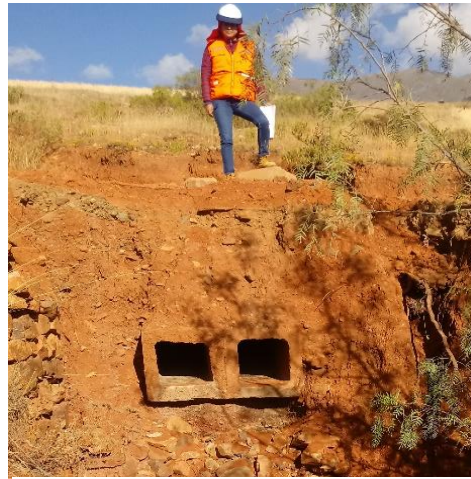
Fotografía 2. Alcantarilla en buen estado estructural, sin daños en su estructura.
