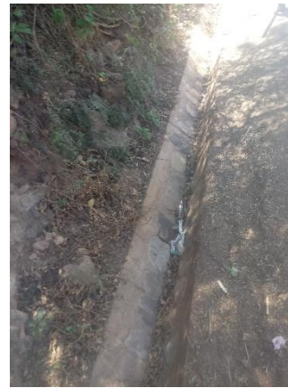
Fotografía 28. Cuneta de mampostería, en condición funcional y estructural buena.
