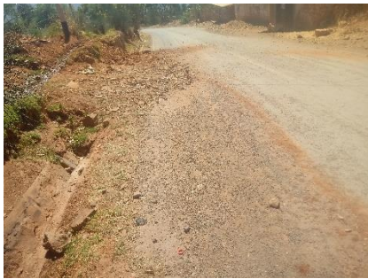
Fotografía 27. Cuneta interrumpida por los pobladores al generar un acceso en ese tramo.
