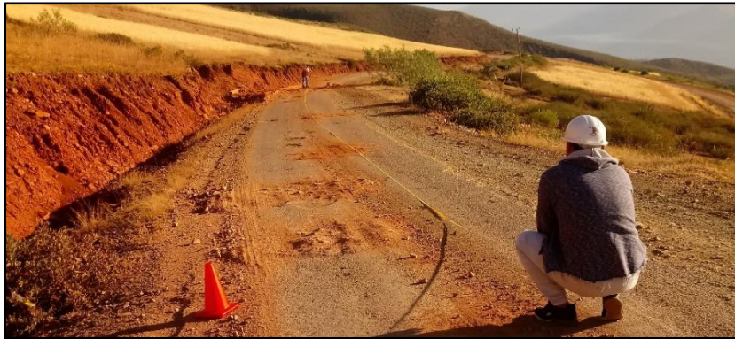
Figura 14. Delimitación de los Primeros 50 m de la Vía En la figura se muestra la delimitación con una wincha de 50 metros efectuada por 2 personas en la vía de estudio.
