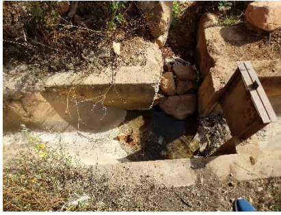
Fotografía 37. Disipador de energía, en buen estado funcional y estructural.
