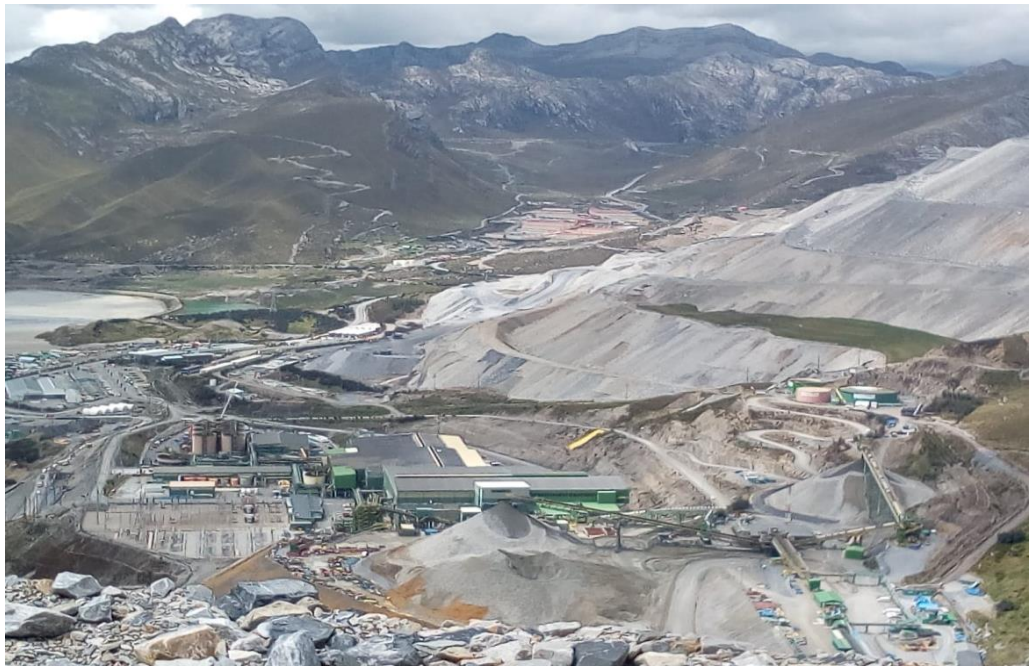
Figura N° 19: Planta concentradora y chancadora primaria Fuente: concentradora Antamina
