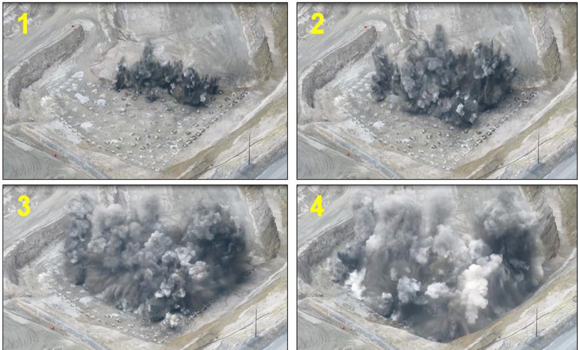
Figura N° 32: Secuencia de la voladura de rocas.
