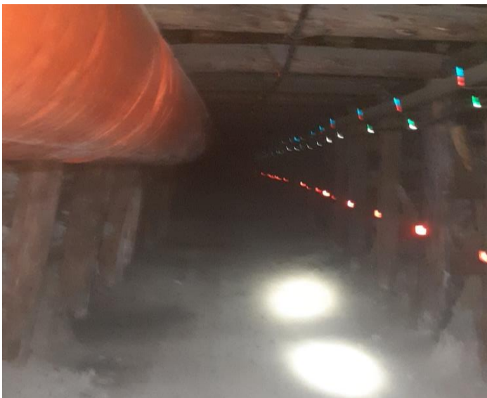
Fuente: MYGABY S.A.C, señalización, sistema de ventilación y cuadros de seguridad en la entrada de mina.
