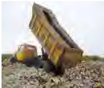
Arrojo de desmonte
