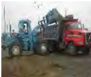
Eliminación de desmonte
