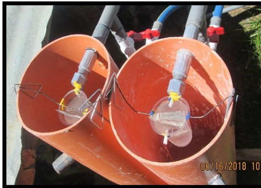
Fotografía 3.14 Desarenador a escala instalado en prototipo
