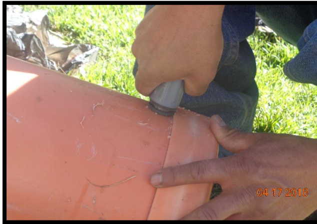
Fotografía 3.25 Instalación de los niples
