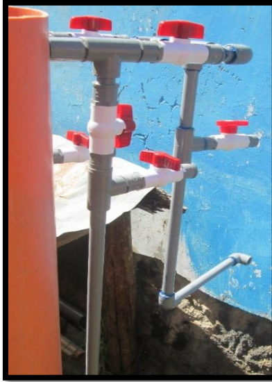
Fotografía 3.30 Instalación del prototipo de filtro lento
