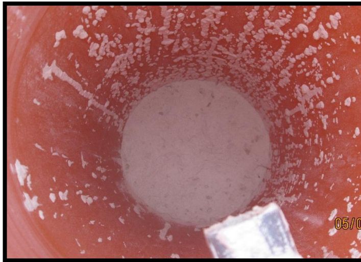
Fotografía 3.42 Instalación de la concha de abanico
