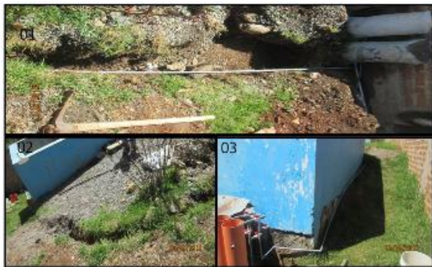
Fotografía 3.12 Conducción de agua cruda
