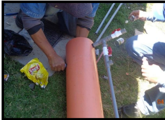
Fotografía 3.27 Punto de ingreso al prototipo de filtro lento
