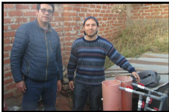
Fotografía 3.31 Asesoría durante el proceso de instalación
