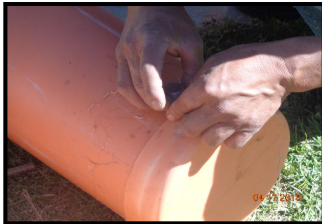
Fotografía 3.24 Punto de salida de agua filtrada
