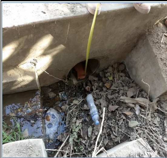
Foto N° 161 22+898 Tajea de tubería PVC 12", bueno
