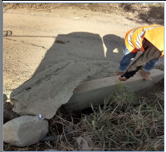
Foto N° 182 25+575 Alcantarilla concreto armado 0.60x0.50m, regular
