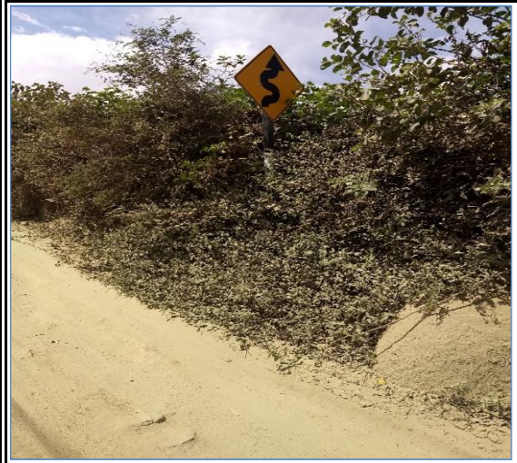
Foto N° 164 23+333 Señal preventiva lado derecho, bueno
