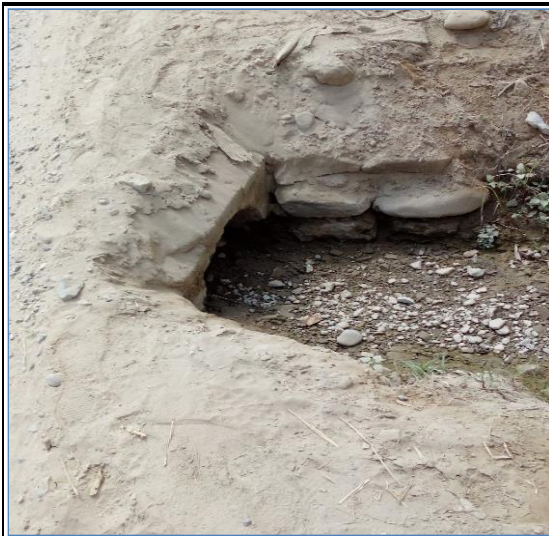
Foto N° 45 5+106 Alcantarilla TMC 24", regular
