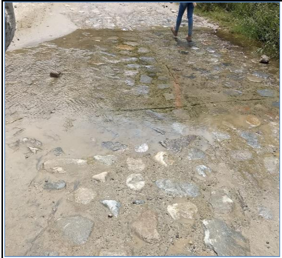
Foto N° 142 19+350 Baden de mamposteria 13.0x5.10m, bueno
