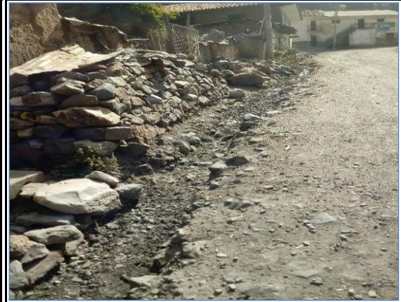
Foto N° 2 0+009 Inicio de cuneta lado izquierdo, regular
