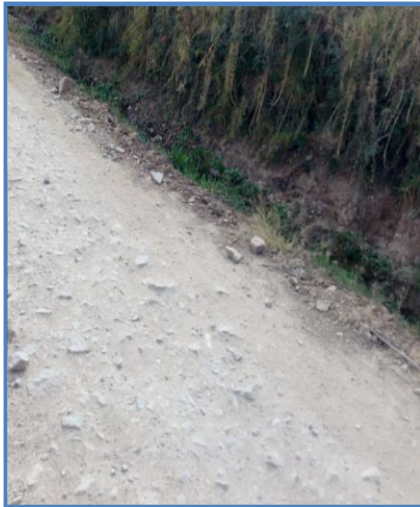
Foto N° 33 1+693 Fin de cuneta lado derecho; inicio de cuneta lado izquierdo, regular
