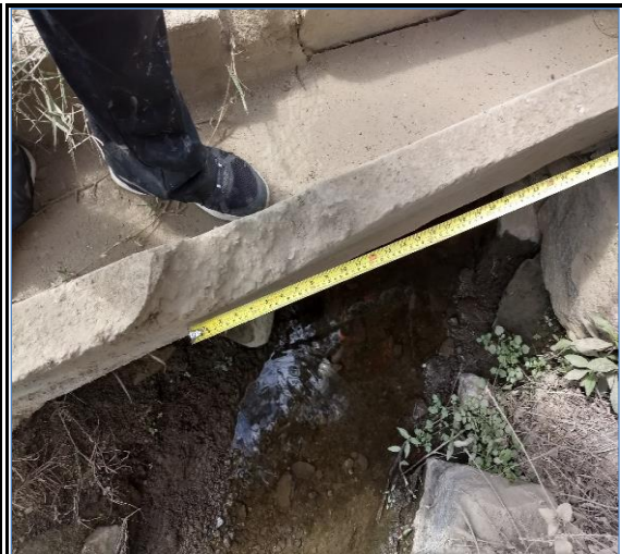
Foto N° 126 17+140 Alcantarilla de concreto armado 0.90x0.80m, bueno
