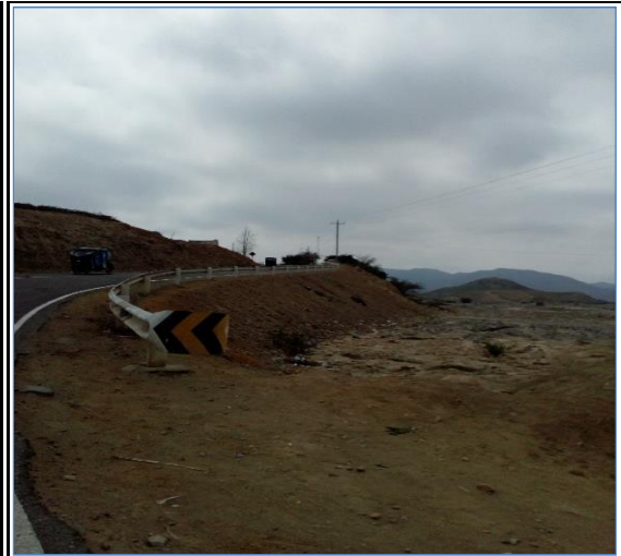
Foto N° 20 1+410 Inicio de guardavias lado derecho, bueno
