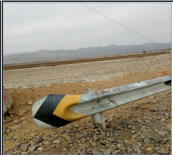
Foto N° 22 1+509 Fin de guardavias lado derecho, bueno
