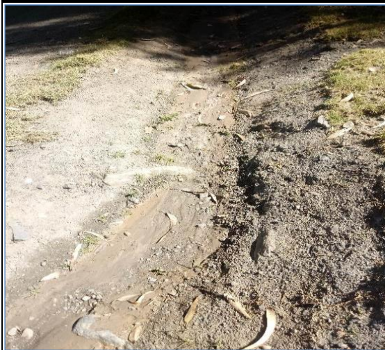
Foto N° 15 0+585 Inicio de cuneta lado derecho, regular
