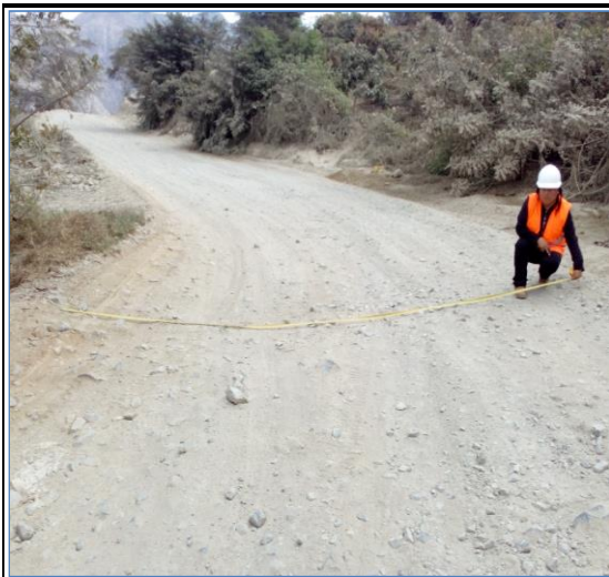
Foto N° 39 4+500 Punto de control
