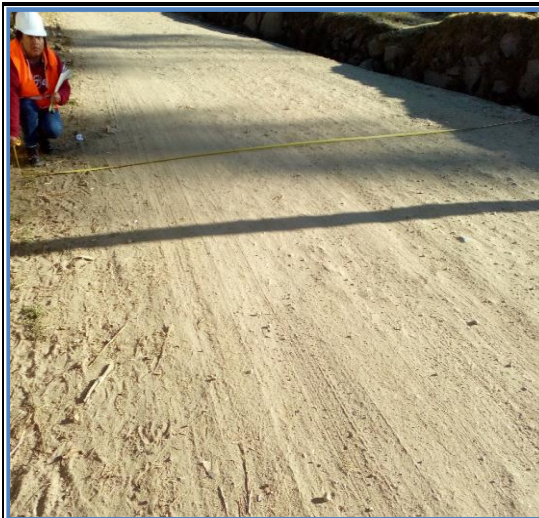
Foto N° 23 4+000 Punto de control Km 4+000
