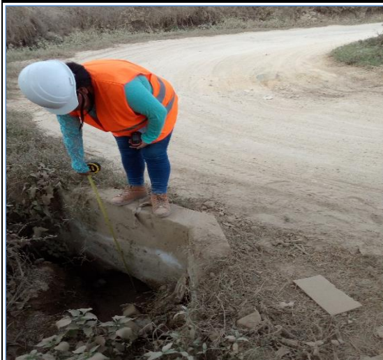
Foto N° 111 15+012 Alcantarilla TMC 36", regular
