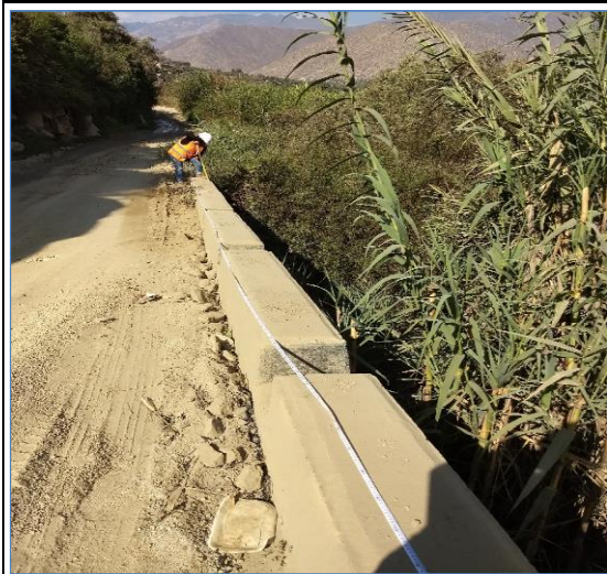
Foto N° 159 22+408 Muro de concreto ciclopeo 16.70x3.40x0.30m, bueno
