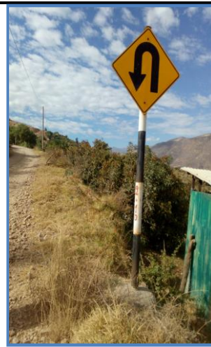
Foto N° 36 2+015 Señal preventiva lado derecho, bueno
