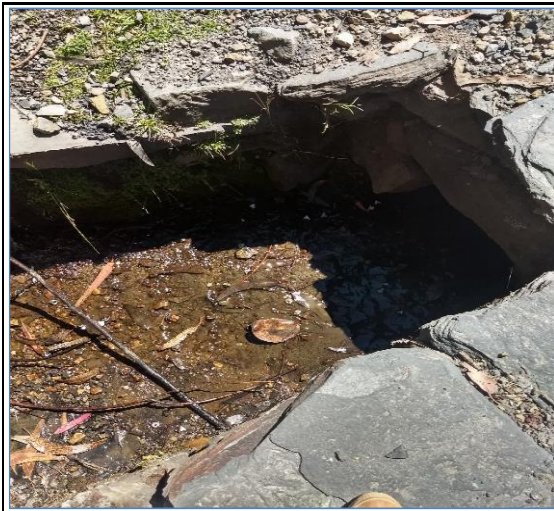
Foto N° 49 3+516 Tajea de piedra 0.50x0.30m, regular
