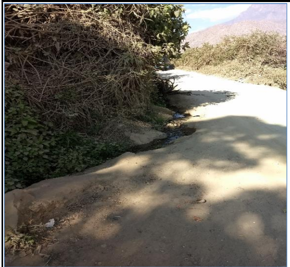
Foto N° 162 22+898 Inicio de cuneta lado izquierdo, regular
