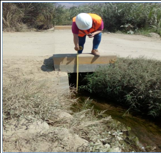
Foto N° 67 8+495 Alcantarilla concreto armado 0.70x0.50m, regular
