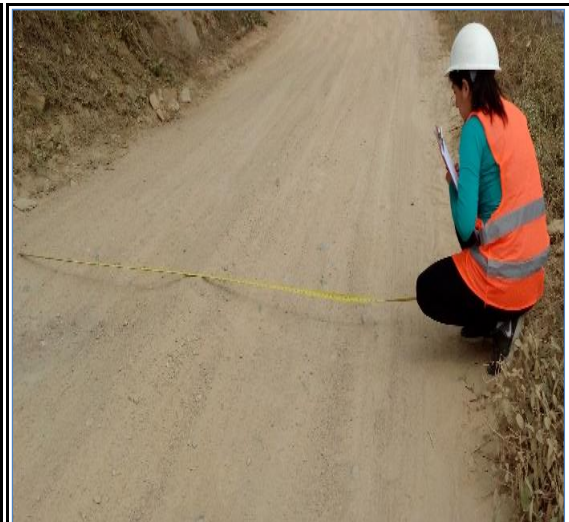
Foto N° 110 15+000 Punto de control
