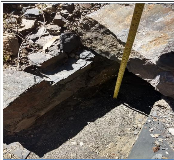
Foto N° 37 2+647 Tajea de piedra 0.40x0.30m, regular
