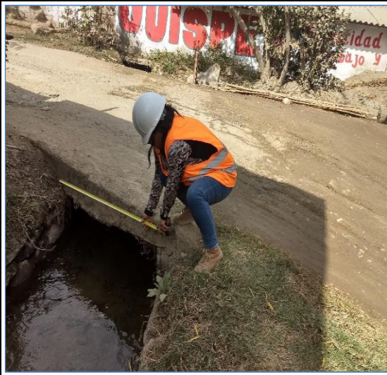
Foto N° 127 17+438 Alcantarilla de concreto armado 1.10x0.50m, bueno
