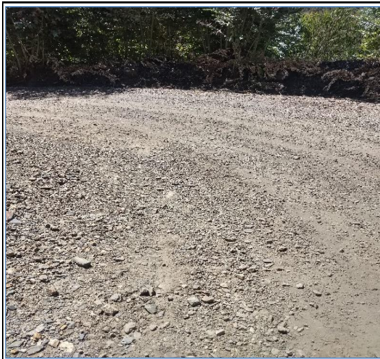
Foto N° 43 3+016 Inicio de cuneta lado derecho, regular
