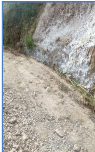
Foto N° 15 0+639 Inicio de cuneta lado derecho, regular
