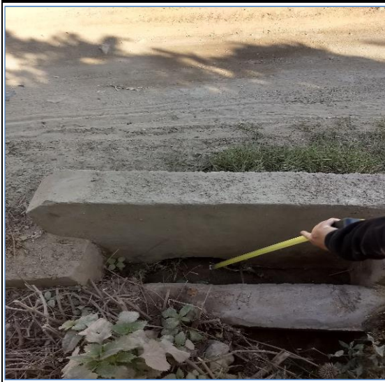
Foto N° 177 24+935 Alcantarilla TMC 24", regular
