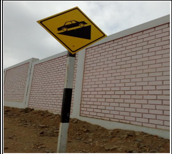
Foto N° 8 0+751 Señal preventiva lado derecho, bueno
