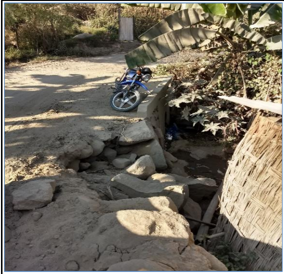
Foto N° 176 24+856 Alcantarilla doble TMC 24", bueno
