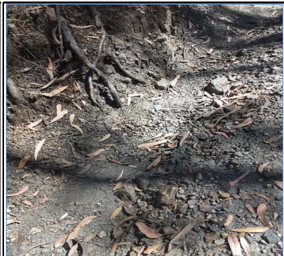
Foto N° 36 2+507 Inicio de cuneta lado izquierdo, regular
