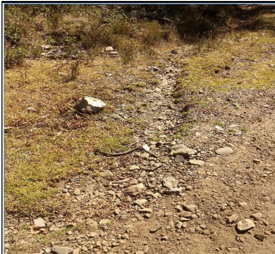
Foto N° 63 4+108 Inicio de cuneta lado izquierdo, regular
