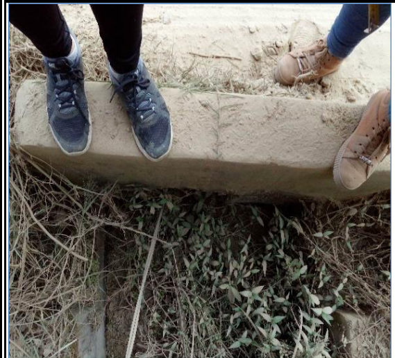
Foto N° 112 15+102 Alcantarilla TMC 24", regular
