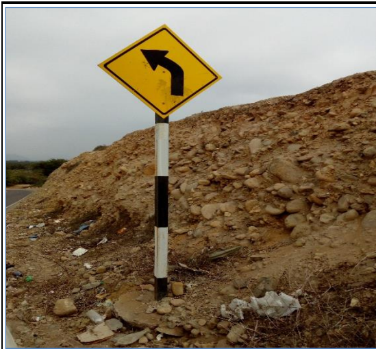
Foto N° 21 1+486 Señal preventiva lado izquierdo, bueno
