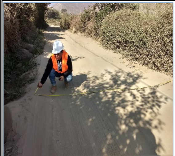
Foto N° 166 23+500 Punto de control
