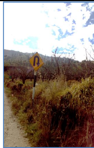
Foto N° 46 2+729 Señal preventiva lado derecho, bueno
