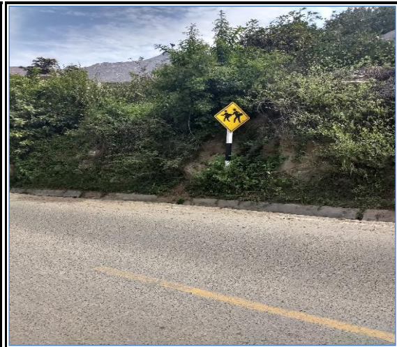
Foto N° 190 26+073 Señal preventiva lado izquierdo, bueno
