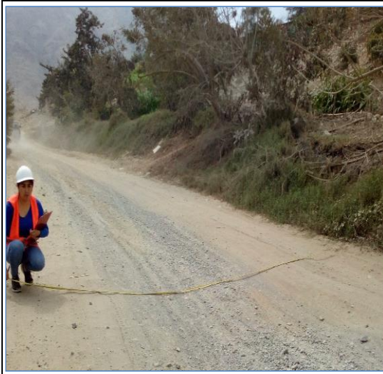
Foto N° 43 5+000 Punto de control
