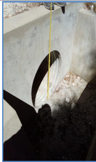
Foto N° 8 1+090 Alcantarilla TMC 36", bueno
