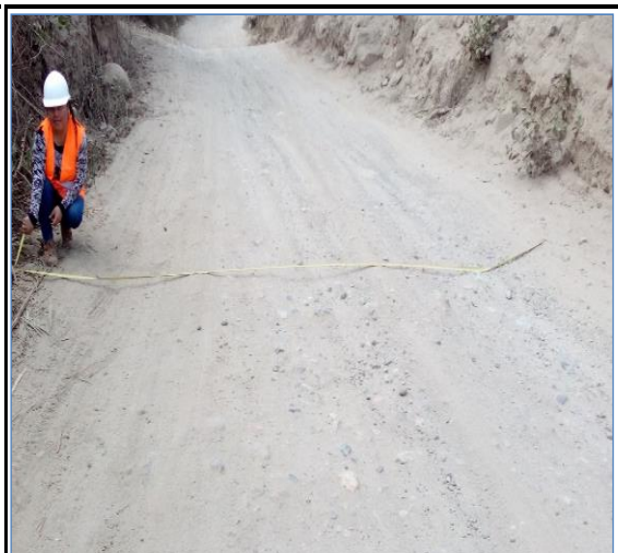
Foto N° 120 16+500 Punto de control
