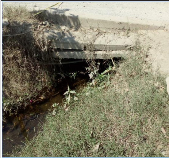
Foto N° 61 7+498 Alcantarilla concreto armado 1.50x0.70m, regular
