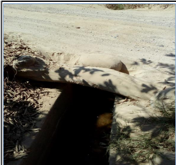
Foto N° 90 11+624 Tajea de concreto armado 0.50x0.50m, regular
