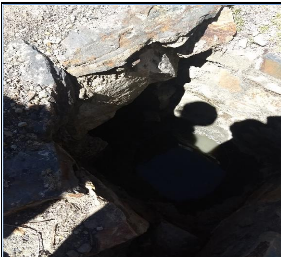
Foto N° 41 2+965 Tajea de piedra 0.60x0.30m, regular
