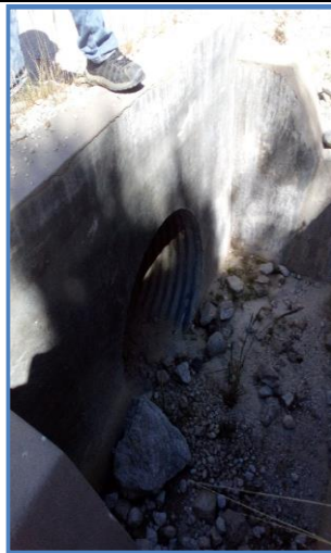
Foto N° 9 1+132 Alcantarilla TMC 36", bueno
