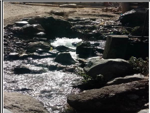
Foto N° 6 0+261 Alcantarilla TMC 36", regular
