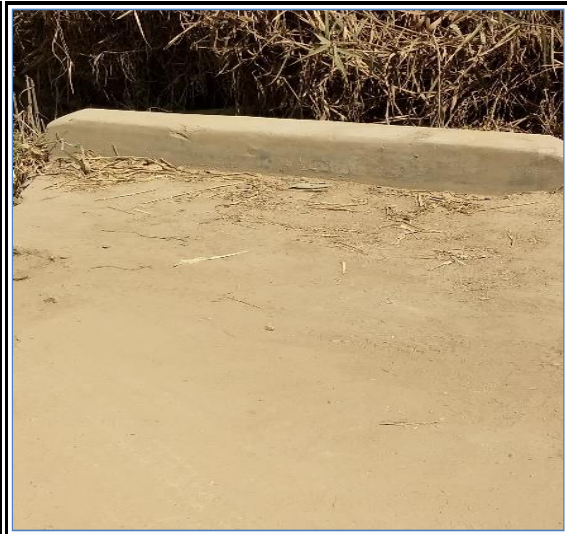
Foto N° 100 13+409 Alcantarilla de concreto armado 0.80x0.60m, regular
