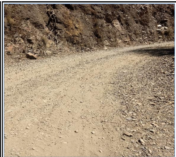
Foto N° 40 2+824 Inicio de cuneta lado izquierdo, regular
