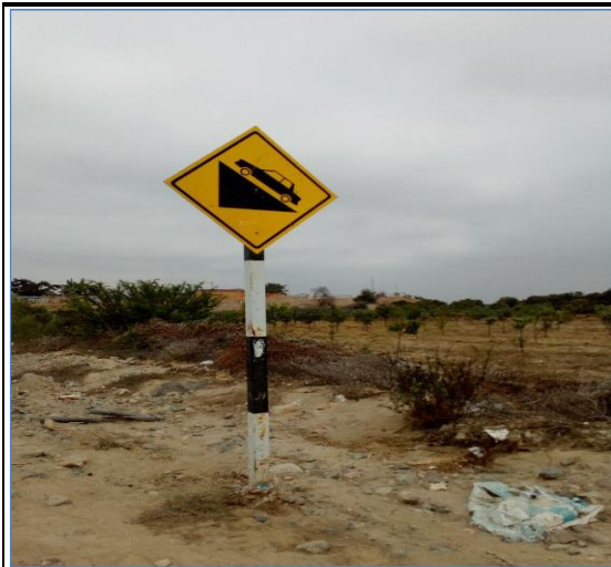
Foto N° 15 1+029 Señal preventiva lado izquierdo, bueno
