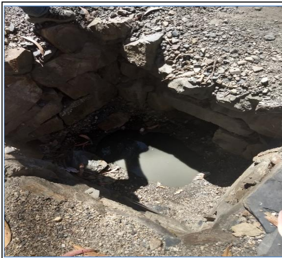
Foto N° 31 2+217 Tajea de piedra 0.50x0.60m, regular
