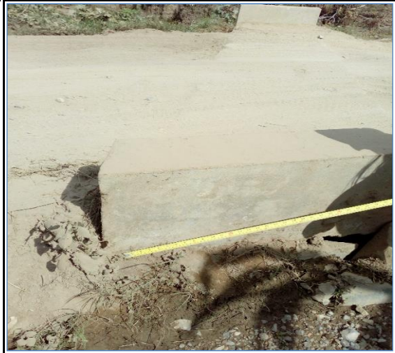
Foto N° 116 15+708 Alcantarilla de concreto armado 0.60x0.50m, regular
