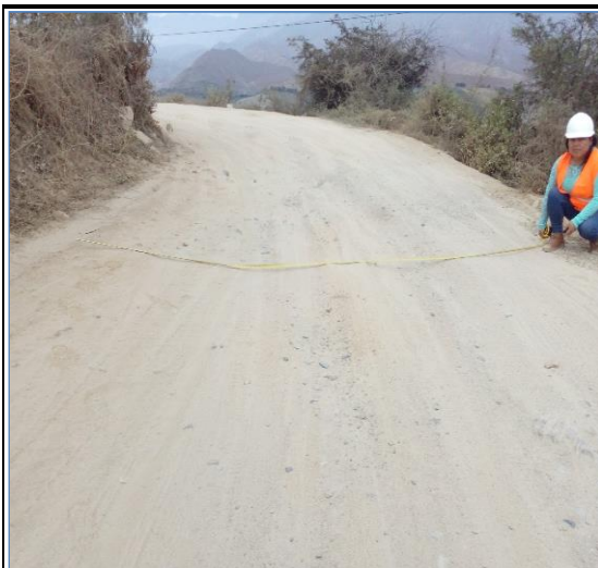
Foto N° 107 14+500 Punto de control
