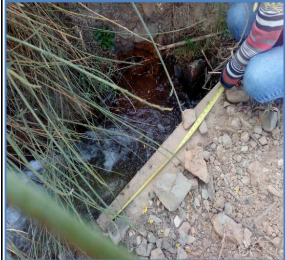
Foto N° 34 1+957 Tajea de concreto ciclópeo 0.60mx0.30m, bueno
