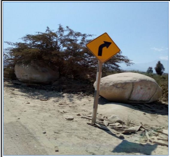
Foto N° 80 10+043 Señal preventiva lado derecho, bueno
