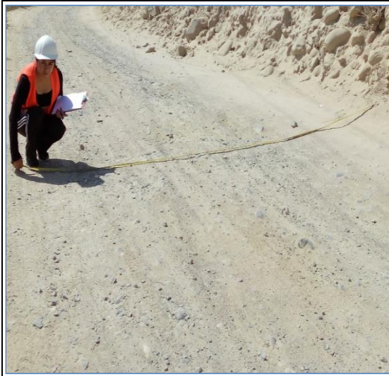
Foto N° 85 11+000 Punto de control
