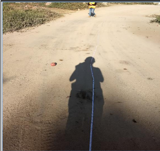
Foto N° 183 25+669 Baden de mamposteria 12.50x6.00m, bueno
