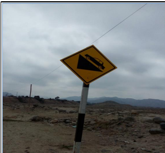
Foto N° 17 1+224 Señal preventiva lado derecho, bueno
