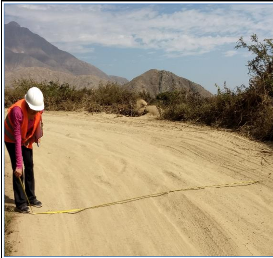
Foto N° 139 19+000 Punto de control
