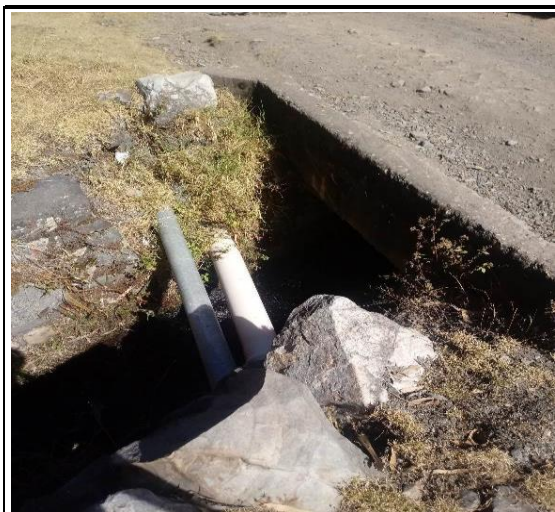
Foto N° 11 0+506 Alcantarilla de concreto ciclopeo 1.20x1.00m, regular
