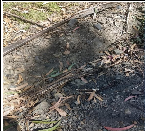
Foto N° 28 1+938 Inicio de cuneta lado izquierdo, regular
