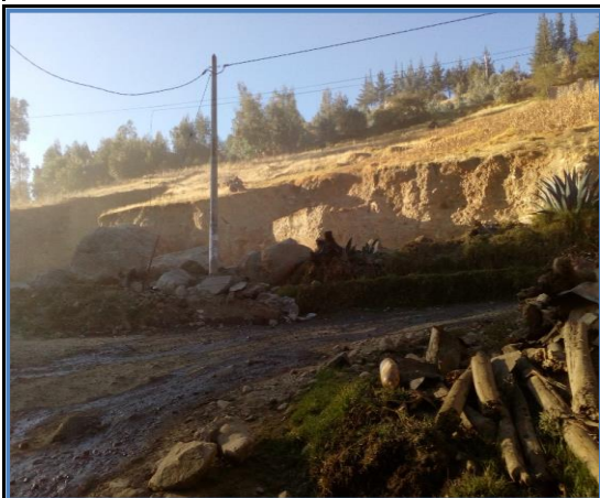
Foto N° 6 1+483 Desvío a Shancayan lado derecho
