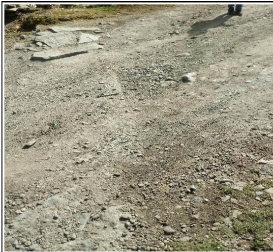
Foto N° 7 0+364 Tajea de concreto 0.50x0.50m, regular
