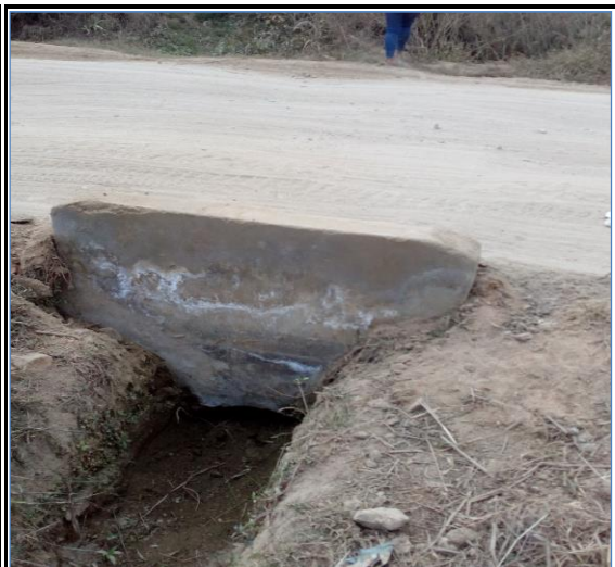
Foto N° 108 14+732 Alcantarilla TMC 24", regular
