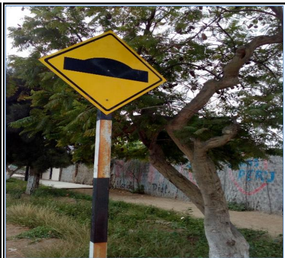
Foto N° 24 1+558 Señal preventiva lado derecho, bueno
