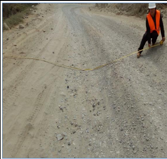
Foto N° 49 5+500 Punto de control
