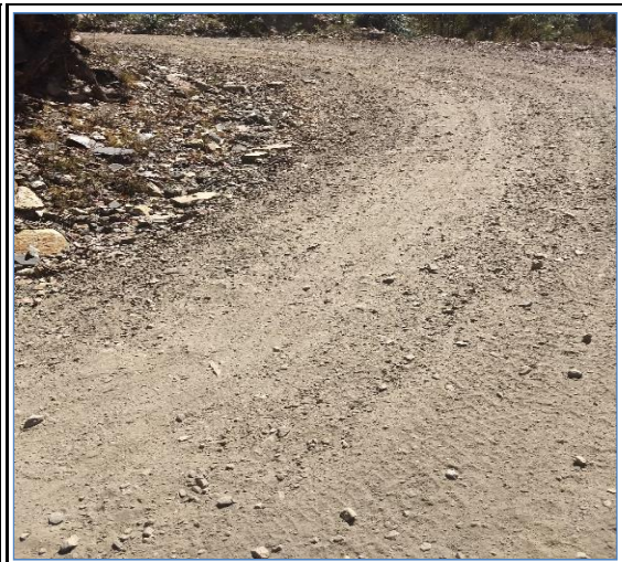
Foto N° 32 2+277 Inicio de cuneta lado derecho, regular
