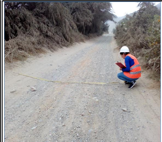
Foto N° 36 3+500 Punto de control
