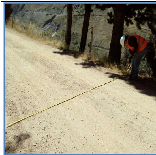
Foto N° 7 1+000 Punto de control Km 1+000
