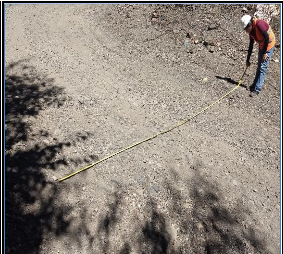
Foto N° 24 1+500 Punto de control
