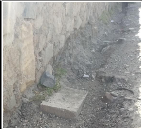
Foto N° 8 0+364 Inicio de cuneta lado izquierdo, regular
