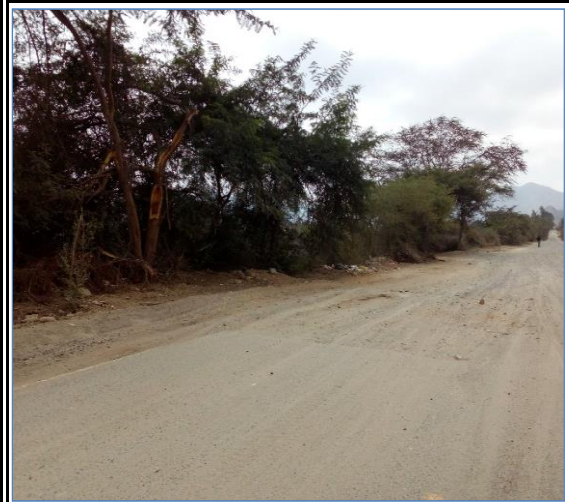
Foto N° 34 2+503 Fin de pavimento flexible, punto de inicio de tramo evaluado
