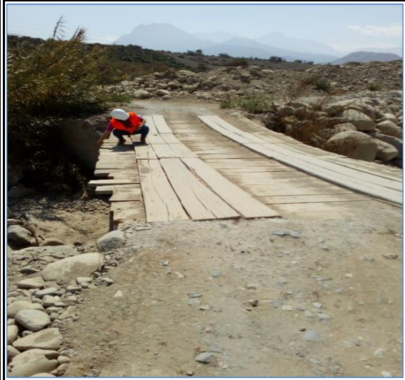
Foto N° 86 11+056 Ponton 9.40x3.4x3.0m, bueno
