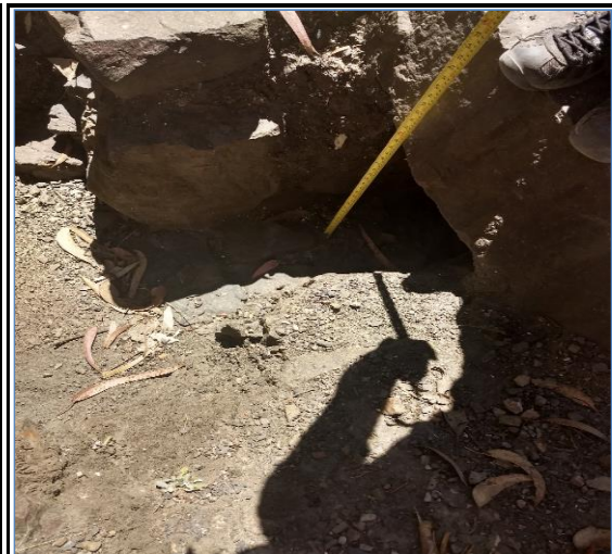
Foto N° 30 2+032 Tajea de piedra 0.80x0.60m, regular
