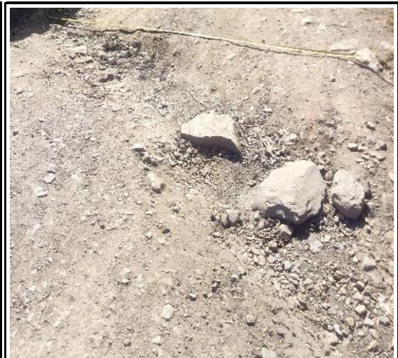
Foto N° 10 0+500 Punto de control
