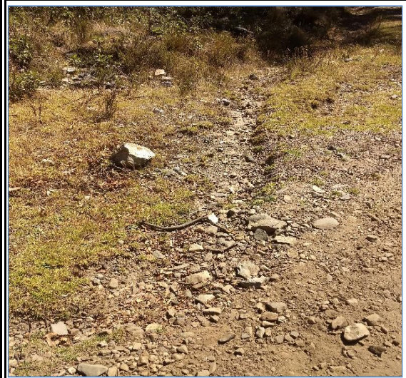
Foto N° 56 3+854 Inicio de cuneta lado izquierdo, regular
