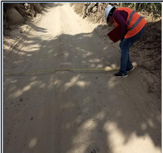
Foto N° 150 20+500 Punto de control
