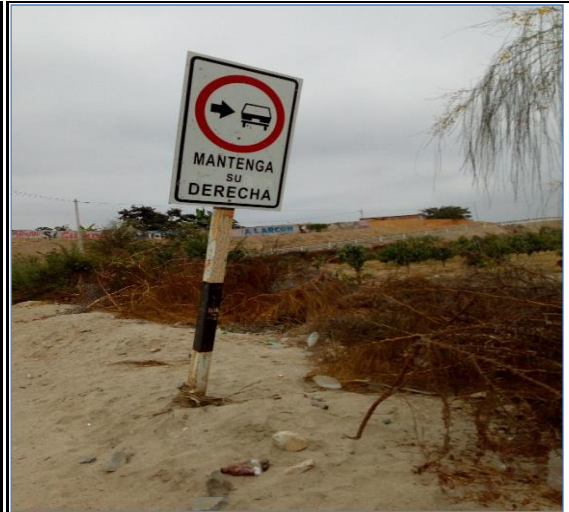
Foto N° 14 0+969 Señal reglamentaria lado izquierdo, bueno
