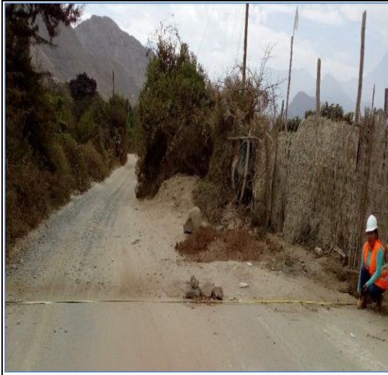
Foto N° 97 13+010 Fin de pavimento flexible
