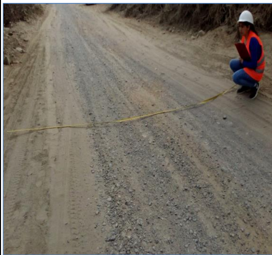
Foto N° 51 6+000 Punto de control
