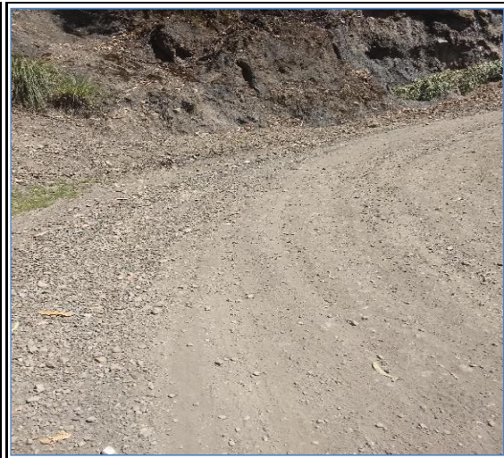
Foto N° 26 1+751 Inicio de cuneta lado izquierdo, regular
