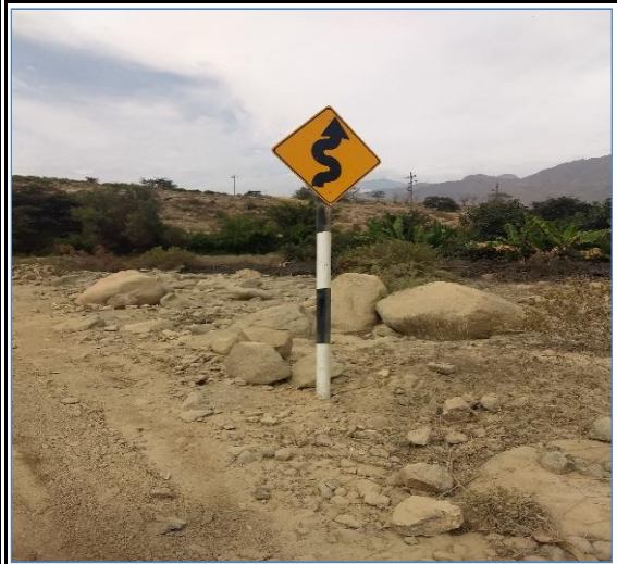
Foto N° 104 14+095 Señal preventiva lado derecho, bueno
