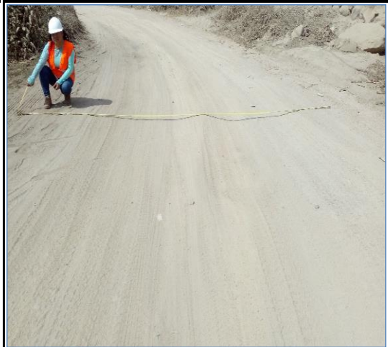
Foto N° 118 16+000 Punto de control
