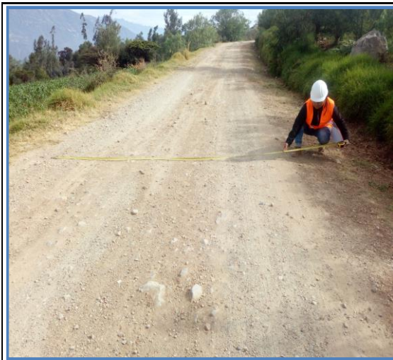
Foto N° 31 1+500 Punto de control Km 1+500
