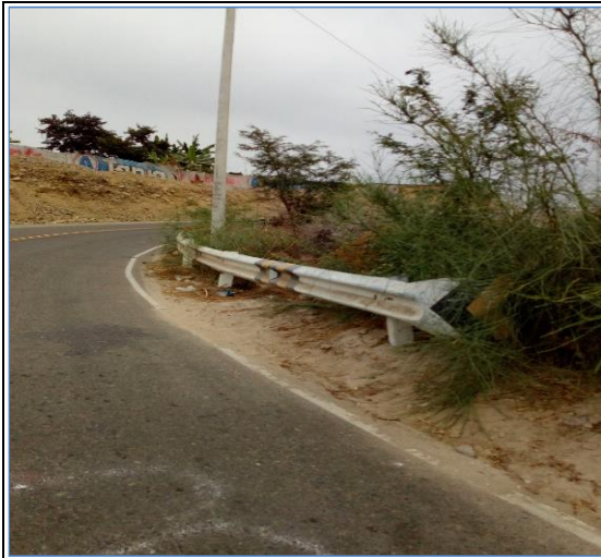
Foto N° 13 0+938 Fin de guardavías, bueno
