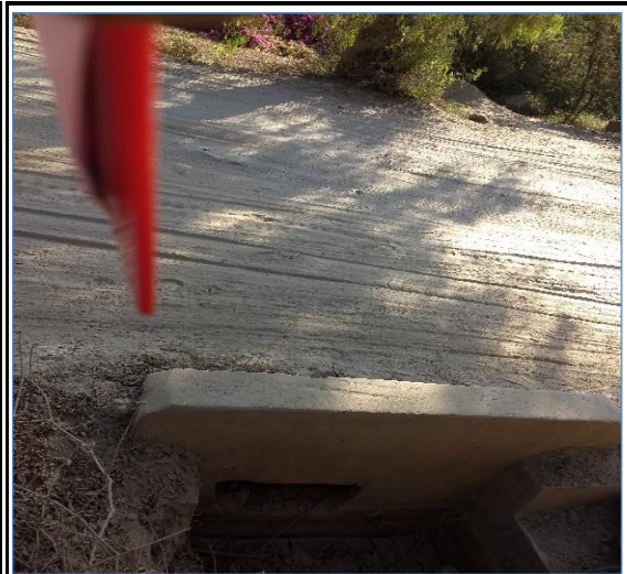
Foto N° 184 25+752 Tajea de piedra 0.40*0.30m, regular
