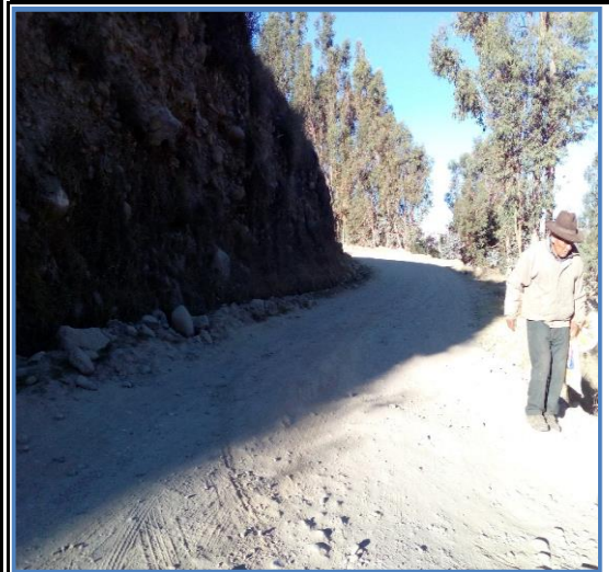
Foto N° 12 2+716 Desvío a Huanchac lado derecho
