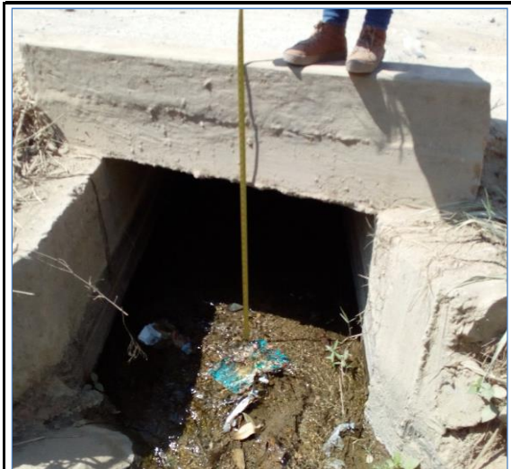
Foto N° 78 9+996 Alcantarilla concreto armado 1.20x0.70m, regular
