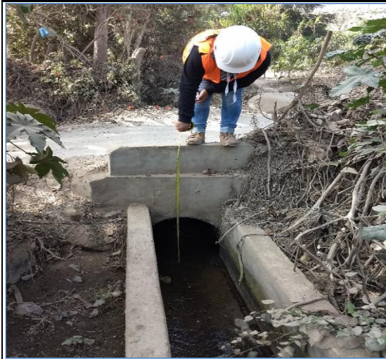
Foto N° 151 20+540 Alcantarilla de concreto armado 0.50x0.40m, bueno
