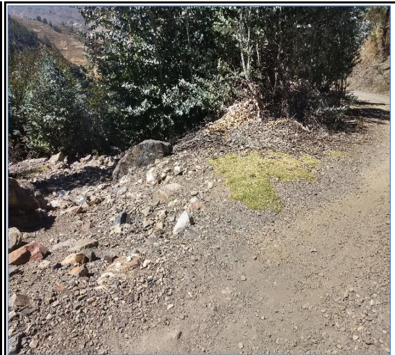
Foto N° 38 2+749 Desvio camino de herradura
