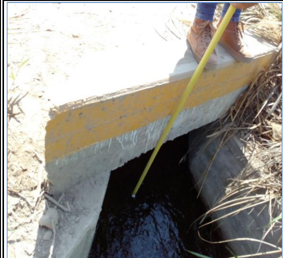
Foto N° 70 8+774 Alcantarilla concreto armado 0.90x0.60m, bueno
