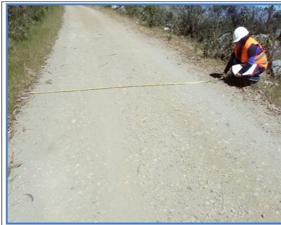
Foto N° 25 4+000 Punto de control Km 4+000
