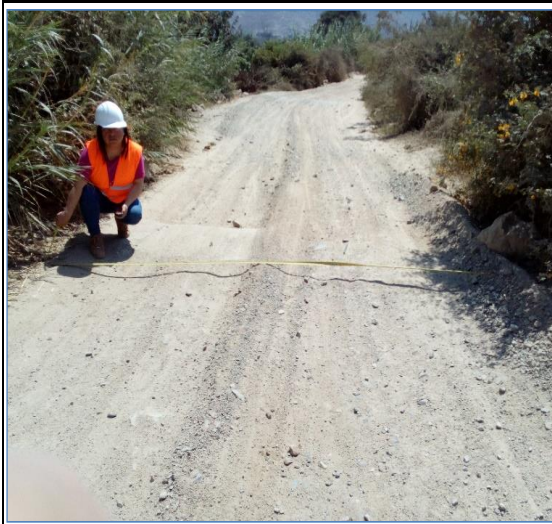
Foto N° 79 10+000 Punto de control
