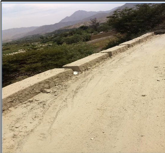
Foto N° 155 21+098 Muro de concreto ciclopeo 15.00x2.80x0.30m, bueno
