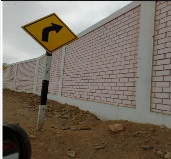
Foto N° 7 0+742 Señal preventiva lado derecho, bueno
