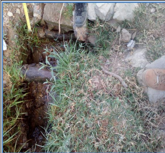
Foto N° 17 0+715 Tajea de piedra 0.50mx0.40m, bueno
