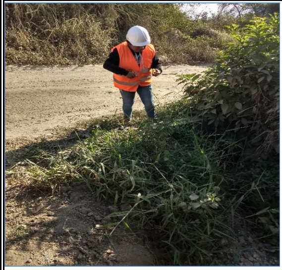
Foto N° 170 24+033 Tajea de piedra 0.40x0.30m, regular
