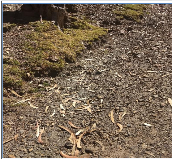
Foto N° 25 1+701 Inicio de cuneta lado derecho, regular
