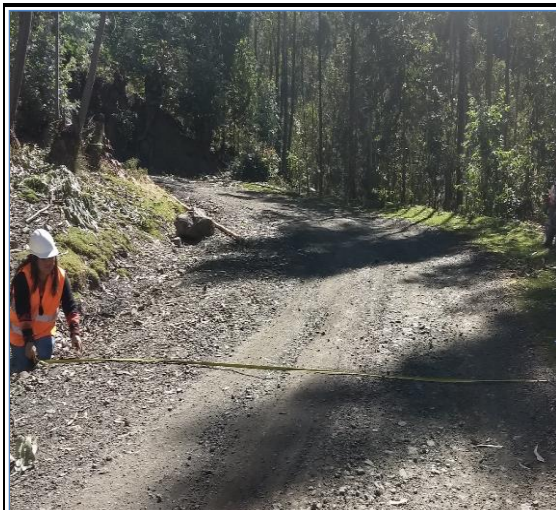
Foto N° 29 2+000 Punto de control
