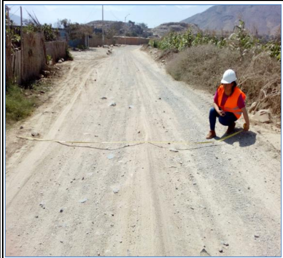
Foto N° 62 7+500 Punto de control
