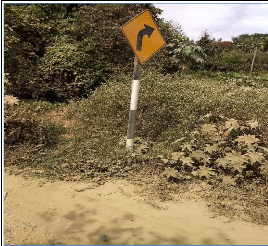
Foto N° 121 16+706 Señal preventiva lado derecho, bueno
