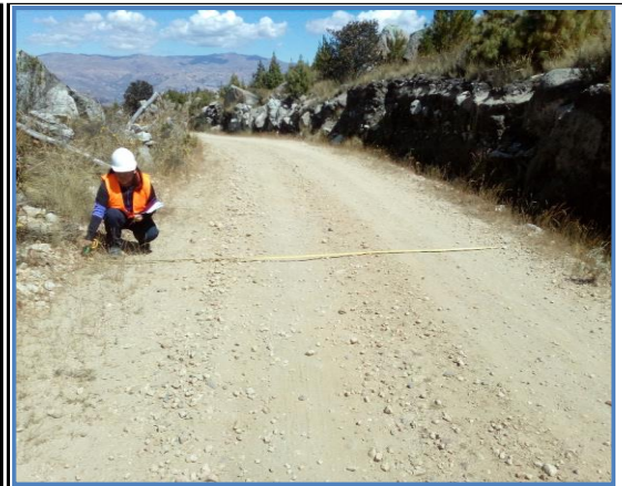
Foto N° 26 4+500 Punto de control Km 4+500
