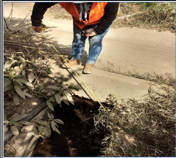
Foto N° 152 20+693 Alcantarilla de concreto armado 0.80x0.50m, regular
