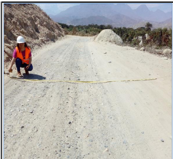
Foto N° 84 10+500 Punto de control
