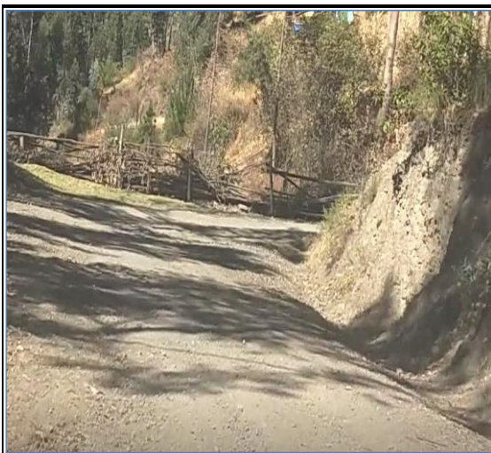
Foto N° 17 0+791 Inicio de cuneta lado derecho, regular
