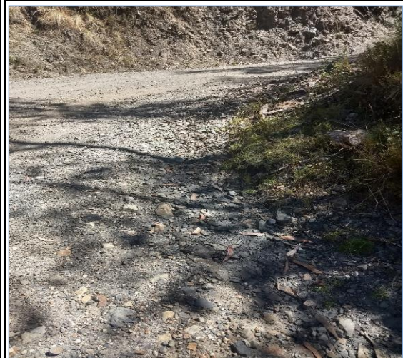
Foto N° 34 2+419 Inicio de cuneta lado derecho, regular
