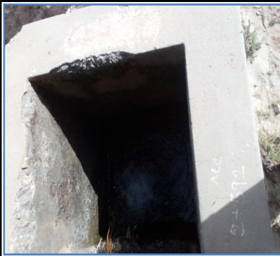
Foto N° 45 2+568 Tajea de concreto ciclópeo 0.60mx0.40m, bueno
