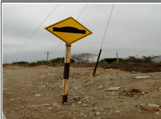
Foto N° 5 0+461 Señal preventiva lado izquierdo, bueno
