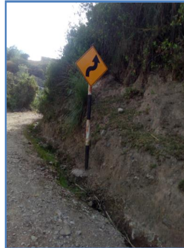
Foto N° 16 0+678 Señal preventiva lado derecho, bueno
