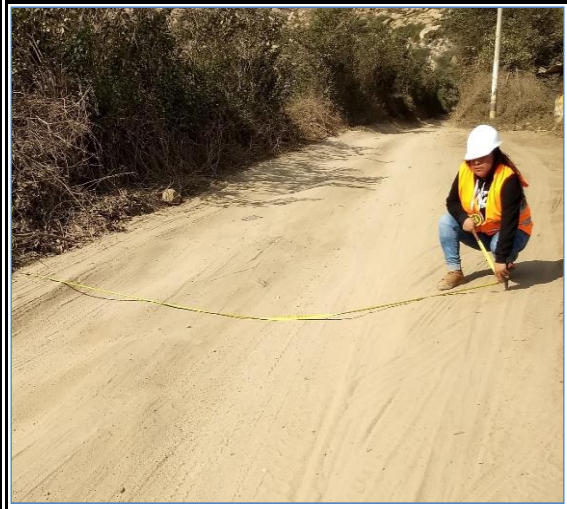
Foto N° 154 21+000 Punto de control
