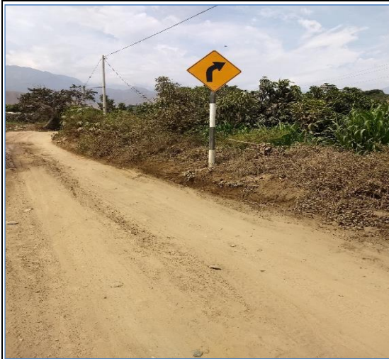
Foto N° 115 15+679 Señal preventiva lado derecho, bueno
