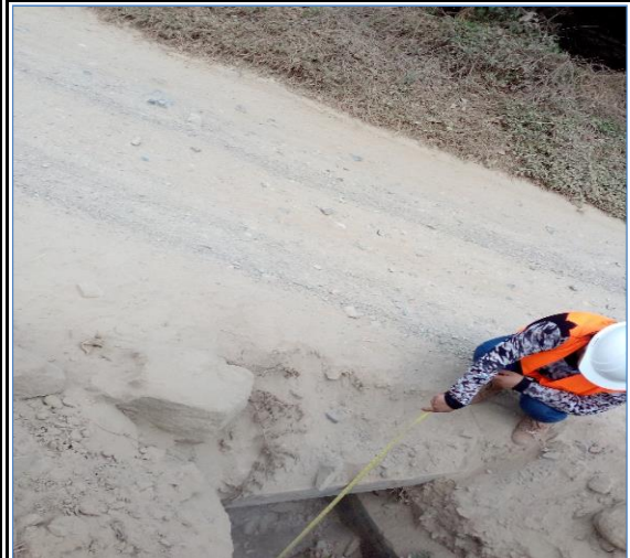
Foto N° 122 16+726 Alcantarilla de concreto armado 0.60x0.40m, regular
