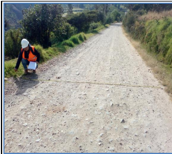
Foto N° 43 2+500 Punto de control Km 2+500
