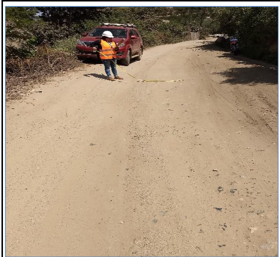
Foto N° 160 22+500 Punto de control
