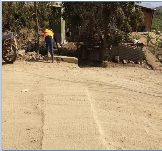
Foto N° 143 19+435 Alcantarilla de concreto armado 1.20x0.60m, regular
