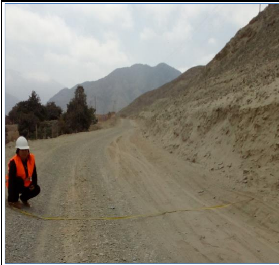
Foto N° 37 4+000 Punto de control
