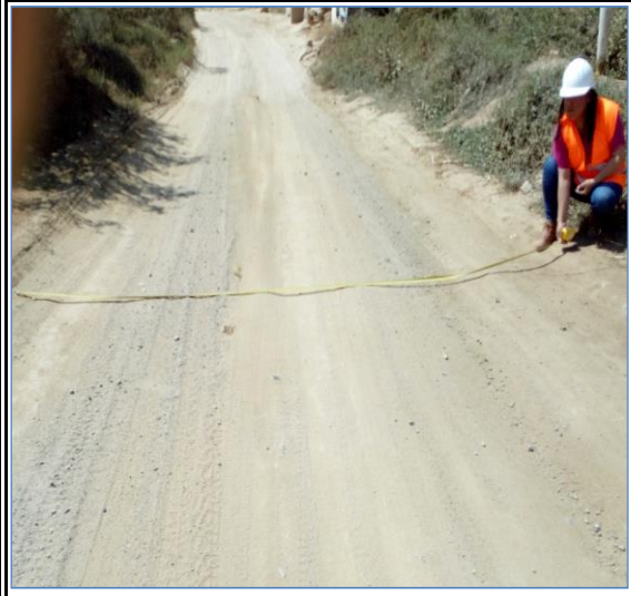
Foto N° 92 12+000 Punto de control
