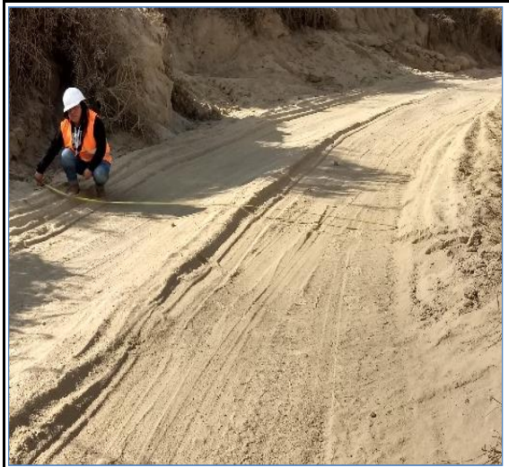
Foto N° 158 22+000 Punto de control
