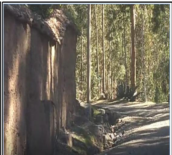
Foto N° 12 0+506 Inicio de cuneta lado izquierdo, regular
