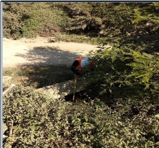
Foto N° 167 23+539 Alcantarilla de concreto armado 1.00x0.50m, regular
