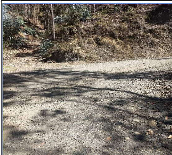
Foto N° 33 2+324 Inicio de cuneta lado izquierdo, regular
