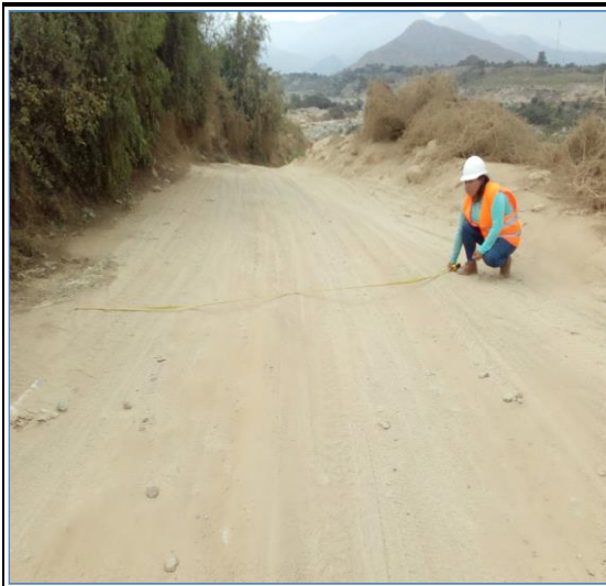
Foto N° 101 13+500 Punto de control
