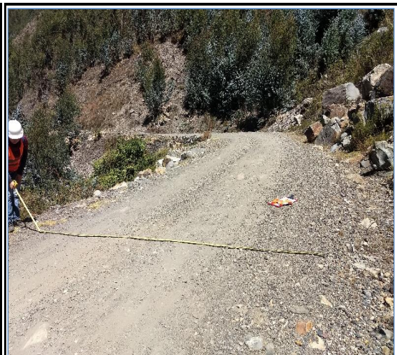
Foto N° 42 3+000 Punto de control
