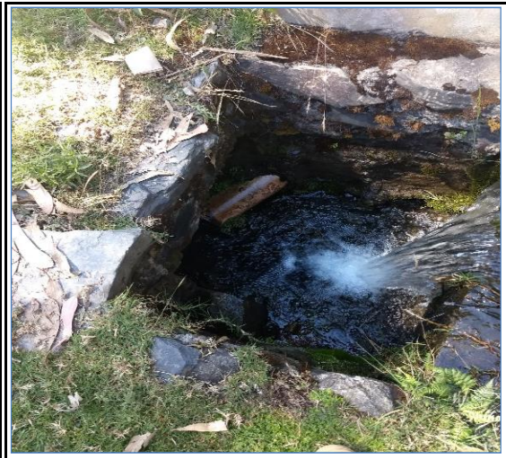
Foto N° 50 3+601 Tajea de piedra 0.70x0.60m, regular
