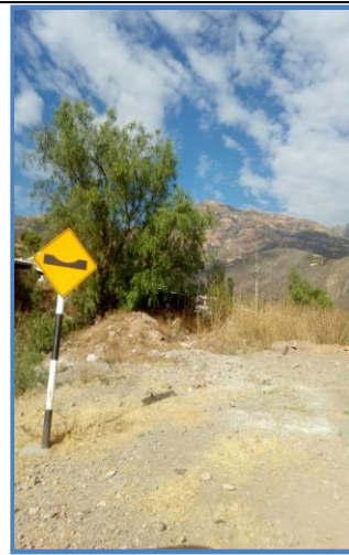
Foto N° 14 0+621 Señal Preventiva lado izquierdo, bueno
