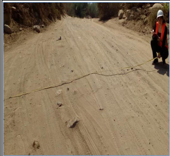
Foto N° 68 8+500 Punto de control
