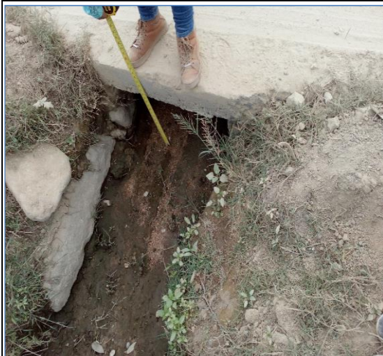
Foto N° 105 14+143 Tajea de concreto armado 0.70x0.40m, regular
