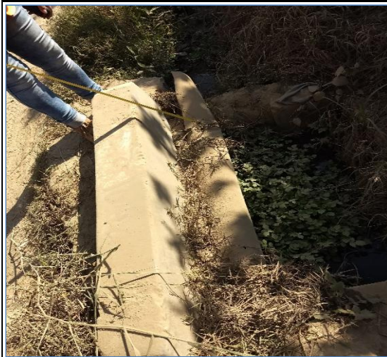
Foto N° 165 23+392 Alcantarilla de concreto armado 0.60x0.40m, regular
