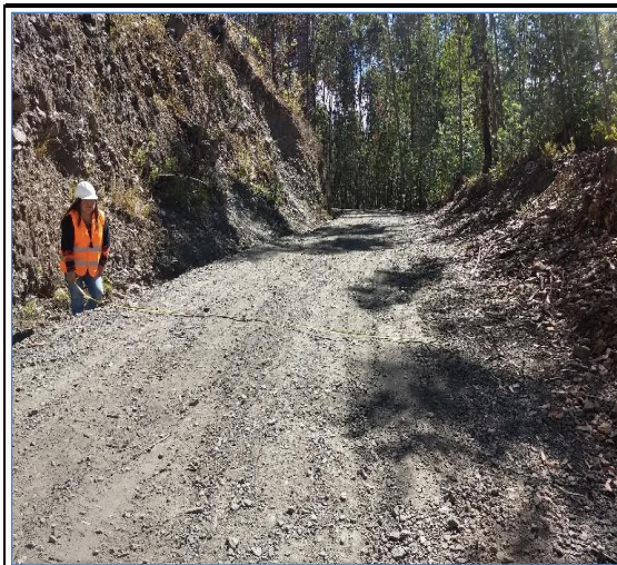
Foto N° 35 2+500 Punto de control
