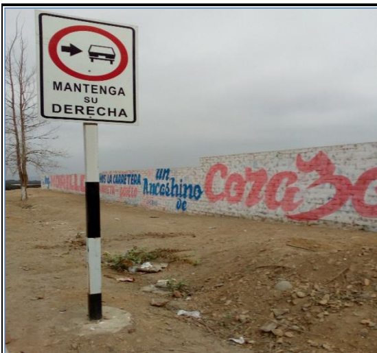
Foto N° 23 1+539 Señal reglamentaria lado izquierdo, bueno
