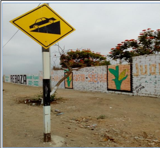
Foto N° 25 1+581 Señal preventiva lado izquierdo, bueno
