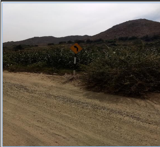
Foto N° 123 16+772 Señal preventiva lado izquierdo, bueno
