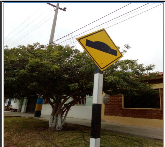
Foto N° 30 1+836 Señal preventiva lado derecho, bueno
