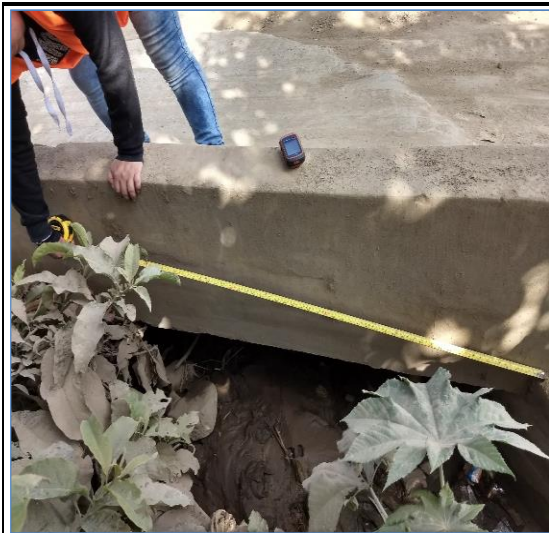
Foto N° 149 20+273 Alcantarilla de concreto armado 1.20x0.60m, regular
