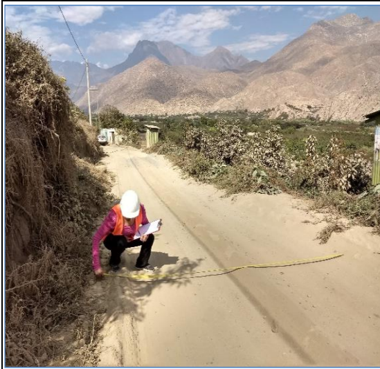
Foto N° 145 19+500 Punto de control
