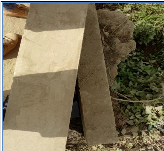
Foto N° 119 16+459 Alcantarilla de concreto armado 1.00x0.90m, regular
