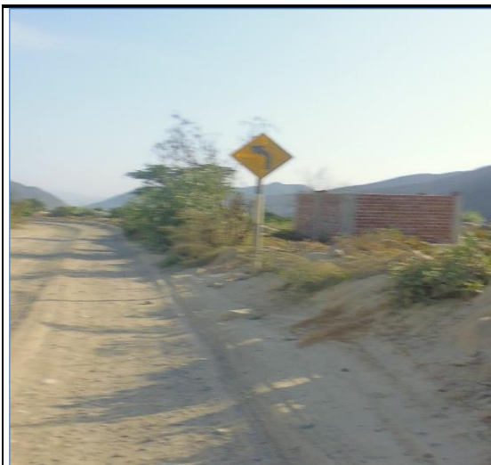
Foto N° 83 10+247 Señal preventiva lado izquierdo, bueno
