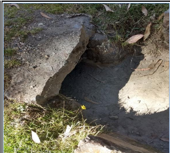
Foto N° 54 3+819 Tajea de piedra 0.50x0.40m, regular
