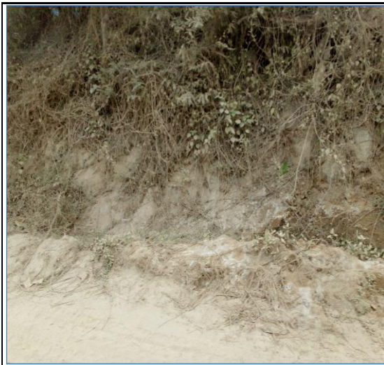
Foto N° 109 14+912 Inicio de cuneta lado izquierdo, regular
