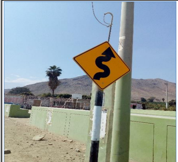
Foto N° 66 8+215 Señal preventiva lado derecho, bueno
