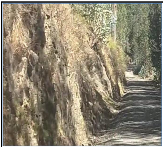
Foto N° 18 0+843 Inicio de cuneta lado izquierdo, regular
