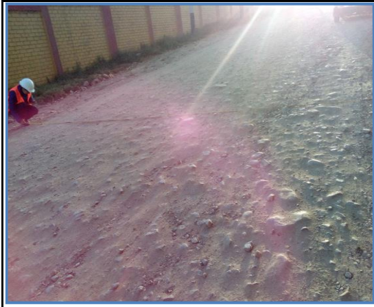
Foto N° 4 1+000 Punto de control Km 1+000
