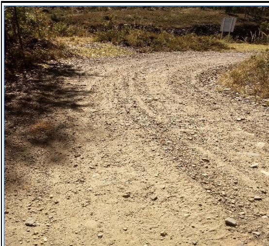
Foto N° 53 3+767 Inicio de cuneta lado derecho, regular
