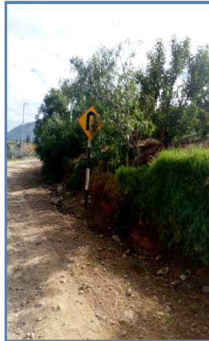
Foto N° 32 1+632 Señal preventiva lado derecho, bueno
