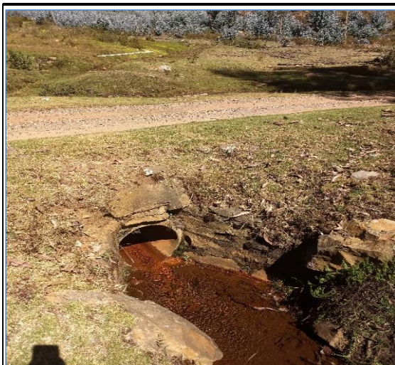
Foto N° 65 4+158 Alcantarilla de asbesto 18", regular
