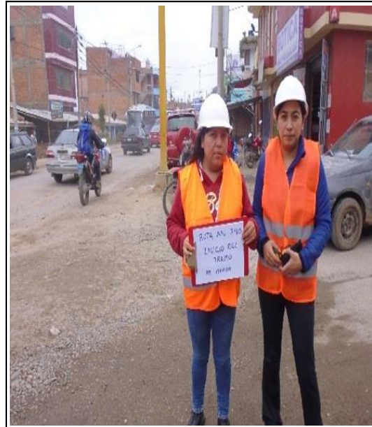
FOTOGRAFIA PUNTO INICIAL DEL TRAMO
