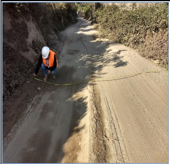
Foto N° 178 25+000 Punto de control
