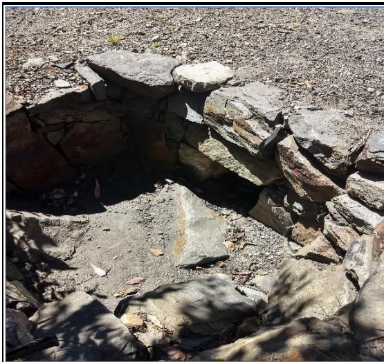
Foto N° 45 3+065 Tajea de piedra 0.40x0.30m, regular
