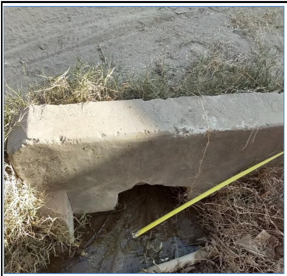
Foto N° 180 25+078 Tajera de piedra 0.40*0.30m, regular
