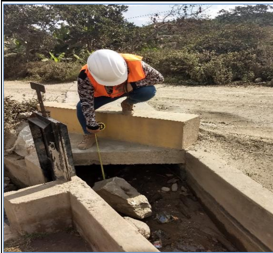
Foto N° 133 18+192 Alcantarilla de concreto armado 0.90x0.30m, bueno
