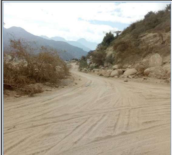
Foto N° 106 14+177 Desvio a mina
