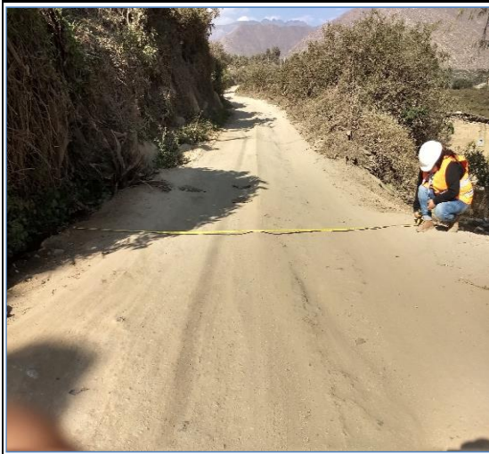
Foto N° 163 23+000 Punto de control
