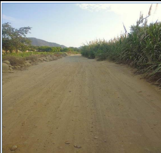
Foto N° 71 9+000 Punto de control
