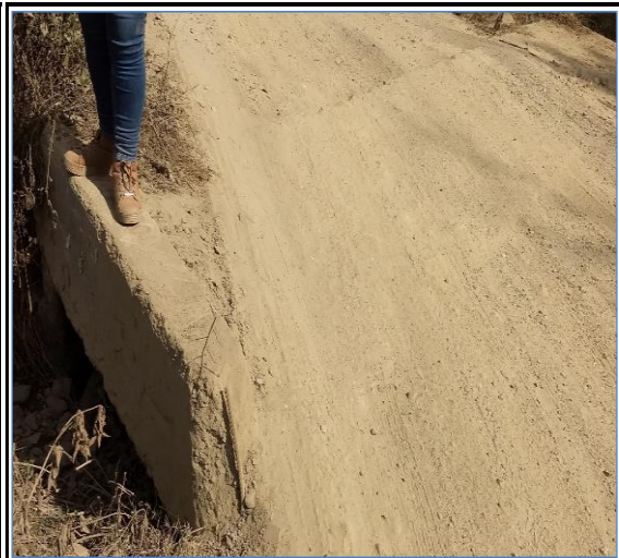
Foto N° 136 18+700 Alcantarilla de concreto armado 1.20x0.60m, regular
