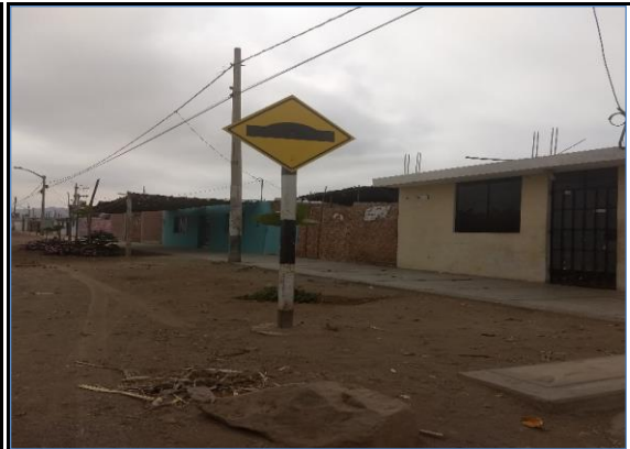
Foto N° 4 0+333 Señal preventiva lado derecho, bueno
