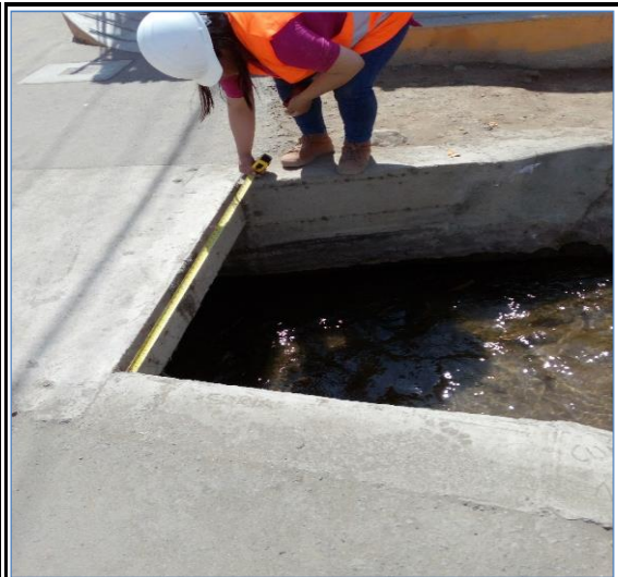
Foto N° 96 12+841 Alcantarilla concreto armado 1.20x0.5m, regular
