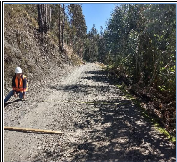
Foto N° 48 3+500 Punto de control
