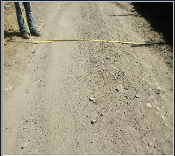
Foto N° 20 1+000 Punto de control
