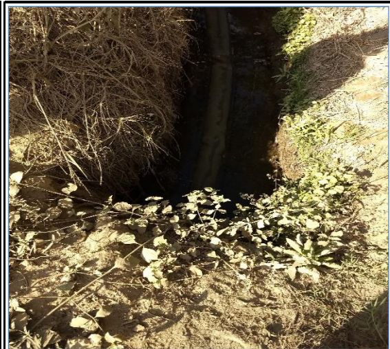
Foto N° 156 21+207 Alcantarilla de concreto armado 0.60x0.40m, regular
