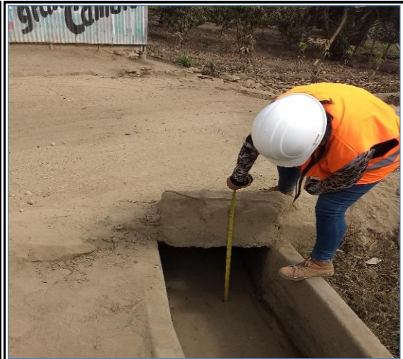
Foto N° 124 16+969 Alcantarilla de concreto armado 0.60x0.50m, bueno
