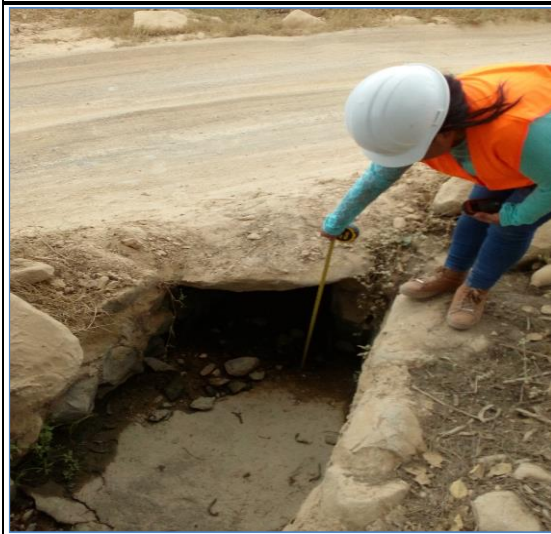
Foto N° 99 13+223 Tajea de concreto armado 0.50x0.40m, regular
