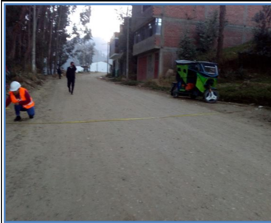
Foto N° 3 0+500 Punto de control Km 0+500
