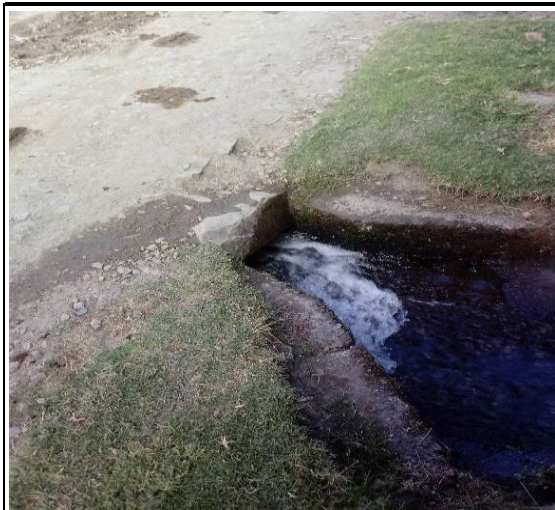
Foto N° 9 0+451 Tajea de piedra 0.40x0.30m, regular
