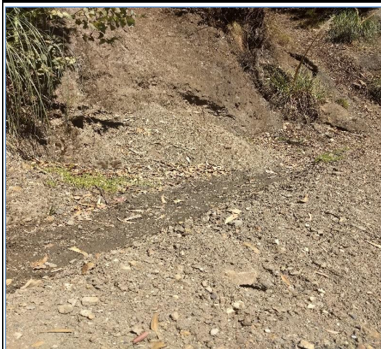
Foto N° 27 1+846 Inicio de cuneta lado derecho, regular
