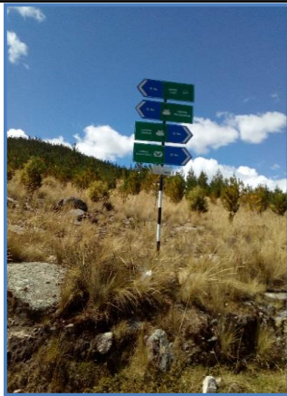
Foto N° 27 4+581 Señal informativa turística lado izquierdo, regular
