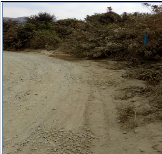
Foto N° 41 4+650 Inicio de cuneta
