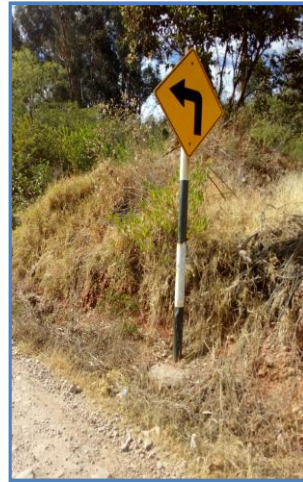
Foto N° 44 2+555 Señal preventiva, lado derecho, bueno
