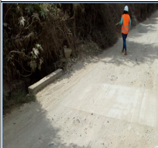
Foto N° 113 15+496 Alcantarilla concreto armado 1.00x0.50m, bueno
