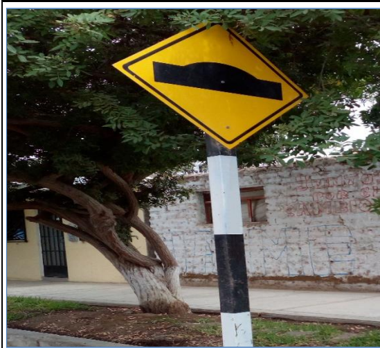
Foto N° 33 2+285 Señal preventiva lado izquierdo, bueno
