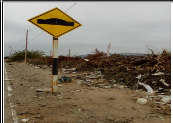
Foto N° 6 0+699 Señal preventiva lado izquierdo, bueno
