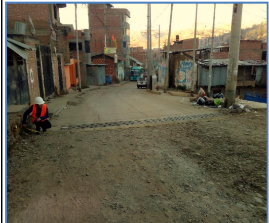
Foto N° 2 0+361 Fin de pavimento rígido
