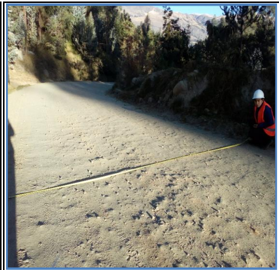
Foto N° 8 2+000 Punto de control Km 2+000
