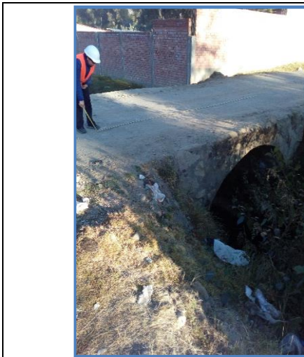
Foto N° 13 2+819 Pontón de mampostería y concreto tipo arco, de 5.60mx4.80m, bueno
