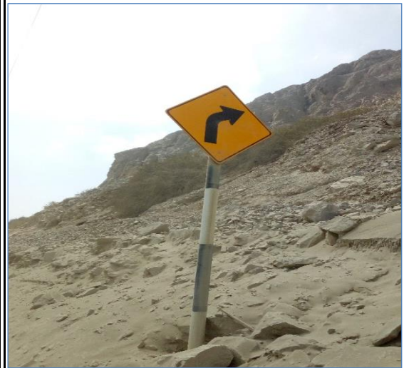
Foto N° 52 6+045 Señal preventiva lado derecho, bueno
