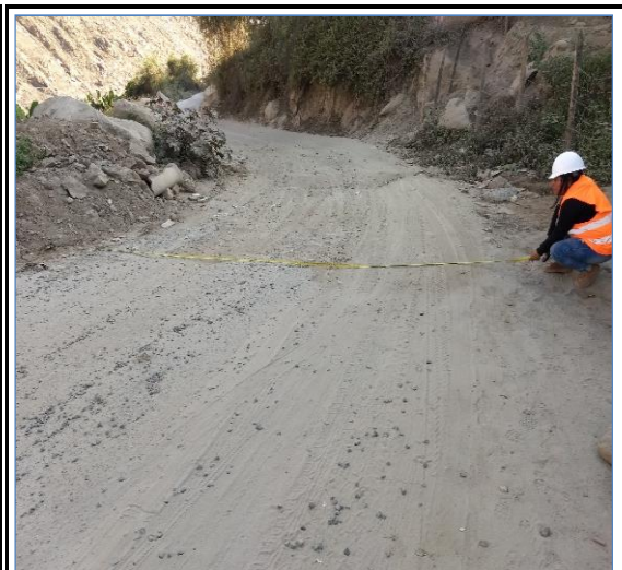
Foto N° 186 26+000 Punto de control
