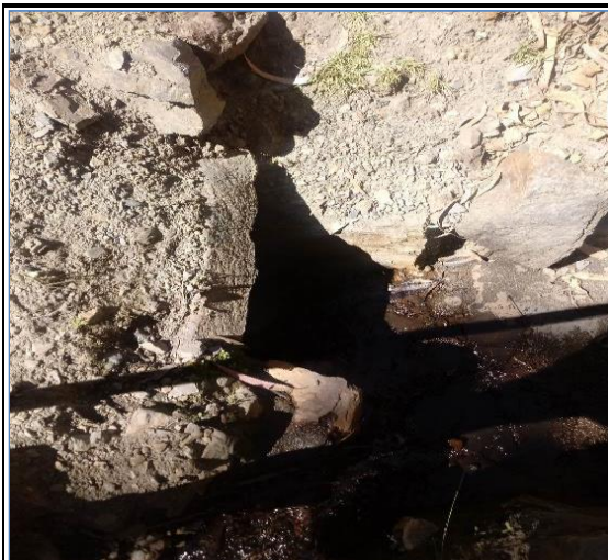
Foto N° 23 1+436 Tajea de piedra 0.60x0.40m, regular
