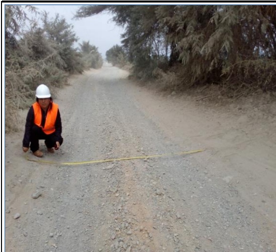
Foto N° 35 3+000 Punto de control
