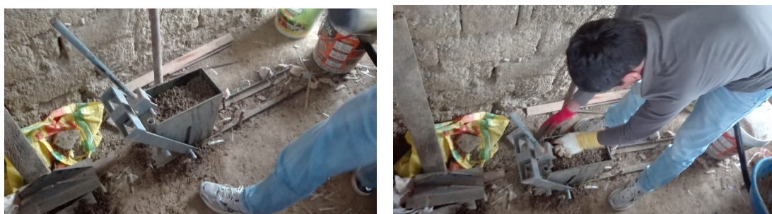
Figura C.1.3. Vertido y acomodo del material en la máquina CINVA-RAM.
