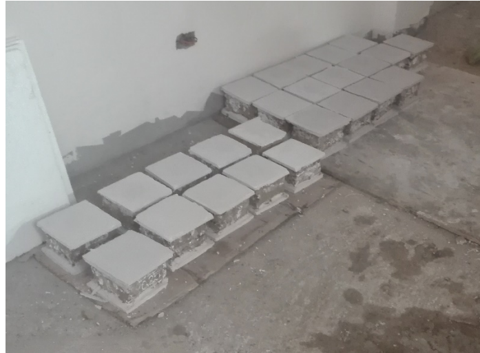
Figura 7. Refrentado de las unidades para el ensayo a compresión de la unidad de adobe compactado de 15x15x10 cm.
