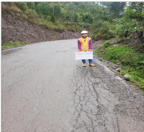
Fotografía 35: Piel de cocodrilo, gravedad 3 – km 0+820. Fuente: propia.
