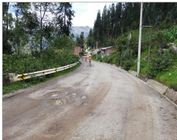
Fotografía 25: Medición con el rugosímetro de Merlín, tramo 08. Progresiva km 3+150. Fuente: propia.
