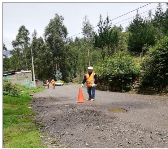
Fotografía 21: Medición con el rugosímetro de Merlín, tramo 06. Progresiva km 2+260. Fuente: propia.
