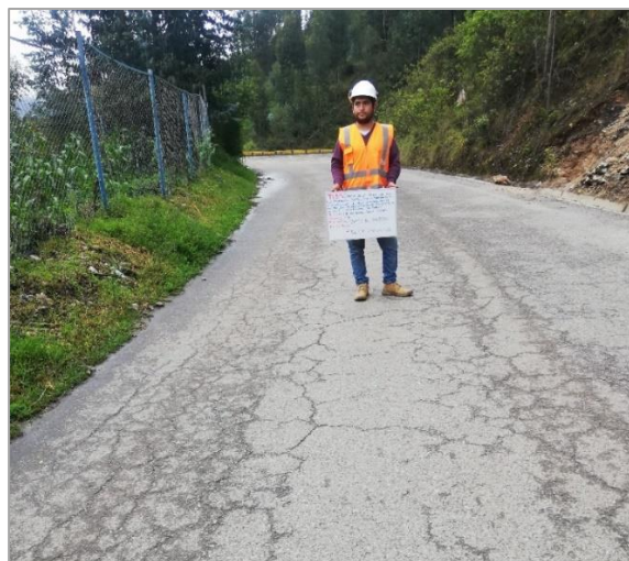
Fotografía 54: Falla: Piel de cocodrilo, gravedad 2 – km 2+760. Fuente: propia.
