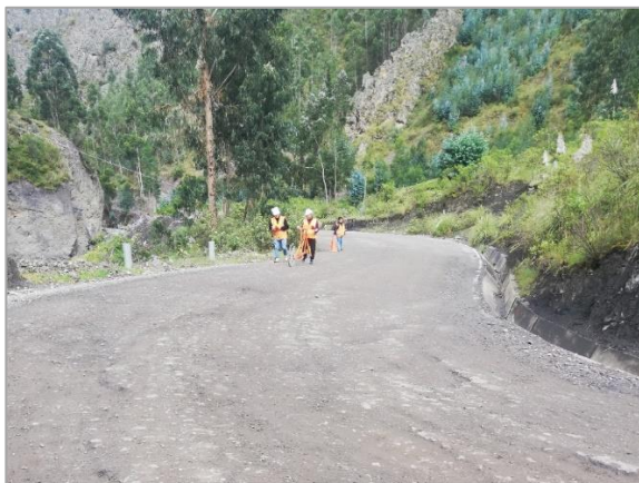
Fotografía 12: Medición con el rugosímetro de Merlín, tramo 02. Progresiva km 0+500. Fuente: propia.
