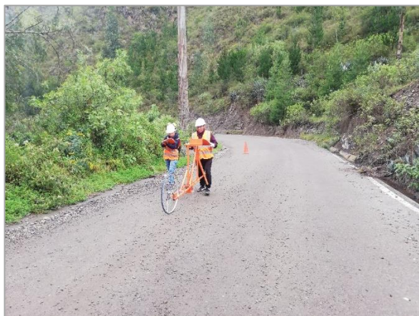
Fotografía 14: Medición con el rugosímetro de Merlín, tramo 03. Progresiva km 0+900. Fuente: propia.
