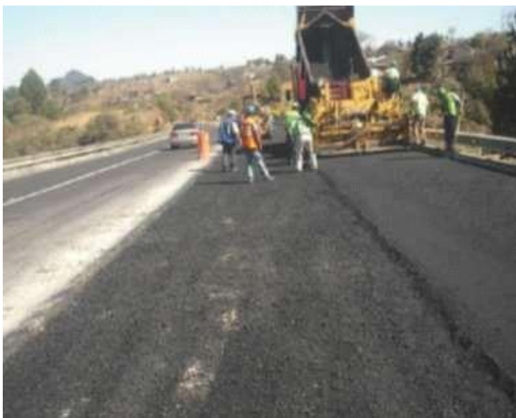
Fotografía 6: Fresado de carpeta asfáltica.
