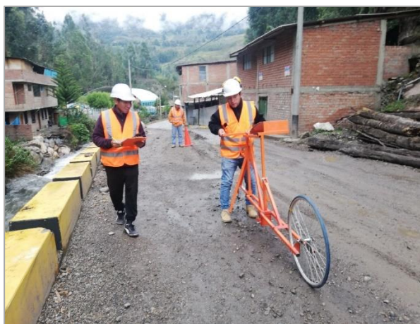
Fotografía 10: Medición con el rugosímetro de Merlín, tramo 01. Progresiva km 0+020. Fuente: propia.
