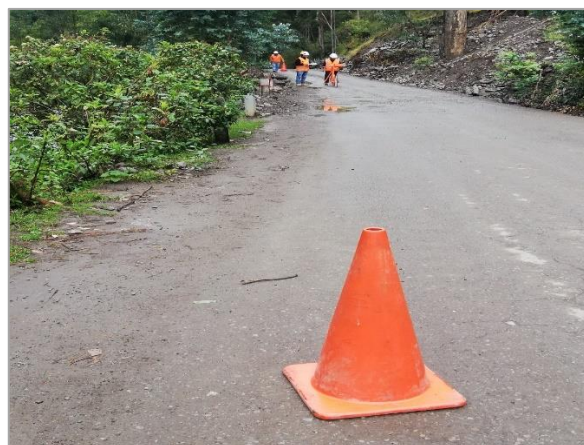
Fotografía 11: Medición con el rugosímetro de Merlín, tramo 01. Progresiva km 0+320. Fuente: propia,
