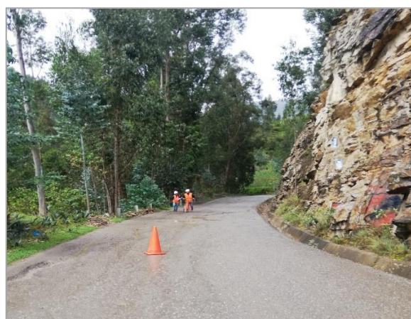
Fotografía 19: Medición con el rugosímetro de Merlín, tramo 05. Progresiva km 1+900. Fuente: propia.
