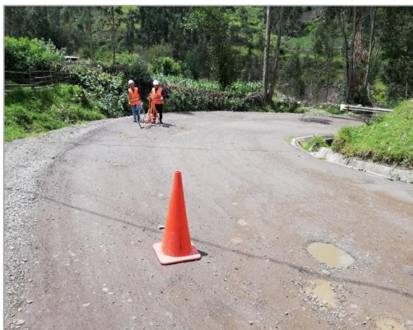
Fotografía 22: Medición con el rugosímetro de Merlín, tramo 07. Progresiva km 2+460. Fuente: propia.
