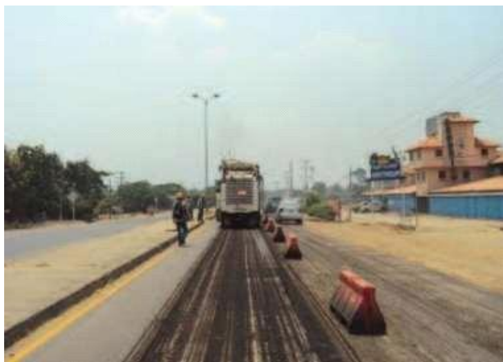
Fotografía 7: Microfresado de carpeta asfáltica.
