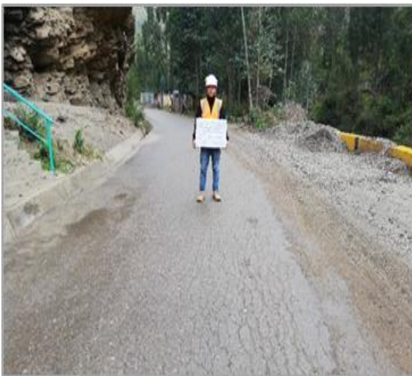
Fotografía 29: Falla: Piel de cocodrilo, gravedad 3 – km 0+110. Fuente: propia.
