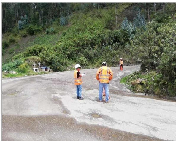
Fotografía 24: Medición con el rugosímetro de Merlín, tramo 08. Progresiva km 2+820. Fuente: propia.
