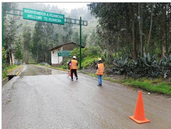
Fotografía 16: Medición con el rugosímetro de Merlín, tramo 04. Progresiva km 1+380. Fuente: propia.
