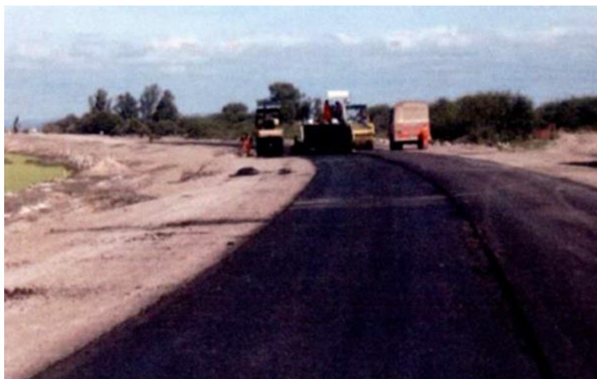
Fotografía 5: Recapeos asfálticos.
