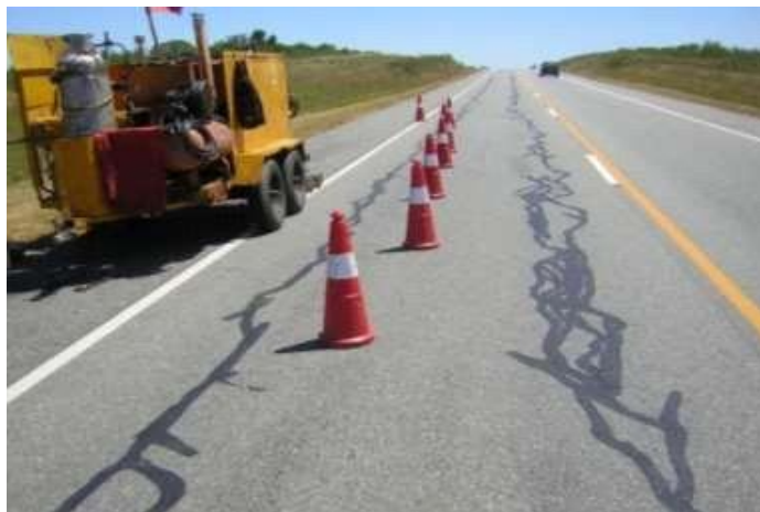
Fotografía 1: Sellado de fisuras y grietas.
