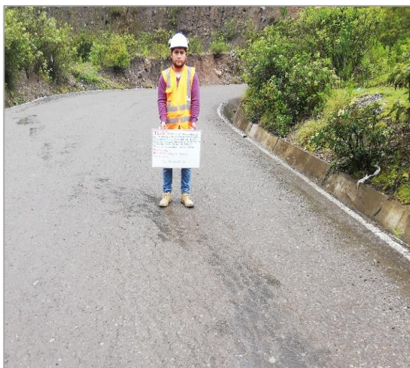
Fotografía 33: Falla: Piel de cocodrilo, gravedad 3 – km 0+700. Fuente: propia.
