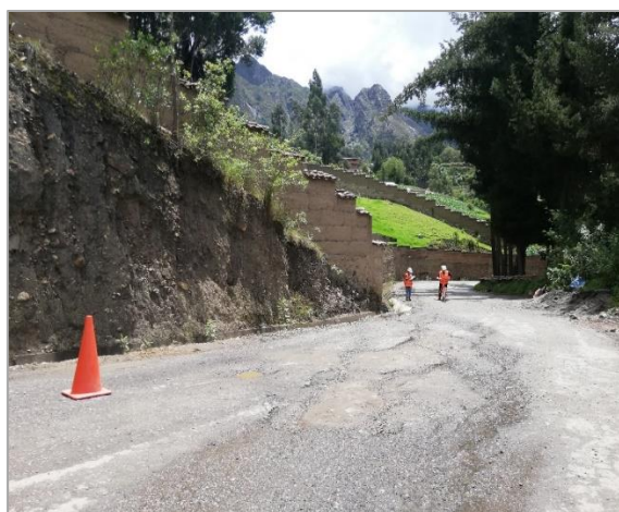
Fotografía 23: Medición con el rugosímetro de Merlín, tramo 07. Progresiva km 2+550. Fuente: propia.
