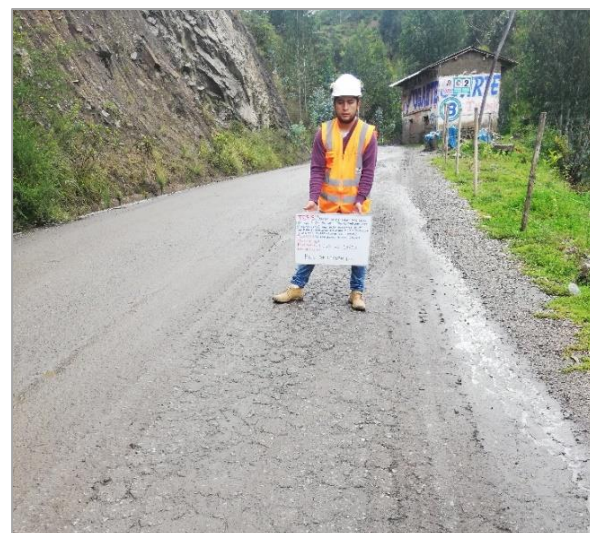
Fotografía 42: Falla: Piel de cocodrilo, gravedad 3 – km 1+520. Fuente: propia.
