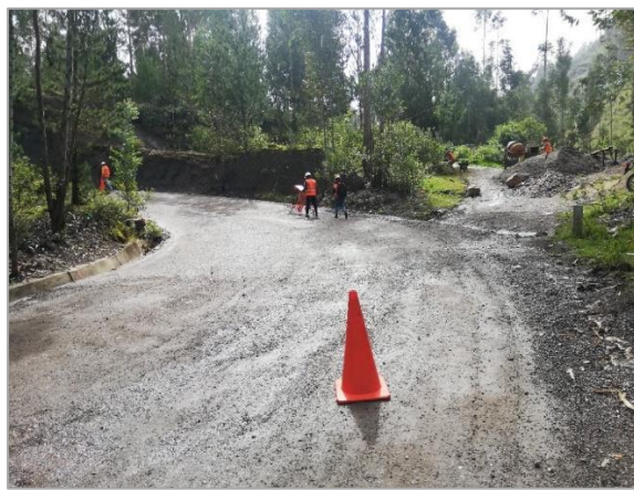
Fotografía 15: Medición con el rugosímetro de Merlín, tramo 03. Progresiva km 1+100. Fuente: propia.
