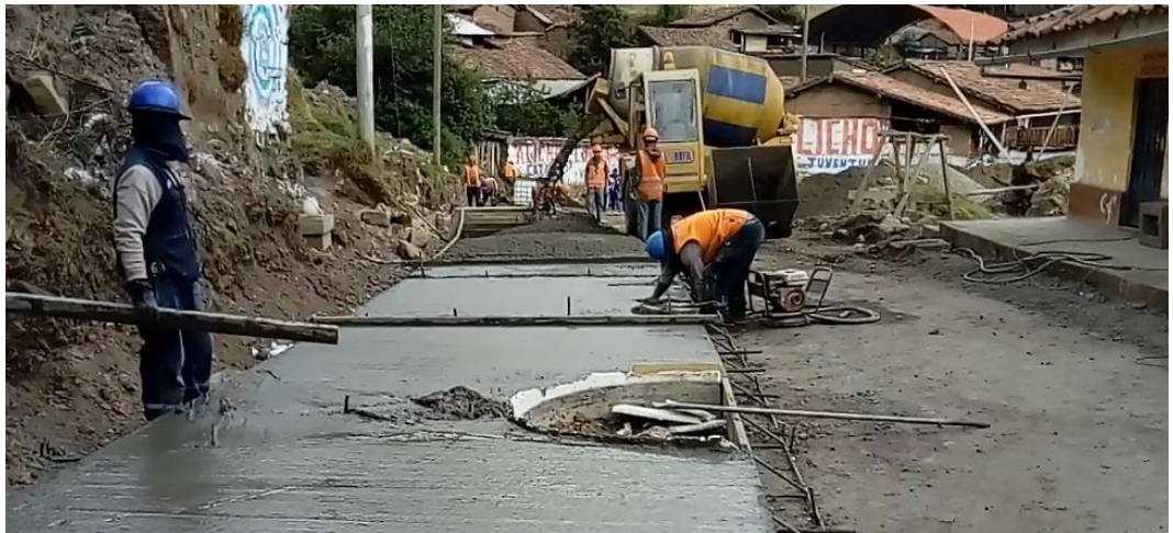
Fotografía 8: se muestra la cuadrilla de la mezcladora autohormigonera al momento del llenado del vaciado de la mezcla.
