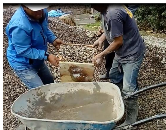
Fotografía 2: Cubicación de los agregados.
