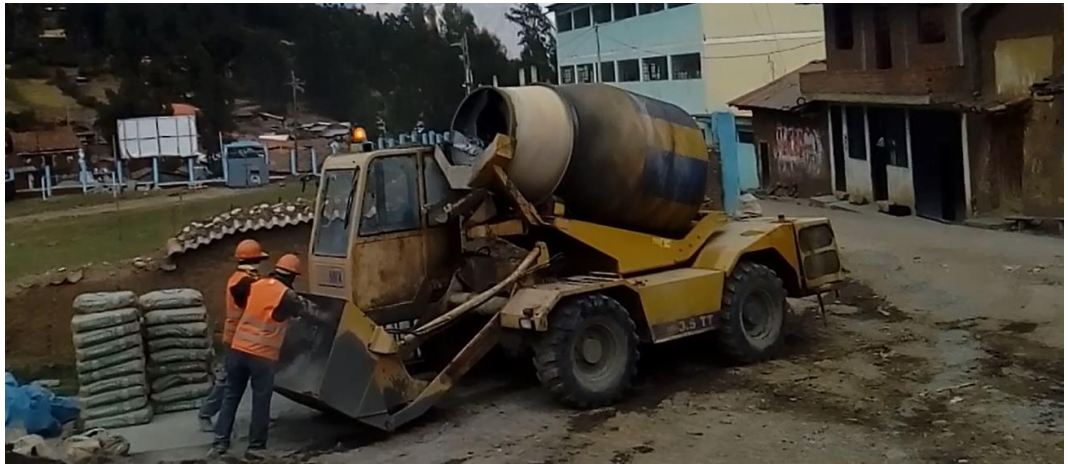
Fotografía 7: se muestra la cuadrilla de la mezcladora autohormigonera al momento del llenado del cemento.
