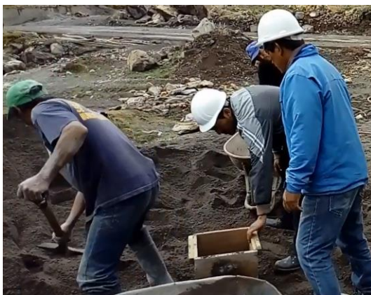
Fotografía 2: Cubicación de los agregados.
