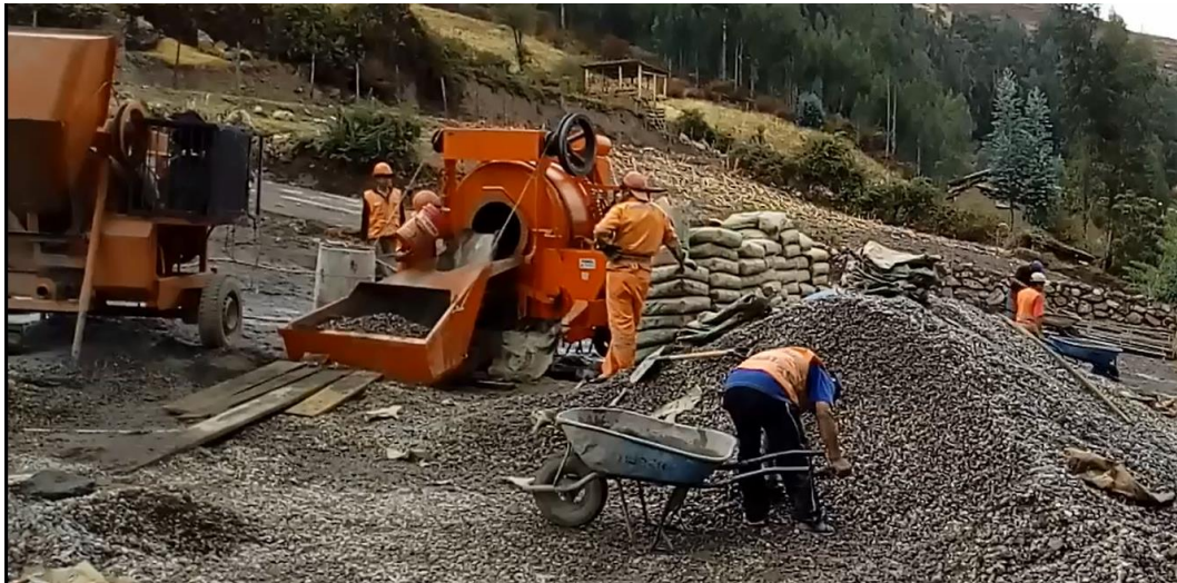
Fotografía 5: se muestra la cuadrilla de la mezcladora tolva de 18p3 de capacidad, al momento del llenado de agua, llenado de a piedra chancada y traslado de la mezcla.
