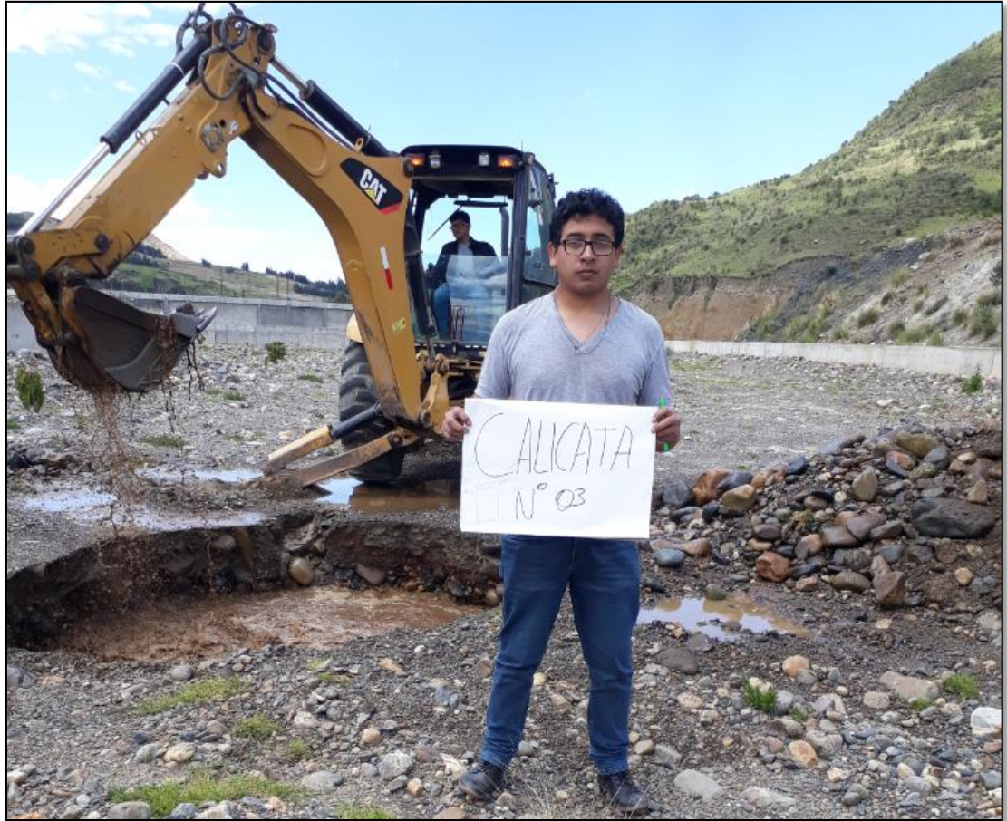
Fotografía N° 11: Calicata 03 (estudio propio)
