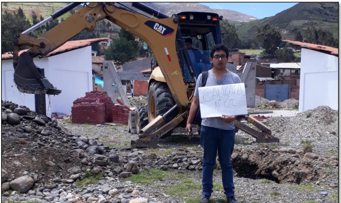
Fotografía N° 10: Calicata 02 (estudio propio)
