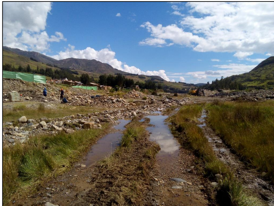
Fotografía N° 06: Zona de Restaurantes
