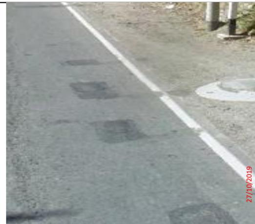
Foto 15: Tramo N°03-Pav Flexible ubicación Km562+990. Presencia de Reparaciones y parchado nivel 1.
