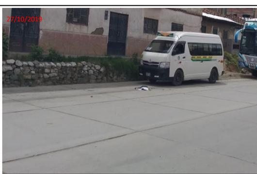
Foto 7: Tramo N°01, ubicación km577+680. Ligera presencia de desintegración de juntas.
