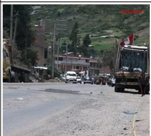
Foto 12: Tramo N°02, ubicación Km577+565. Presencia de desprendimiento superficial gravedad 3 y baches rellenados con tierra gravedad 3.
