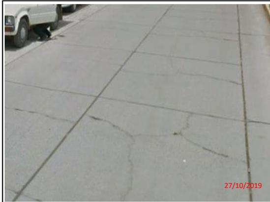
Foto 5: Tramo N°01, ubicación km 578+100. Fallas de tipo fisuras oblicuas y transversales gravedad 2.
