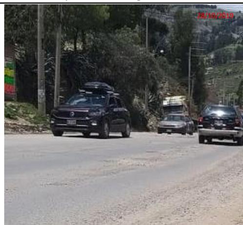
Foto 11: Tramo N°02, ubicación Km577+570. Presencia de desprendimiento superficial nivel 2 y baches rellenados con tierra gravedad 2.
