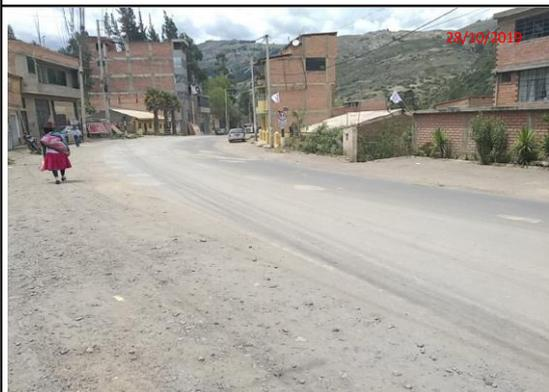
Foto 9: Tramo N°02-Ubicación km577+280. Presencia de Baches rellenos con tierra y peladuras de gravedad 3.
