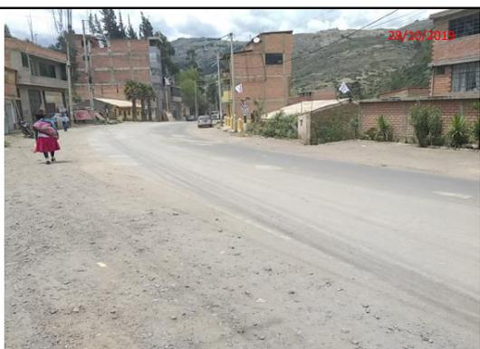
Foto 9: Tramo N°02-Ubicación km577+280. Presencia de Baches rellenados con tierra y peladuras de gravedad 3.
