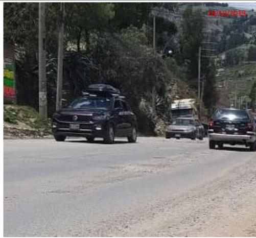
Foto 11: Tramo N°02, ubicación Km577+570. Presencia de desprendimiento superficial nivel 2 y baches rellenados con tierra gravedad 2.
