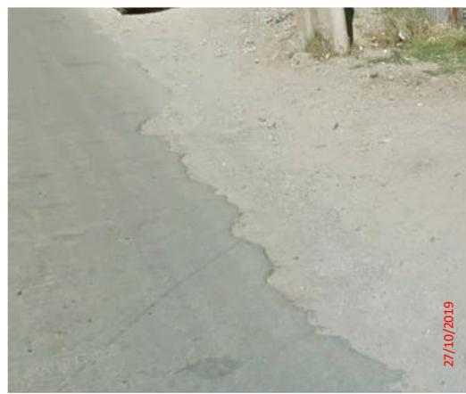
Foto 13: Tramo N°02-Ubicación km577+050- Desprendimiento y peladura de gravedad 2.
