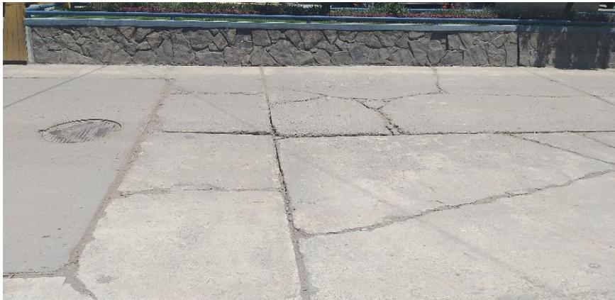
*Figura 56.* Fisuración en la carretera.
