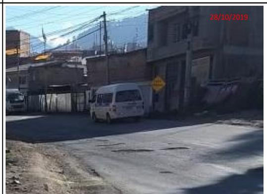
Foto10: Tramo N°02-ubicaciónkm577+690- Presencia de baches(huecos) de gravedad 2 y 3.
