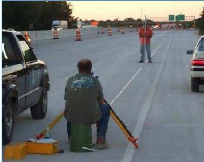
**Figura 10.** Medición de Perfil con nivel y mira.
