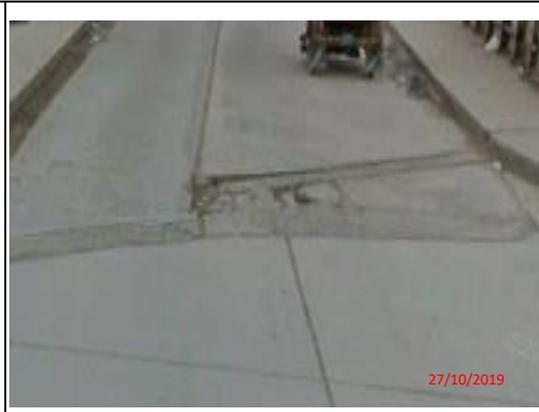
Foto 6: Tramo N°01, ubicación km578+600- inicio de puente. Presencia de despostillamiento de juntas gravedad 1.
