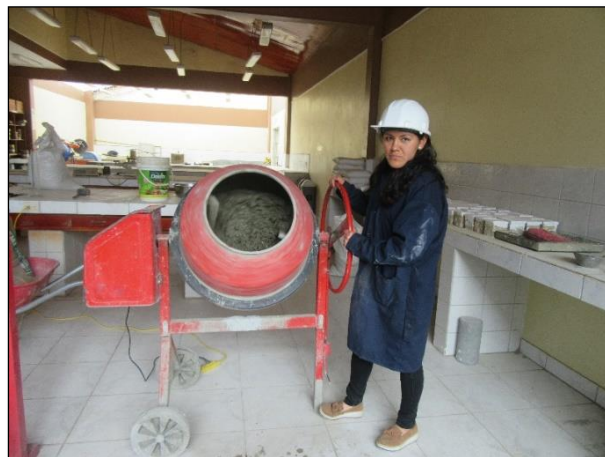
Realizando la mezcla del concreto
