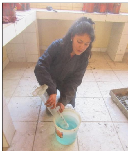
Mezclando el aditivo Sika 3 con el agua
