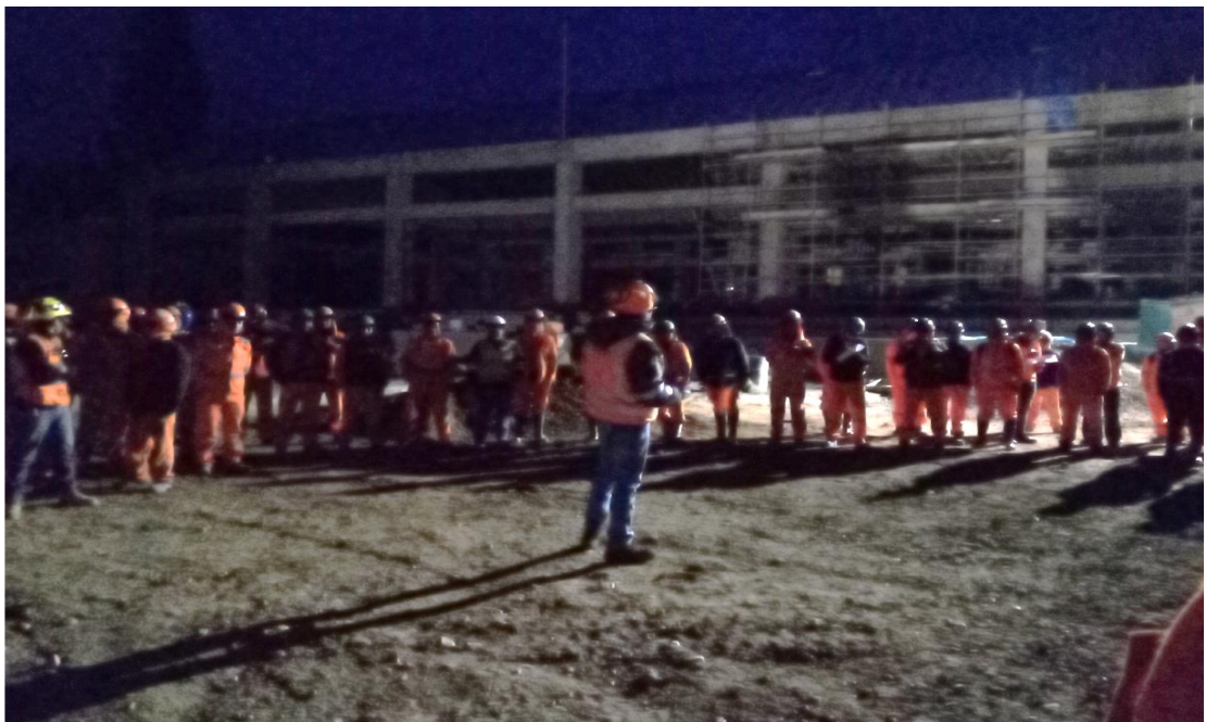
Foto 6: Tesista brindando charla de seguridad al personal de guardia de noche.
