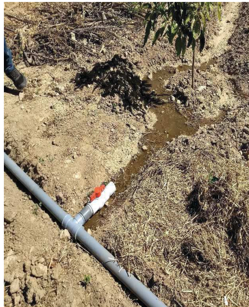
Imagen 06: Instalación de las Válvulas tipo bola de 1 1/2" para riego, frente a cada surco.
