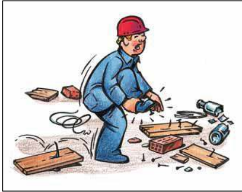
Figura 24. Accidentes en el desencofrado.
