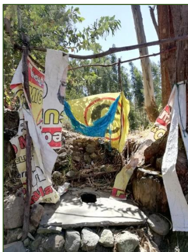
Figura 21. Pozo ciego en la vivienda N° 09 – Ucu
