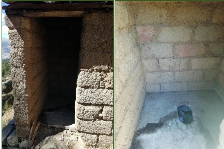
Figura 18. Pozo ciego en la vivienda N° 02 – Santa Rosa de Pacuash
