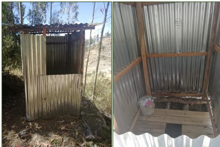
Figura 19. Pozo ciego en la vivienda N° 03 – Santa Rosa de Pacuash
