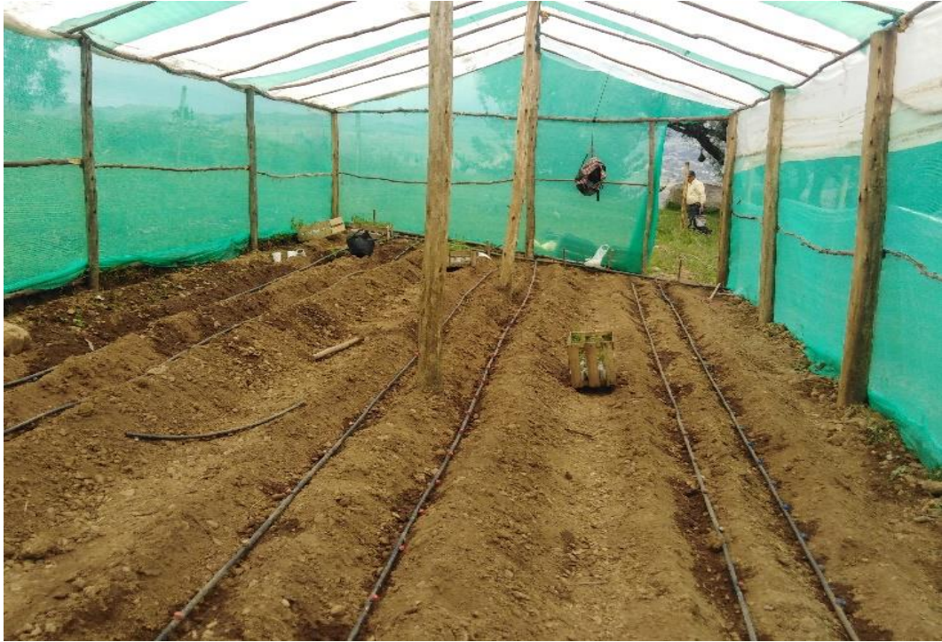
Figura 11: Instalación sistema de riego.
