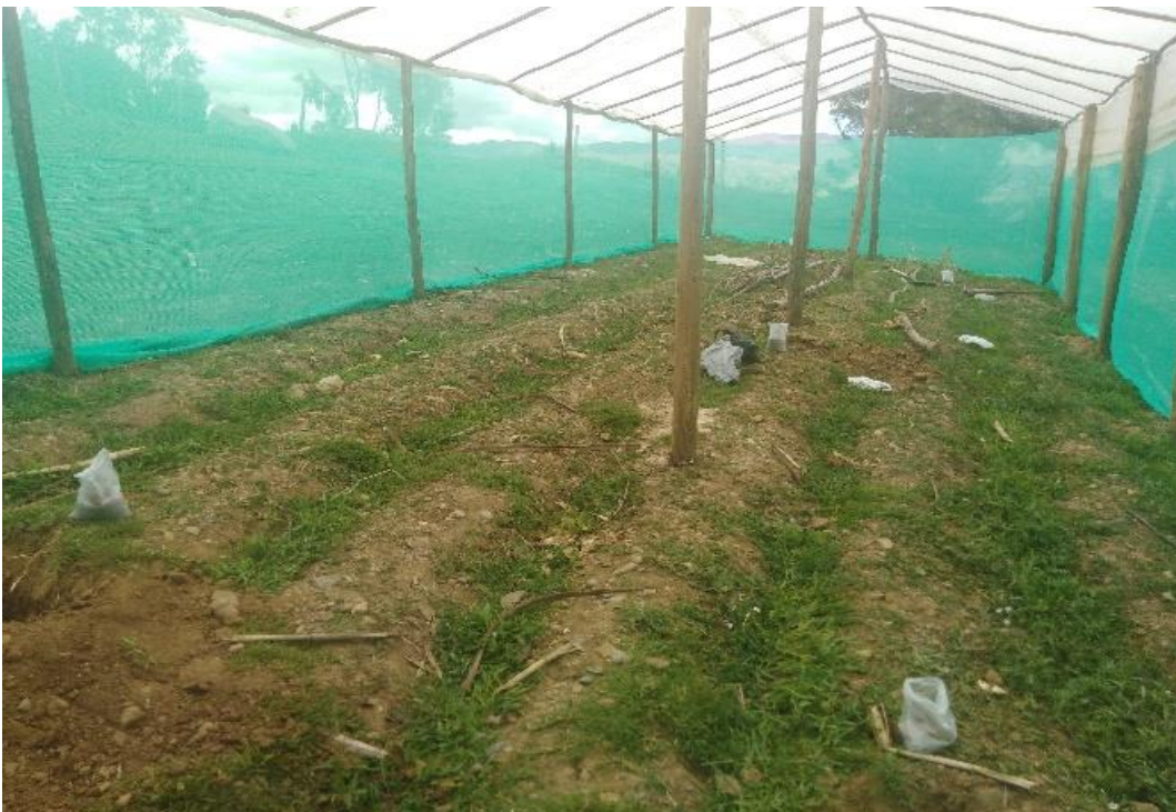
Figura 8: Limpieza de terreno
