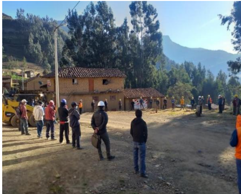
Fotografía A11. Charla inicial diaria en obra
