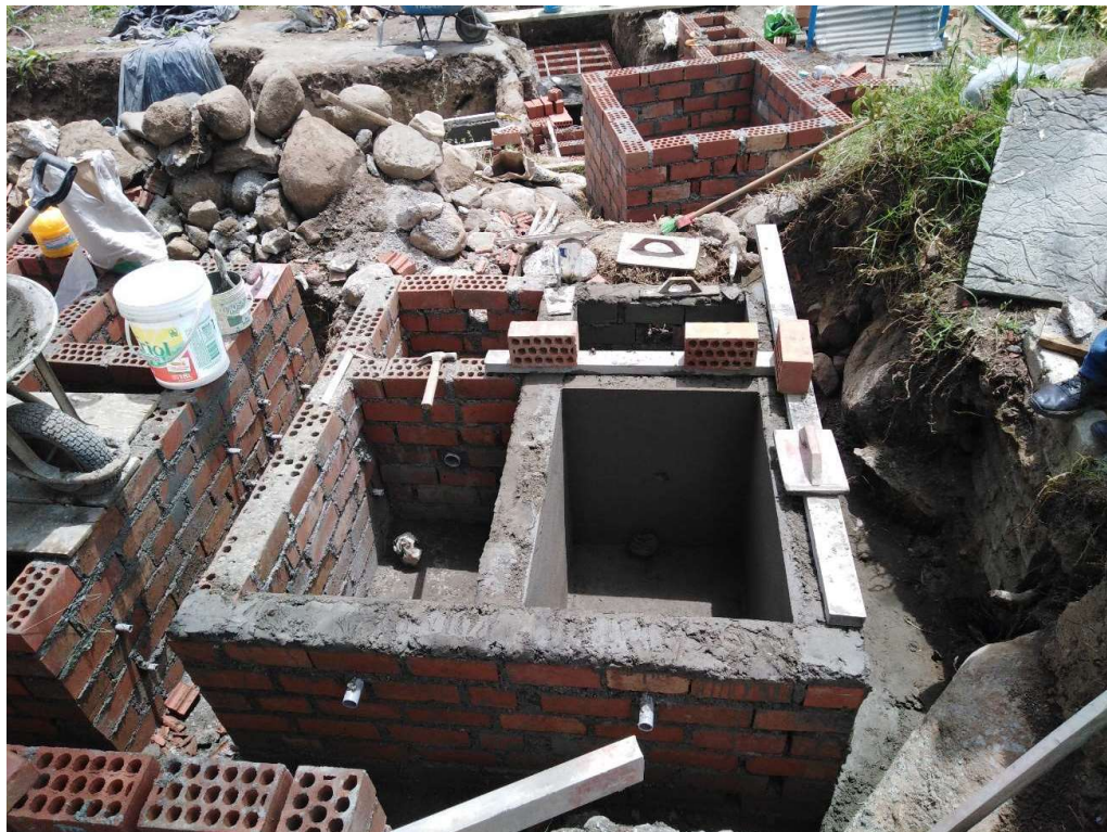
Imagen 9 : Tarrajeo de los reactores primarios (tanques sépticos)
