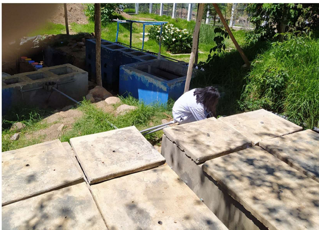
Imagen 11: Reactores primarios culminados (tanques sépticos)
