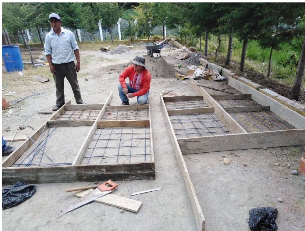
Imagen 11: Reactores primarios culminados (tanques sépticos)
