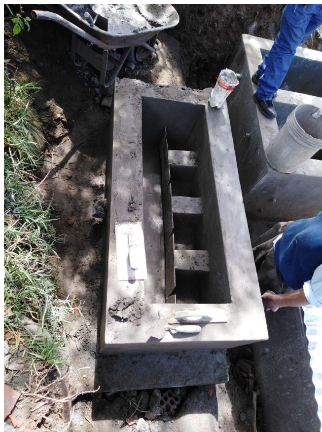
Imagen 7: Construcción del repartidor de caudal de los reactores primarios(tanques sépticos)
