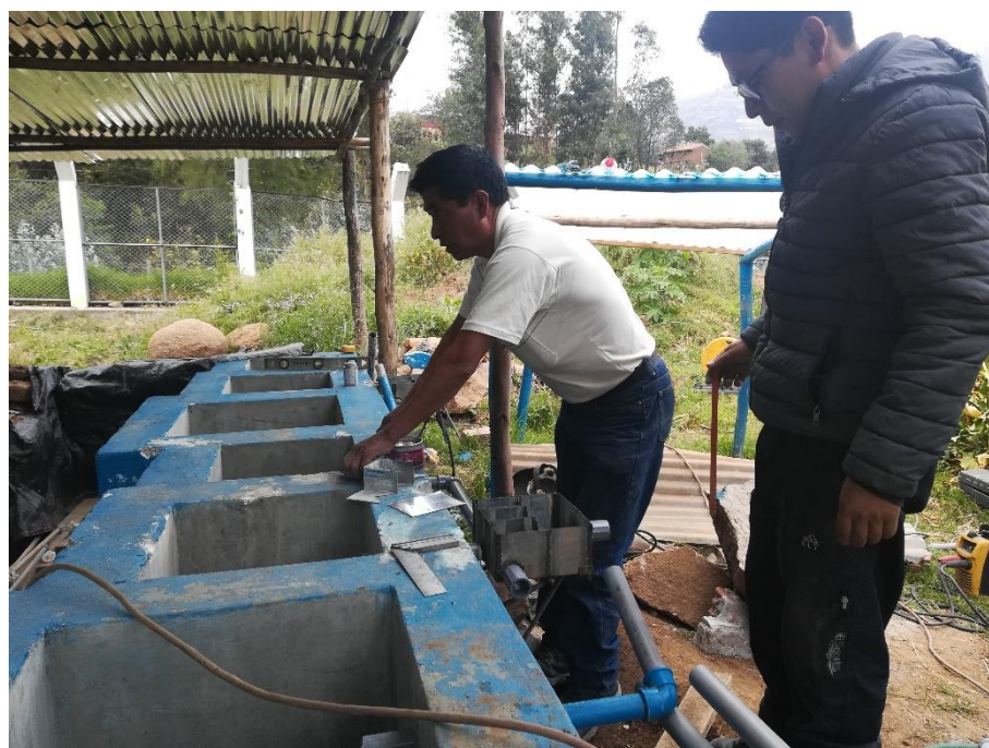
Fotografía N°10: Verificación de las instalaciones de tuberías y un flujo de AARR por gravedad.
