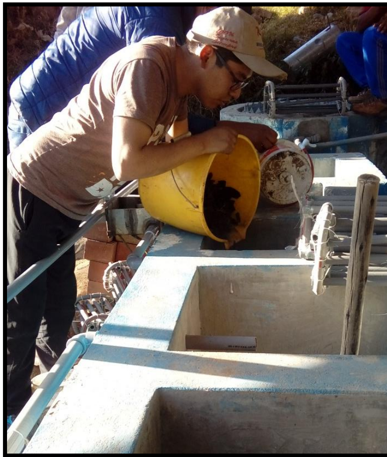
Fotografía N°14: Llenado del medio filtrante de carbón vegetal y grava.
