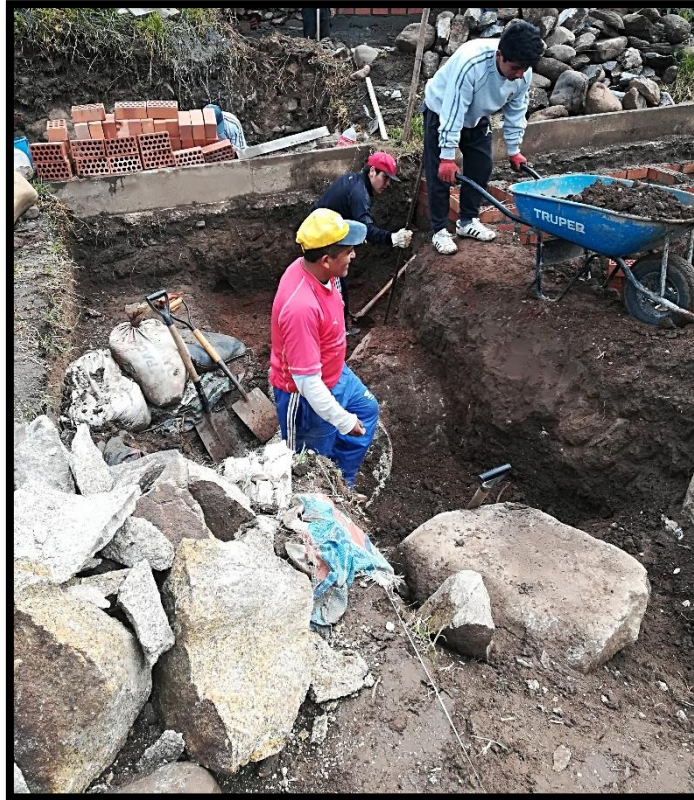
Fotografía N°3: Voladuras de rocas para la construcción del sistema.
