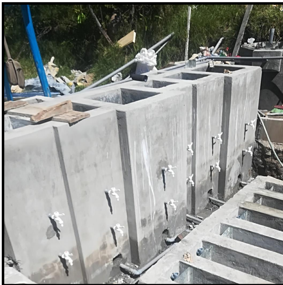
Fotografía N°7: Tarrajeo de filtros percoladores.
