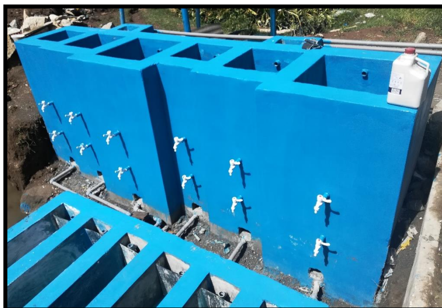
Fotografía N°8: Pintado de los filtros percoladores.
