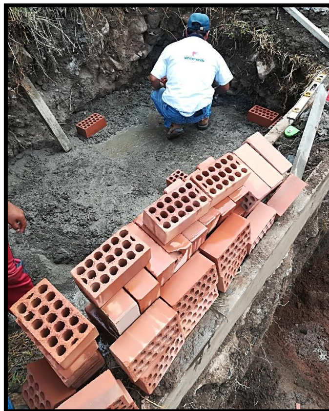
Fotografía N°4: Vaciado de concreto para los sedimentadores primarios.
