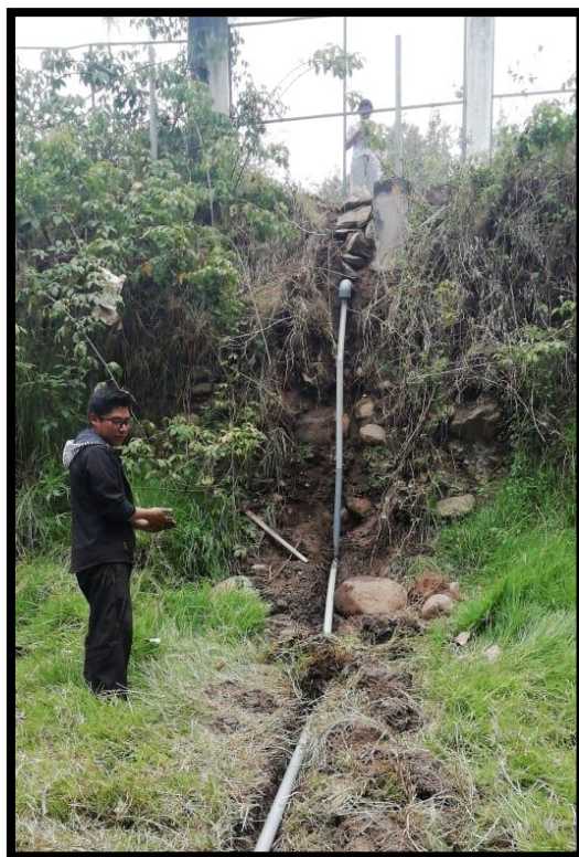
Fotografía N°17: Instalación de tuberías de salida del agua tratada.
