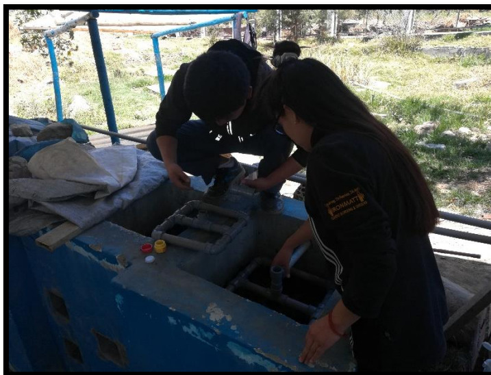
Fotografía N°16: Colación de las tuberías de distribución en los filtros.
