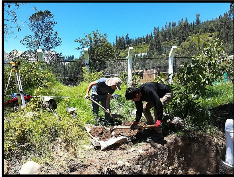
Fotografía N°1: Trazo y replanteo para construcción del sistema de tratamiento.
