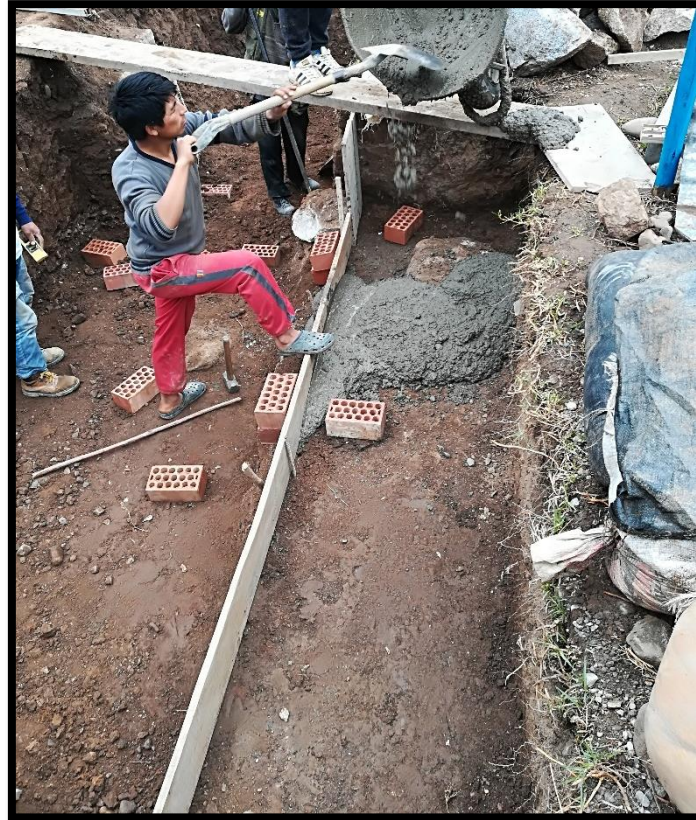
Fotografía N°5: Vaciado de concreto para los filtros percoladores.
