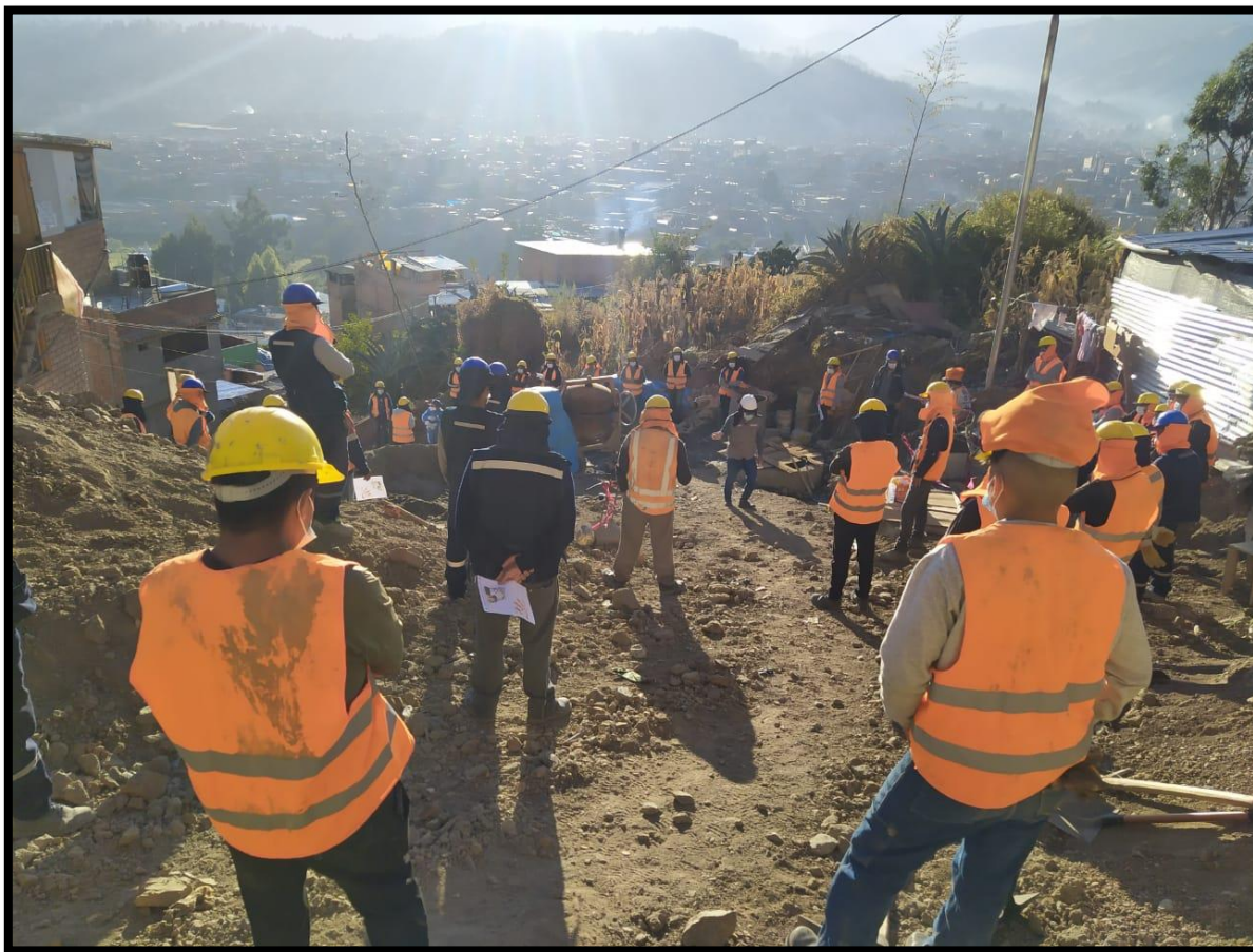
Charla de inducción a cargo del supervisor de seguridad.
