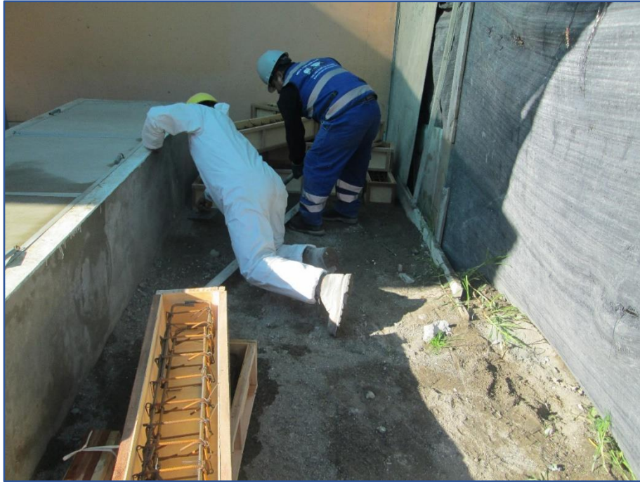
Figura 101: Nivelación y compactado de la superficie de apoyo de los moldes. Fuente: Elaboración propia.
