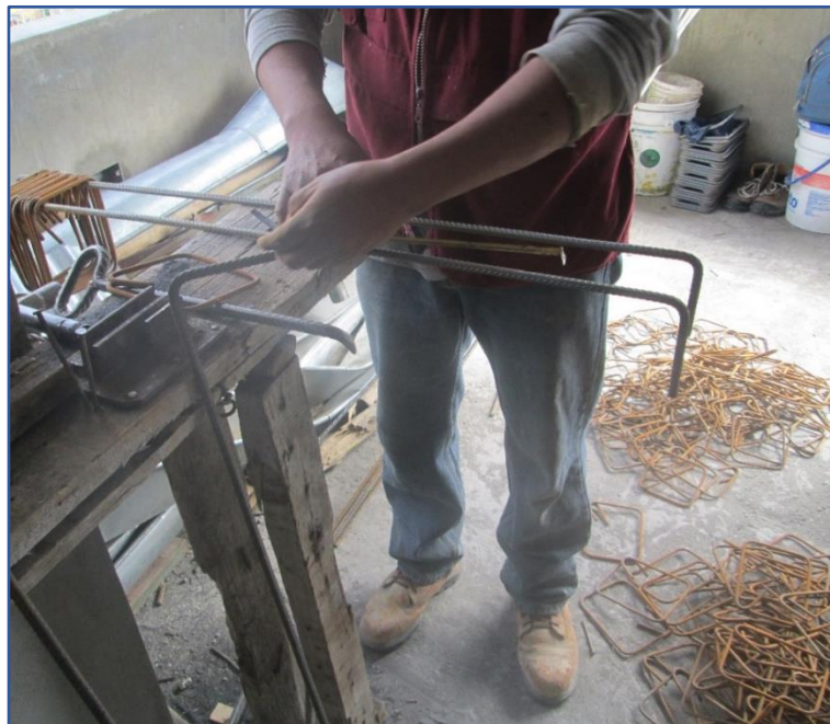
Figura 98: Habilitado y conformación de la armadura de acero de la viga. Fuente: Elaboración propia.
