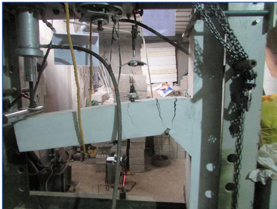
Figura 125: Vista posterior del ensayo del espécimen N° 04 Sección crítica formada al final de la cartela. Fuente: Elaboración propia.
