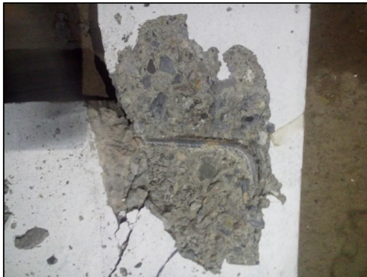
Figura 146: Inspección del anclaje del refuerzo del espécimen N° 01 Fuente: Elaboración propia.
