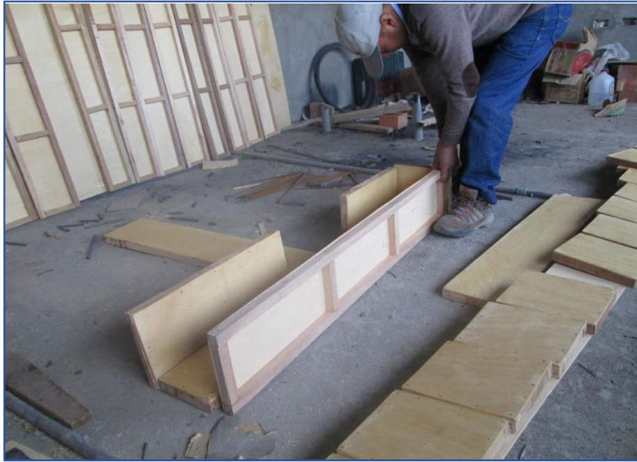
Figura 96: Ensamblaje de los paneles para el encofrado del espécimen. Fuente: Elaboración propia.
