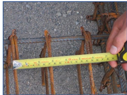
Figura 106: Verificación de la distribución de los estribos en las armaduras.
