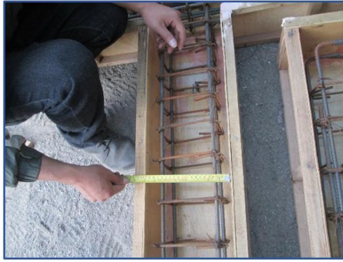
Figura 109: Verificación del peralte de la viga
