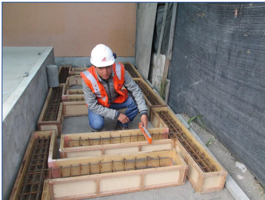
Figura 111: Verificación del nivel horizontal de los encofrados. Fuente: Elaboración propia.
