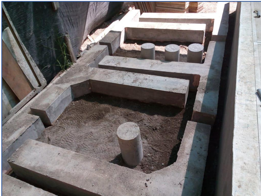
Figura 120: Especímenes totalmente desencofrados a los 28 días de curado en planta antes de ser trasladado al laboratorio. Fuente: Elaboración propia.
