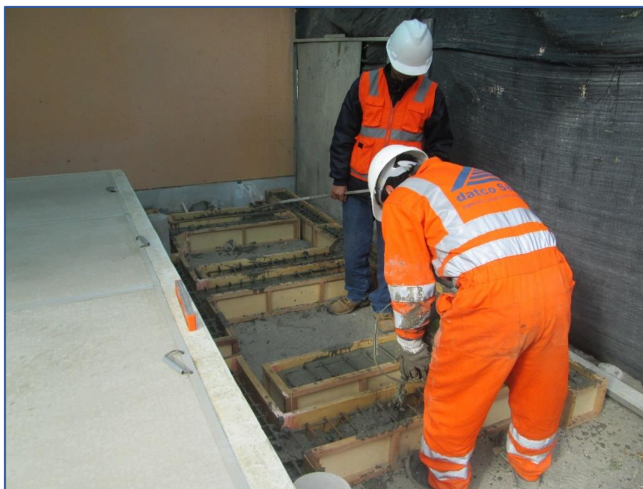
Figura 113: Vaciado del concreto de los especímenes. Fuente: Elaboración propia.
