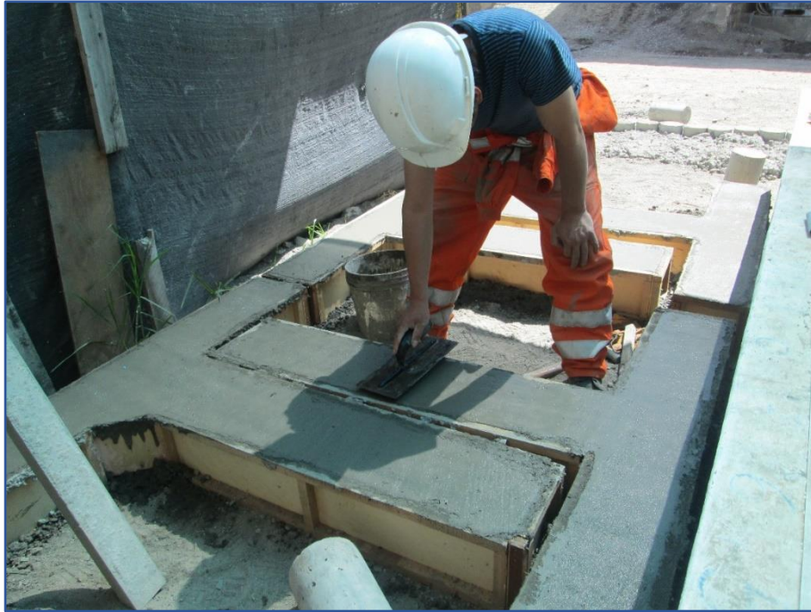
Figura 118: Acabado final de la superficie externa de los especímenes (semi-pulido). Fuente: Elaboración propia.
