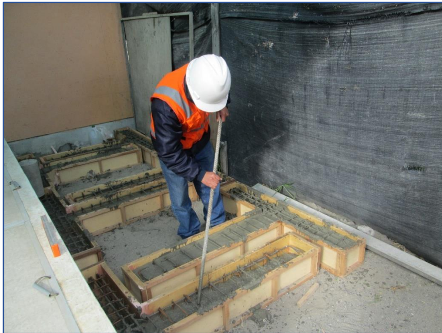
Figura 114: Compactado (chuceo) del concreto de los especímenes Fuente: Elaboración propia.
