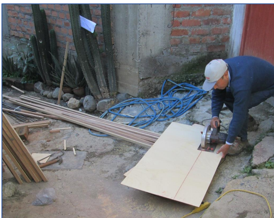
Figura 95: Habilitado y conformación de los paneles de encofrado.
