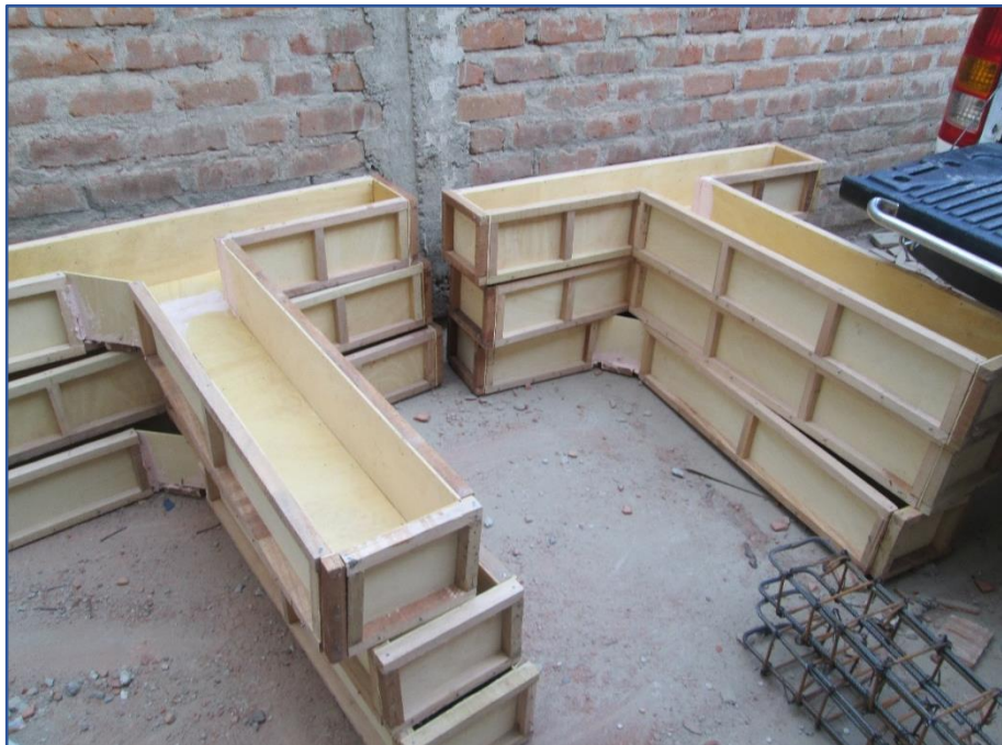
Figura 97: Encofrados o moldes de los 06 especímenes. Fuente: Elaboración propia.
