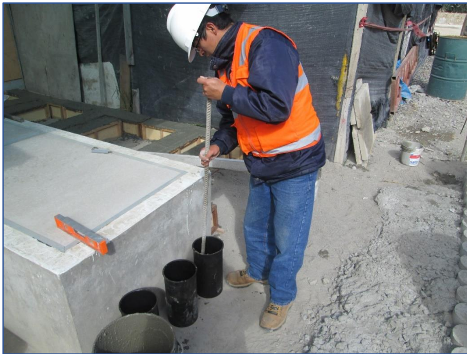
Figura 116: Vaciado y compactado (chuceo) del concreto para la elaboración de probetas. Fuente: Elaboración propia.
