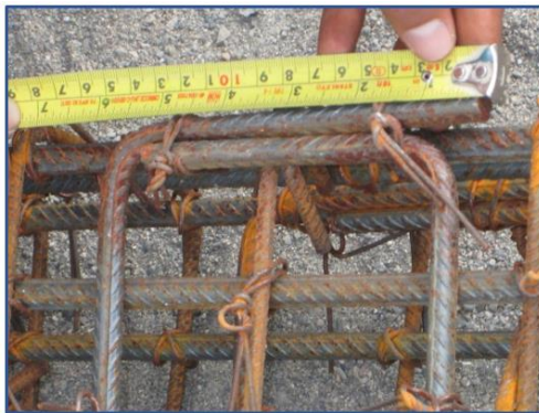
Figura 105: Verificación de las medidas del gancho estándar del acero de la viga.
