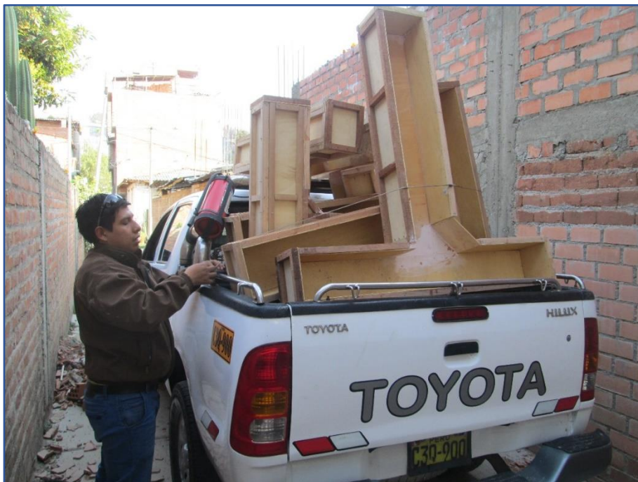
Figura 100: Traslado del encofrado y armadura de acero del espécimen a la planta de concreto. Fuente: Elaboración propia.
