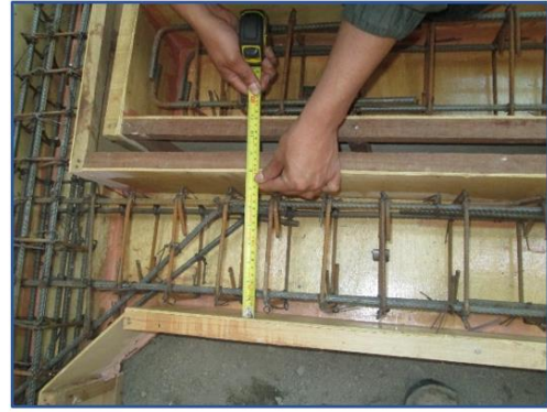
Figura 110: Verificación las dimensiones de la cartela
