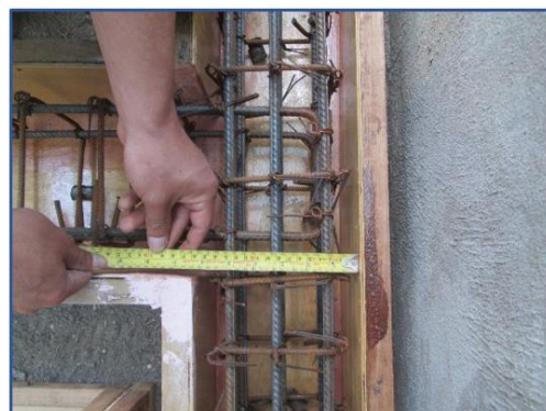
Figura 108: Verificación de las dimensiones en el nudo.
