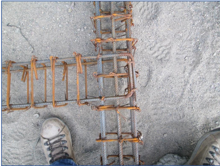
Figura 104: Verificación del correcto ensamblaje de la armadura en el nudo. Fuente: Elaboración propia.
