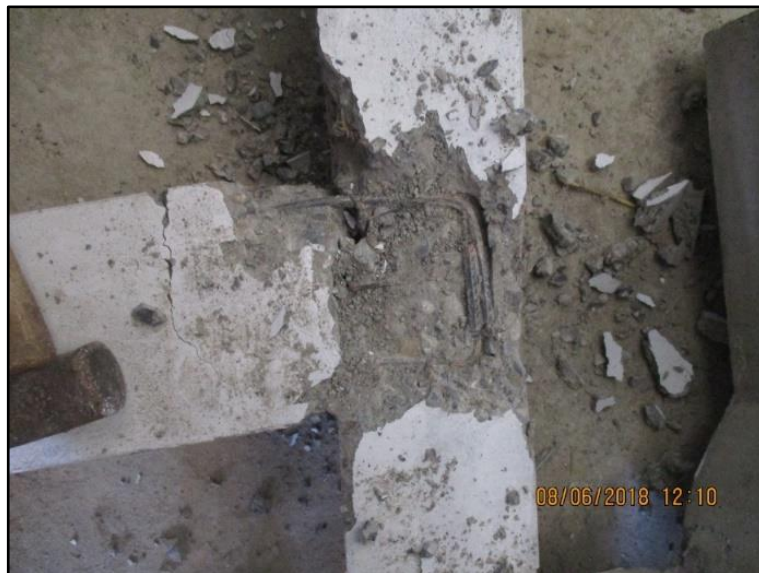
Figura 160: Inspección del anclaje del refuerzo del espécimen N° 03. Fuente: Elaboración propia
