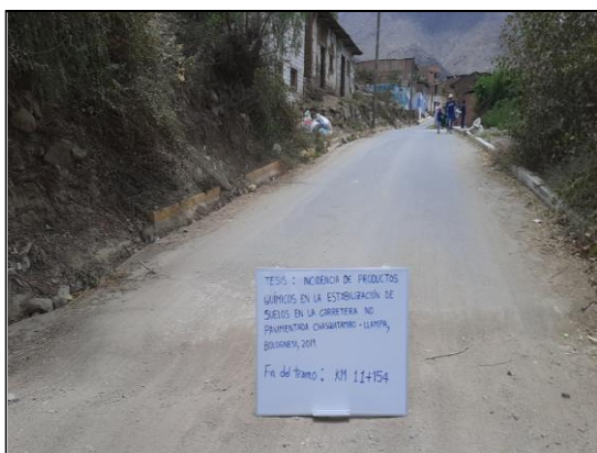
Término de afirmado e Inicio de asfaltado - C.P. de Llama (Progresiva: Km 11+154).
