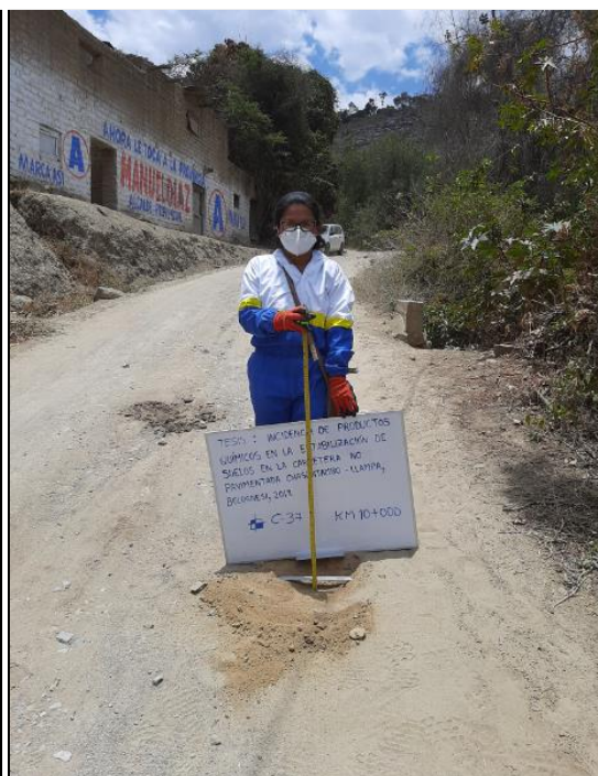
Verificación del espesor de afirmado existente de 0.02m, en la progresiva: Km 10+000.
