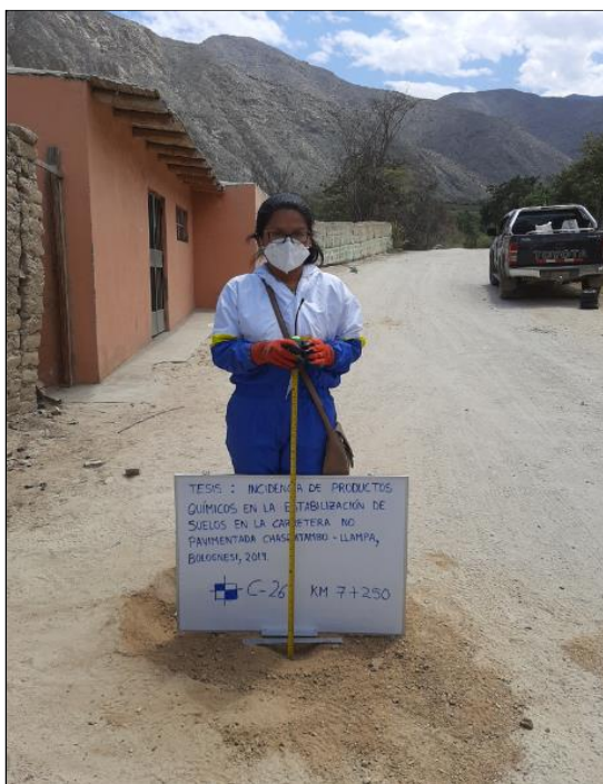
Verificación del espesor de afirmado existente de 0.02m, en la progresiva: Km 07+250.
