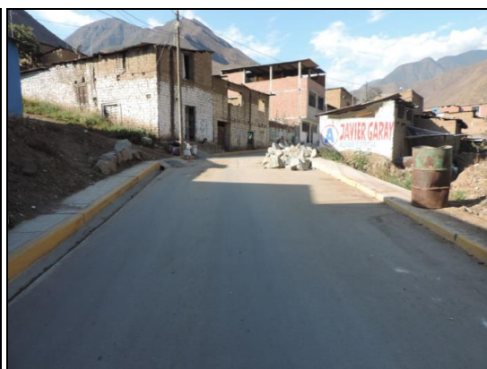
Asfaltado - C.P. de Llama, distrito de Colquioc (Progresiva: Km 11+250).
