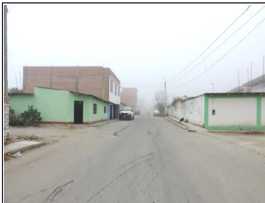
Asfaltado en buen estado de transitabilidad (Progresiva: Km 0+500)
