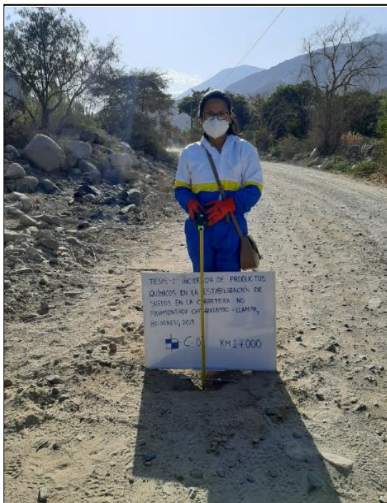
Verificación del espesor de afirmado existente de 0.05m, en la progresiva: Km 01+000.
