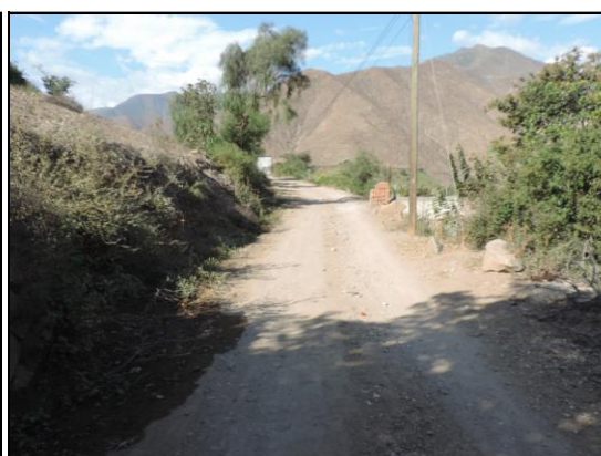
Desgaste del afirmado de la carpeta de rodadura con daños de erosión (L=200m), (Progresiva: Km 11+000).
