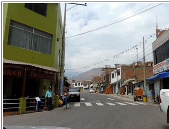
Inicio del Camino Vecinal Emp. PE - 16 (Chasquitambo) - Huayllacayan, (Progresiva: Km 0+000).
