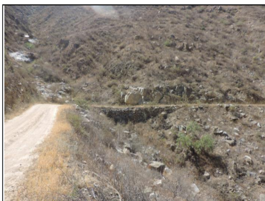
Deposito de Material Excedente, acceso directo, lado derecho (Progresiva: Km 13+780).
