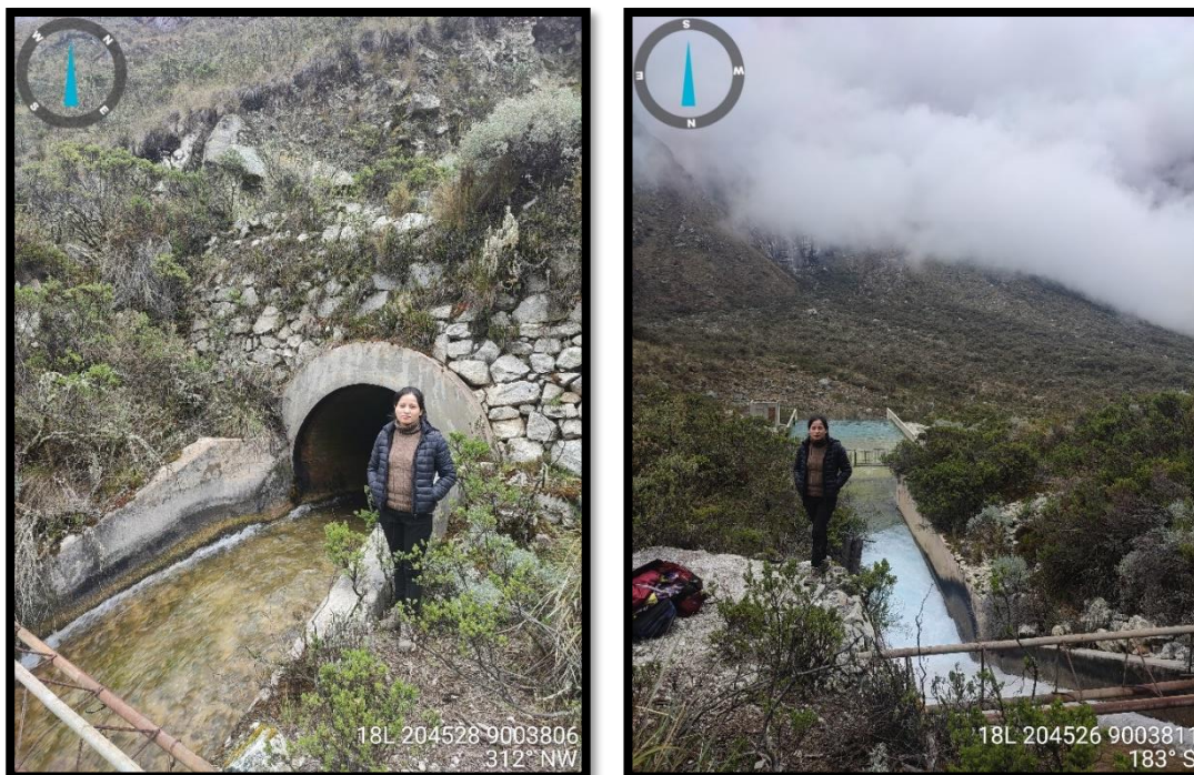
Fotografía 06 – 07: Salida del tunnel de descarga de la Laguna Parón
