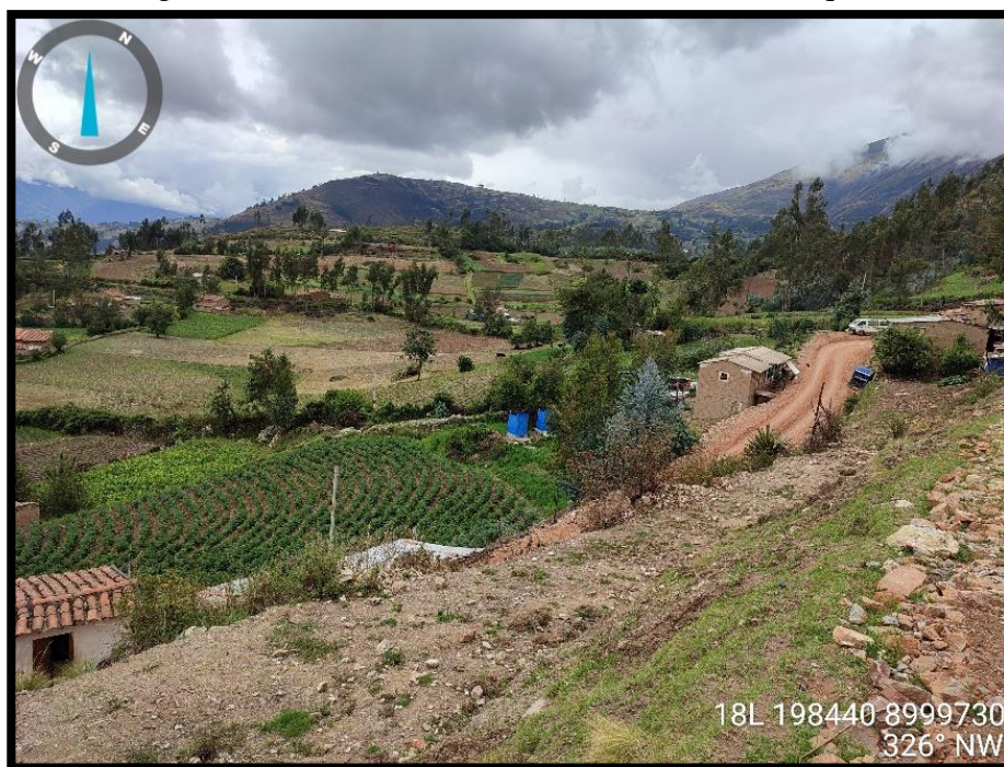
Fotografía 20: Presencia de viviendas aledañas a la quebrada
