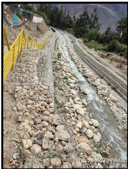
Fotografía 24 - 25: Se observa la llegada del río Llullan llegando a la ciudad de Caraz y cuenta con gaviones de encausamiento
