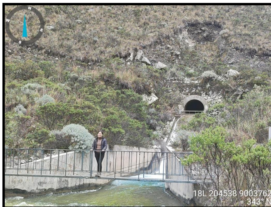
Fotografía 08: Se observa que tunnel de descarga de la Laguna Parón cuenta con un canal rapido y un tanque disipador
