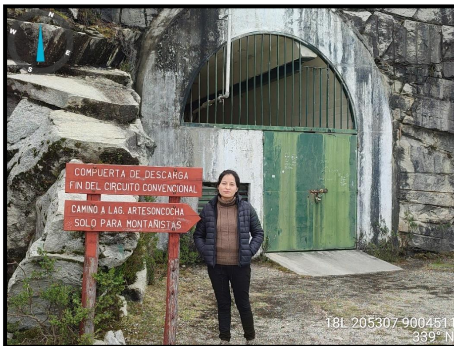
Fotografía 02: Compuerta inicial del túnel de descarga de la Laguna Parón
