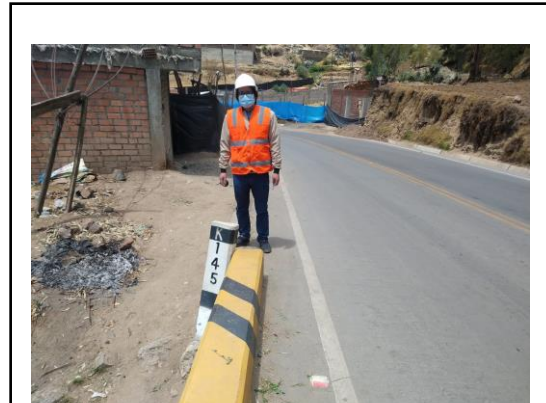
Foto 34: Punto final en el KM 154+000
