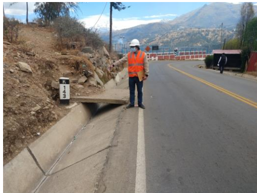
Foto 09: Ubicación del KM 143+000
