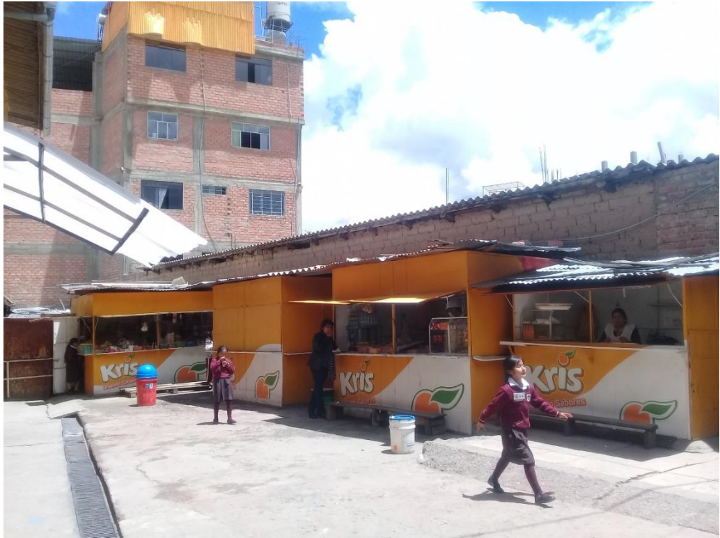
Figura 37. Infraestructura interna de la Institución Educativa “Jorge Basadre Grohman” N.º 86002.
