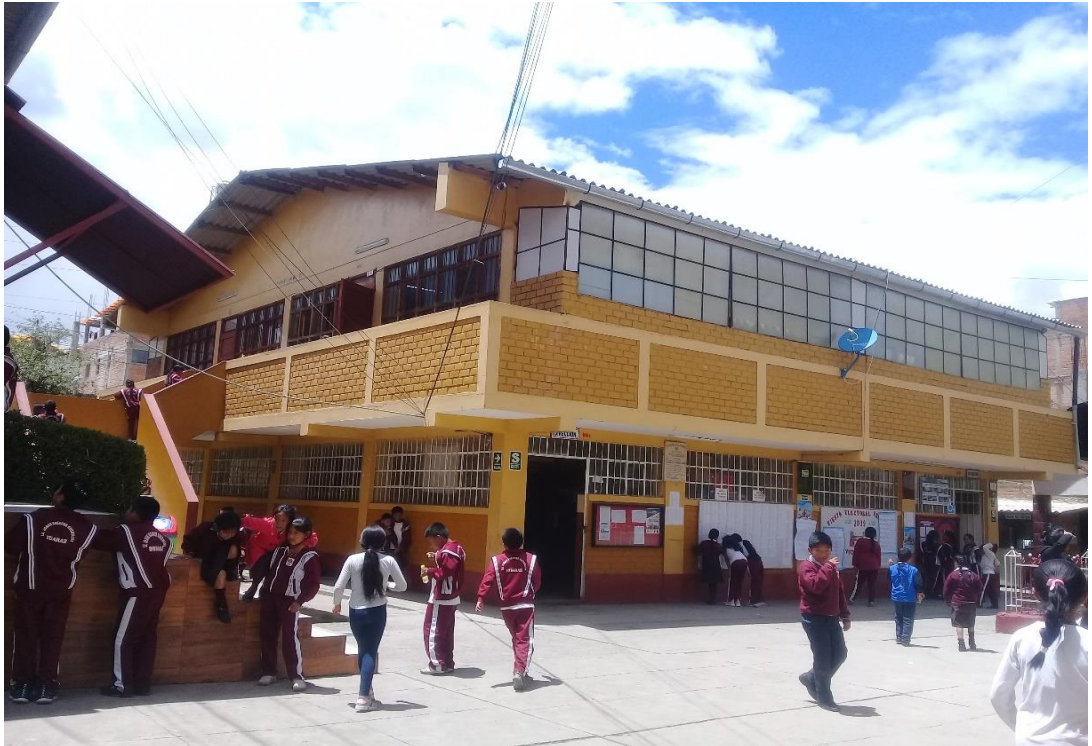
Figura 33. Infraestructura interna de la Institución Educativa “Jorge Basadre Grohman” N.º 86002.
