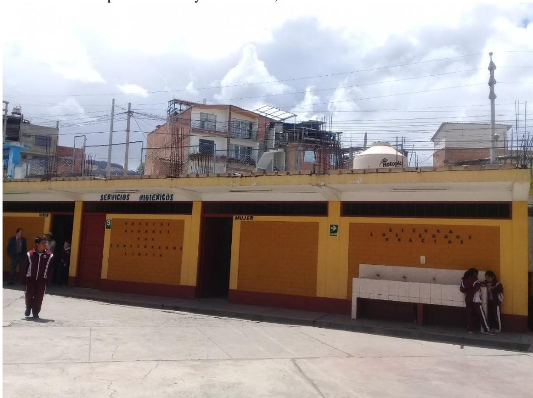
Figura 36. Infraestructura interna de la Institución Educativa “Jorge Basadre Grohman” N.º 86002.
