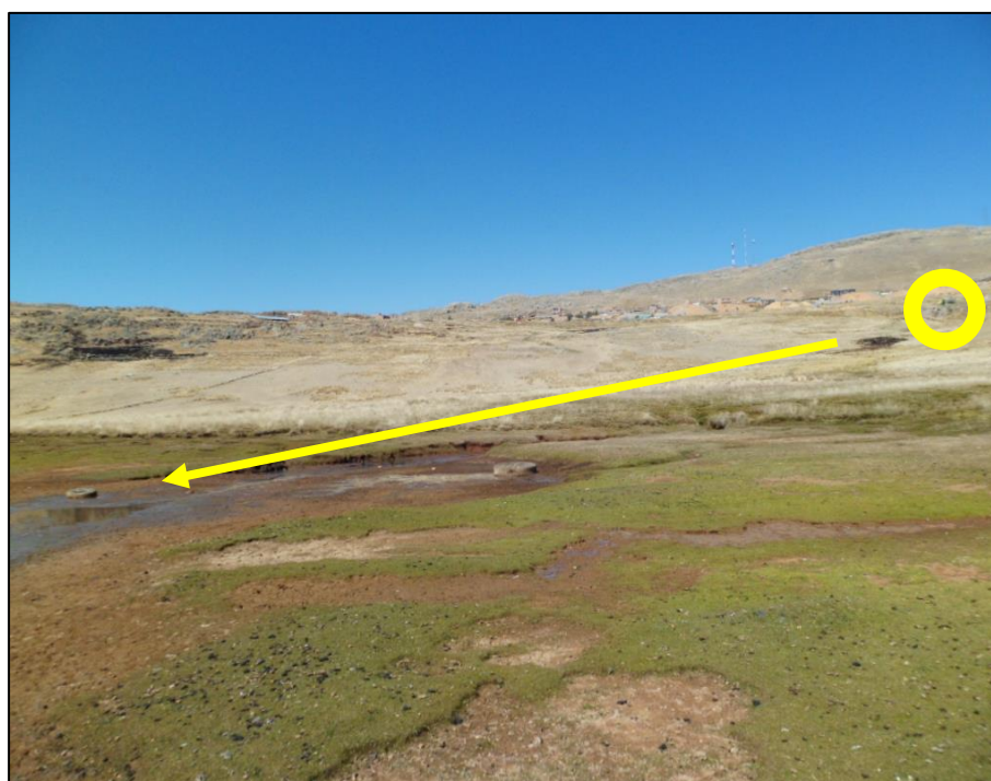
Figura 22. Imagen del efluente de aguas residuales y residuos sólidos
