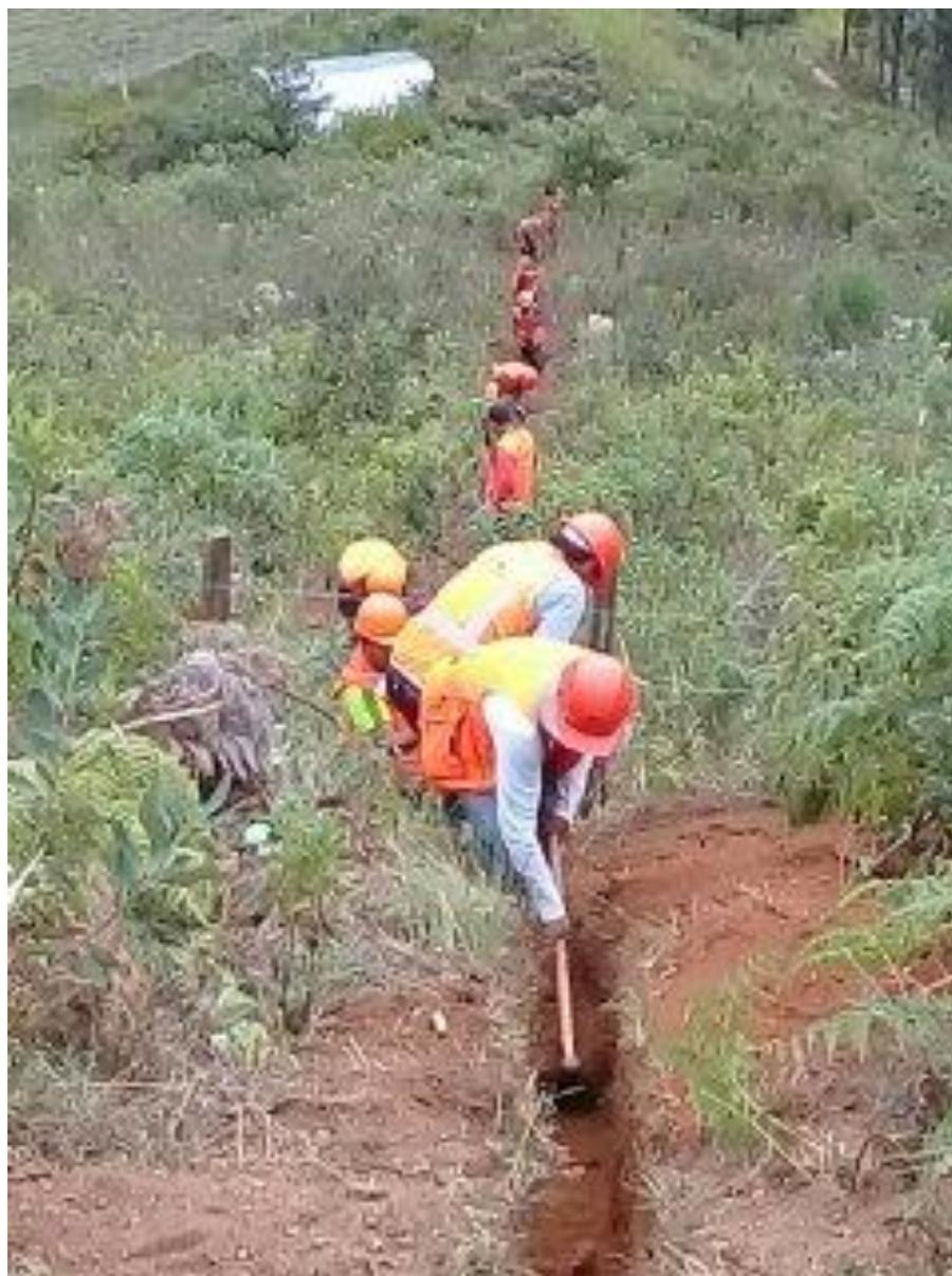
**Figura 60:** *Proceso de excavación de zanja.*
