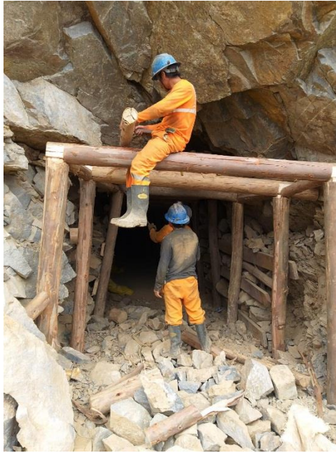
Fotografía N° 3. Reforzamiento de la entrada al nivel 2040.
