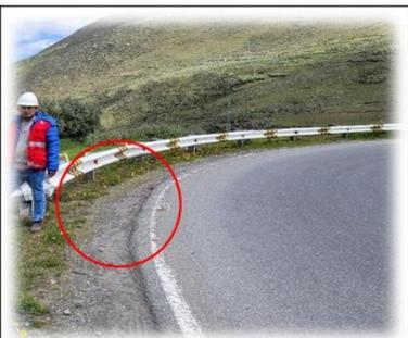
**Foto 3:** Km. 115+900, existen desniveles entre la berma y el asfalto.
