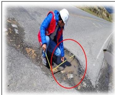
**Foto 2:** Km. 111+900, charcos de agua, asfalto en mal estado.
