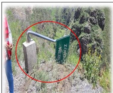
**Foto 8:** Km. 98+000, señalización vertical malograda.
