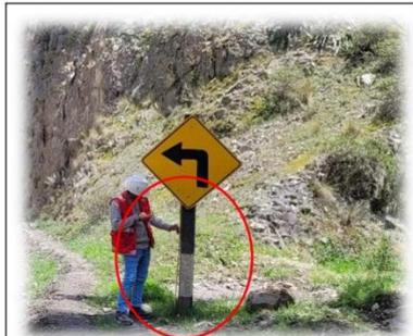
**Foto 8:** Km. 103+000, señalización vertical en mal estado.
