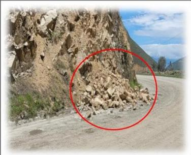
**Foto 7:** Km. 100+200, derrumbes en la vía, no hay asfalto.
