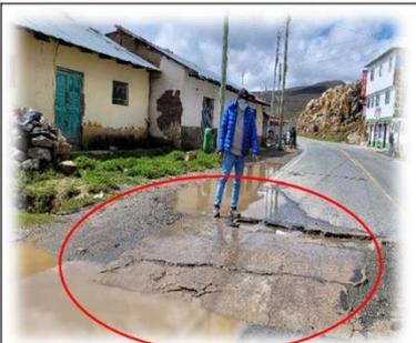
**Foto 1:** Km. 118+600, fallas de asfalto, pista en mal estado.
