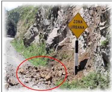
**Foto 6:** Km. 97+300, no hay asfalto y se aprecian derrumbes.
