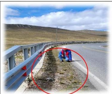
**Foto 1:** Km. 118+200, el ancho de la berma no es suficiente ante averías de un automóvil.
