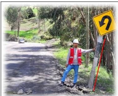
**Foto 5:** Km. 104.800+000, señalización vertical inclinada.
