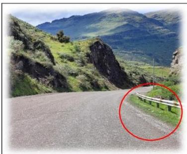
**Foto 6:** Km. 104+800, no se puede apreciar la diferencia entre la berma y la vía.
