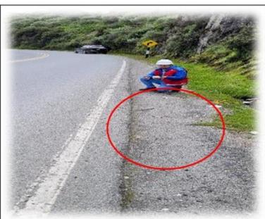
**Foto 5:** Km. 119+100, desniveles entre el asfalto y las bermas.
