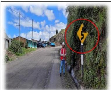
**Foto 3:** Km. 108+000, señalización vertical incompleta.
