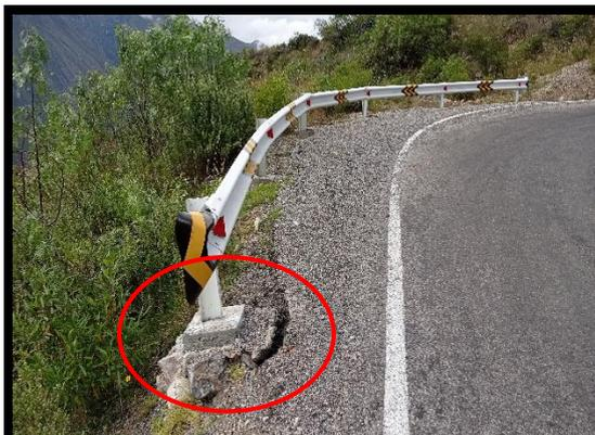
**FOTO 55:** Km 69+260 al km 69+220, base de barrera deteriorada, con peligro de deslizamiento.
