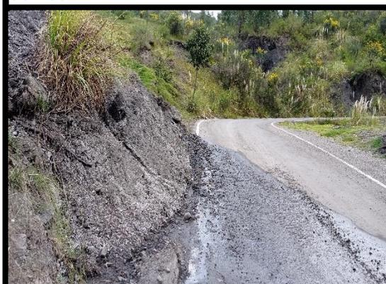
**FOTO 15:** Km 73+960 al km 73+940, se observa el deslizamiento del talud obstruyendo la cuneta y la vía, producto de la filtración de agua.
