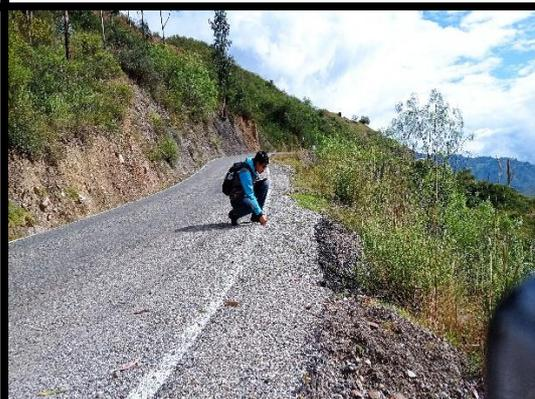
**FOTO 58:** Km 68+940 al km 68+920, se encuentra una berma con erosión en la parte lateral.
