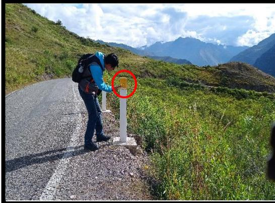
**FOTO 49:** Km 69+840 al km 69+820, delineadores con los elementos retrorreflectivos deteriorados.
