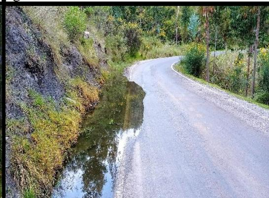
**FOTO 18:** Km 73+680 al km 73+660, se observa la obstrucción de la cuneta y la presencia de agua acumulada en la vía.
