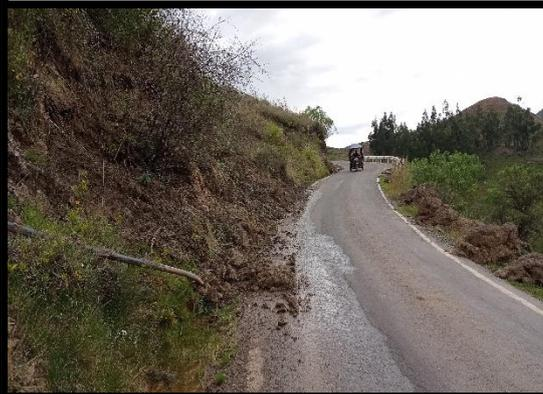
**FOTO 27:** Km 72+240 al km 72+220, se observa el deslizamiento del talud obstruyendo la cuneta y la vía, producto de las constantes lluvias.
