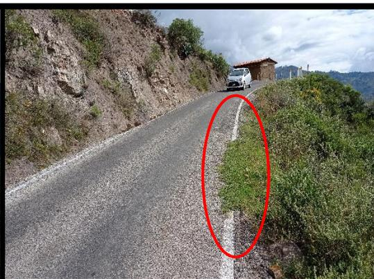
**FOTO 62:** Km 68+540 al km 68+520, se observa la demarcación de la calzada borrada, debido a la maleza aladaña.
