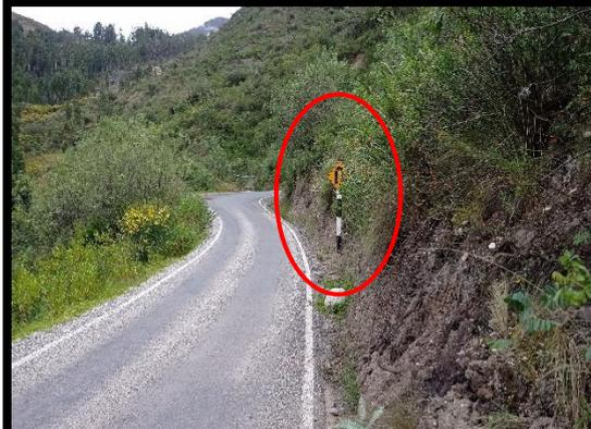
**FOTO 23:** Km 73+220, se encuentra una señalización vertical cubierta por la vegetación.
