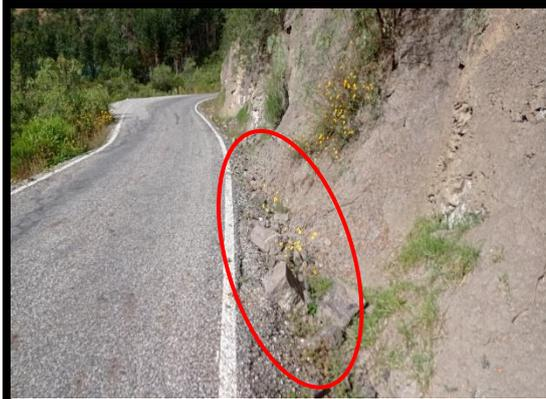
**FOTO 51:** Km 69+700 al km 69+680, obstrucción de cuneta debido al deslizamiento de las rocas del talud.
