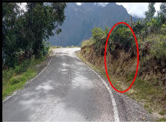
**FOTO 71:** Km 68+020 al km 68+000, curva cerrada sin la debida señalización vertical preventiva correspondiente.
