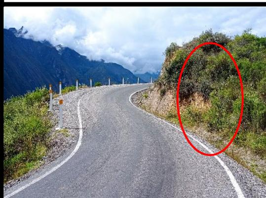
**FOTO 66:** Km 68+380 al km 68+360, curva cerrada sin la debida señalización vertical preventiva correspondiente.
