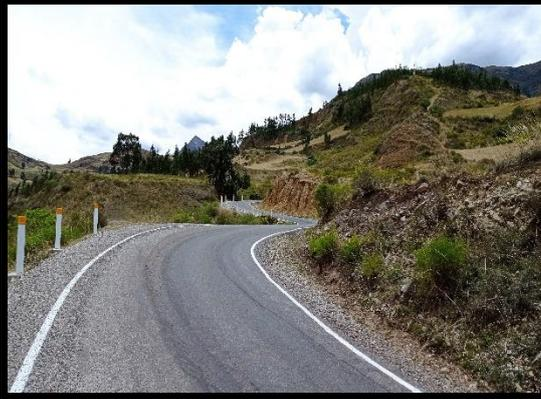
**FOTO 67:** Km 68+240 al km 68+200, curva sinuosa sin la longitud de tangente mínima.
