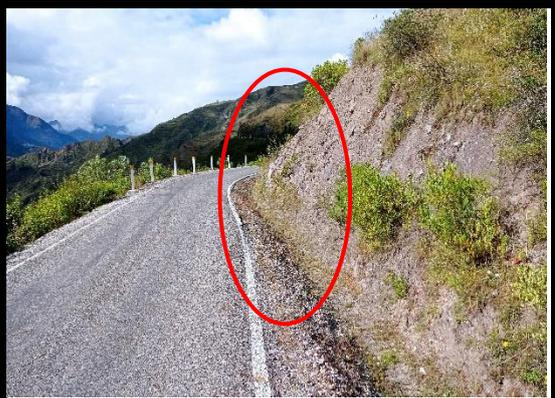
**FOTO 48:** Km 69+940 al km 69+920, curva cerrada sin la debida señalización vertical preventiva correspondiente.
