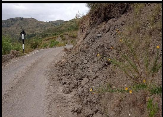
**FOTO 30:** Km 72+020 al km 72+000, se observa el deslizamiento del talud obstruyendo la cuneta y la vía, producto de las constantes lluvias.
