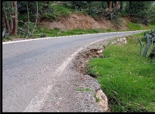
**FOTO 01:** Km 74+720 al km 74+700, se observa el deslizamiento lateral de la plataforma de la vía.
