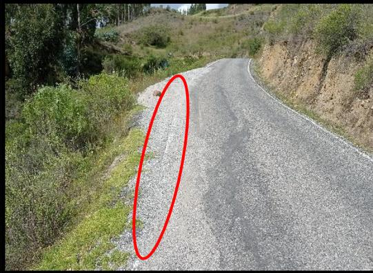
**FOTO 69:** Km 68+100 al km 68+080, se observa la demarcación de la calzada borrosa
