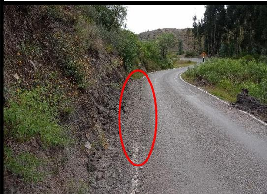
**FOTO 29:** Km 72+160 al km 72+140, se observa la demarcación de pavimento borrosa, debido a los constantes derrumbes del talud.
