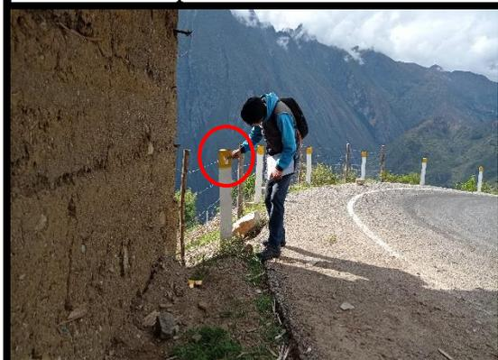
**FOTO 63:** Km 68+500 al km 68+460, delineador con los elementos retrorreflectivos deteriorados
