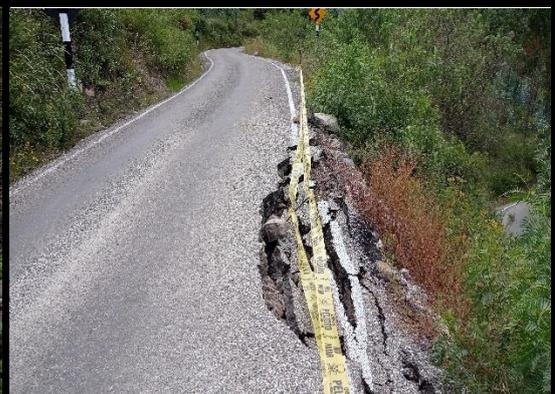
**FOTO 24:** Km 73+060 al km 73+040, se observa el deslizamiento lateral de la plataforma de la vía.
