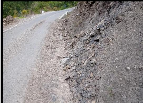
**FOTO 21:** Km 73+300 al km 73+280, se observa el deslizamiento del talud obstruyendo la cuneta y la vía, producto de las constantes lluvias.
