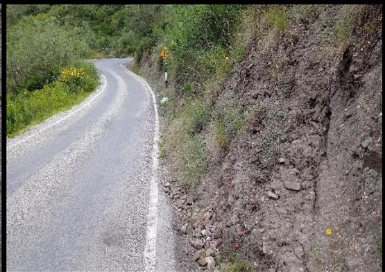
**FOTO 22:** Km 73+160 al km 73+140, se observa el deslizamiento del talud obstruyendo la cuneta y la vía, producto de las constantes lluvias.
