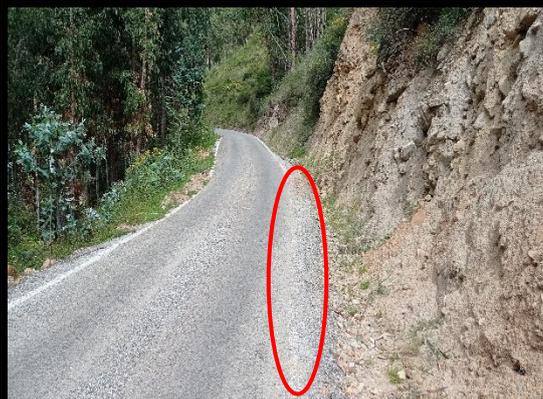
**FOTO 75:** Km 67+120 al km 67+100, se observa la demarcación de la calzada borrosa.
