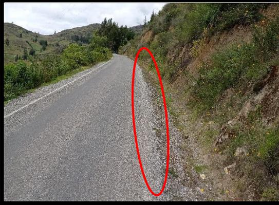
**FOTO 73:** Km 67+440 al km 67+420, se observa la demarcación de la calzada borrosa.
