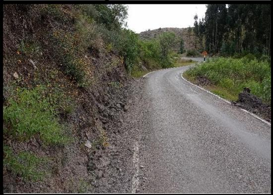
**FOTO 28:** Km 72+140 al km 72+120, se observa el deslizamiento del talud obstruyendo la cuneta y la vía, producto de las constantes lluvias.
