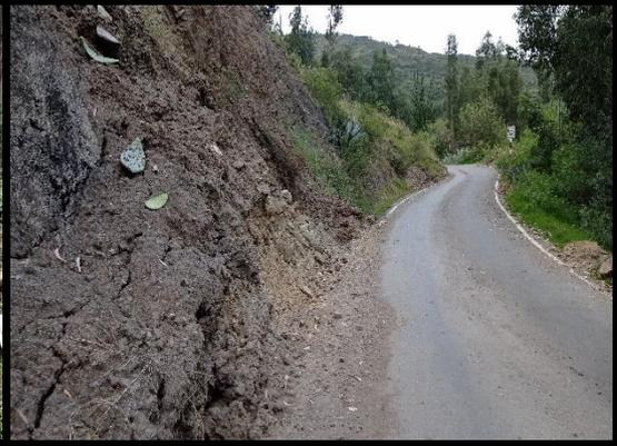
**FOTO 08:** Km 74+360, se observa el deslizamiento del talud, obstruyendo la cuneta y la vía, producto de las constantes lluvias; con el peligro de volver a caer e interrumpir la vía.
