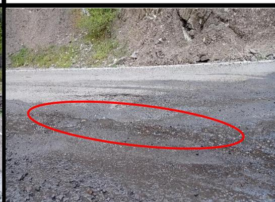
**FOTO 16:** Km 73+970 al km 73+960, se observa la deformación de la plataforma de la vía, producto del flujo constante de agua.
