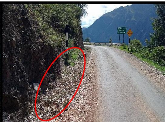
**FOTO 80:** Km 66+420 al km 66+400, se observa la obstrucción de cuneta con ramas y palos, esto debido a la tala de árboles por parte de los pobladores.
