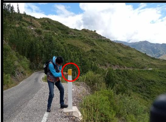
**FOTO 53:** Km 69+500 al km 69+480, delineador con los elementos retrorreflectivos deteriorados.
