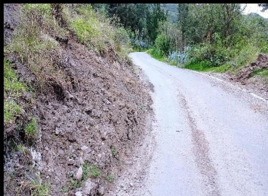
**FOTO 11:** Km 74+300, se observa el deslizamiento de talud obstruyendo la cuneta y la vía, producto de las constantes lluvias; con el peligro de volver a caer e interrumpir la vía.
