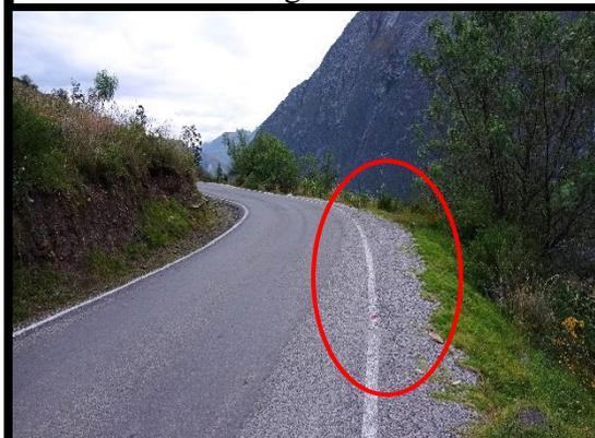
**FOTO 17:** Km 73+860 al km 73+840, se encuentra una curva cerrada sin la debida señalización correspondiente.
