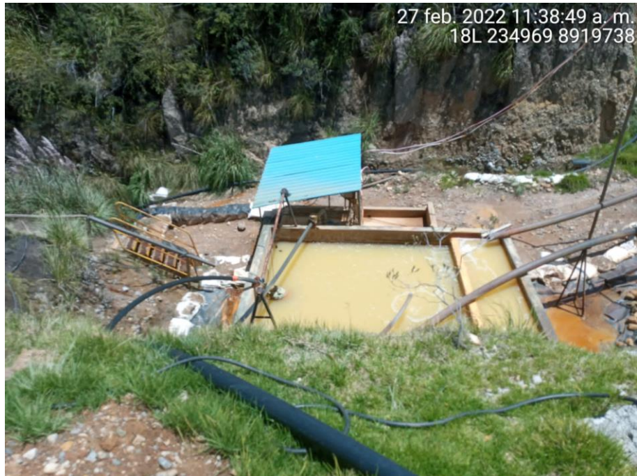
Poza de recirculación de relave de la Corporación Minera Toma La Mano.
