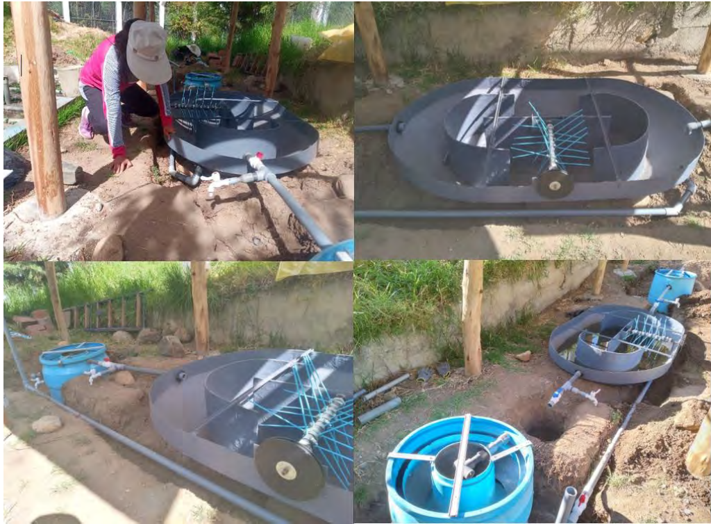
Imagen 18. Instalación de la tubería de recirculación de lodos
