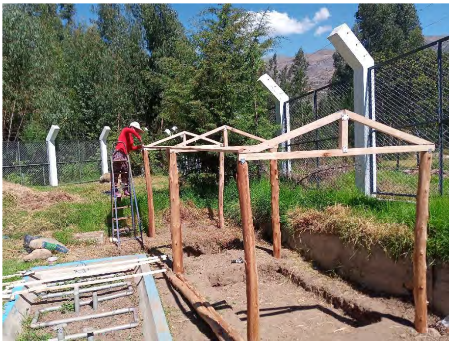
Fotografía 35. Instalación estructura del techo de madera
