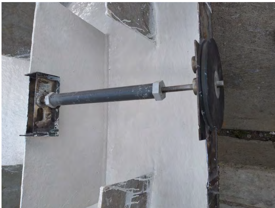
Fotografía 13. Medio de soporte del aireador
