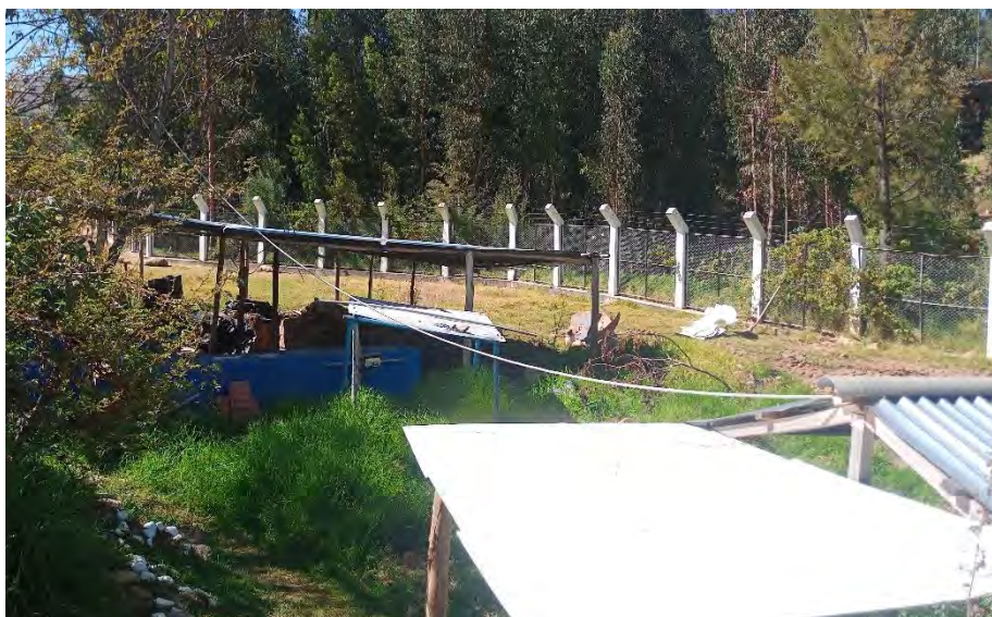
Fotografía 57. Instalación del cable vulcanizado para la alimentación de la energía eléctrica
