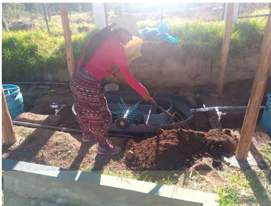
Fotografía 49. Relleno y compactación de la zanja de la tubería de recirculación
