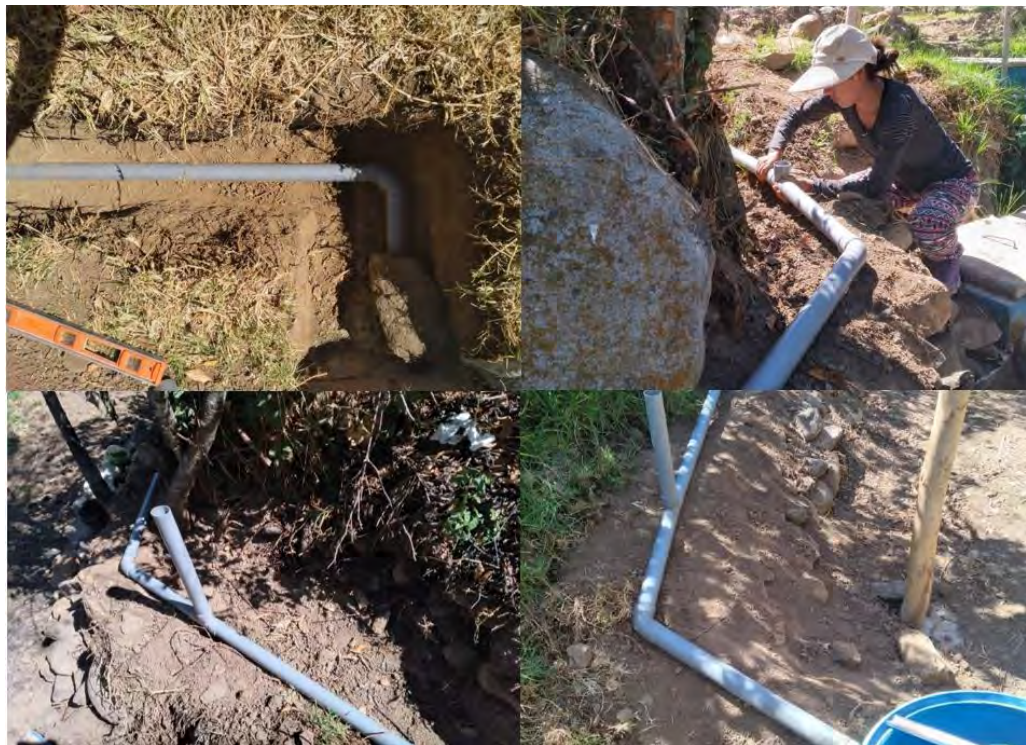
Imagen 14. Instalación de la línea de conducción a la PTAR ICS
