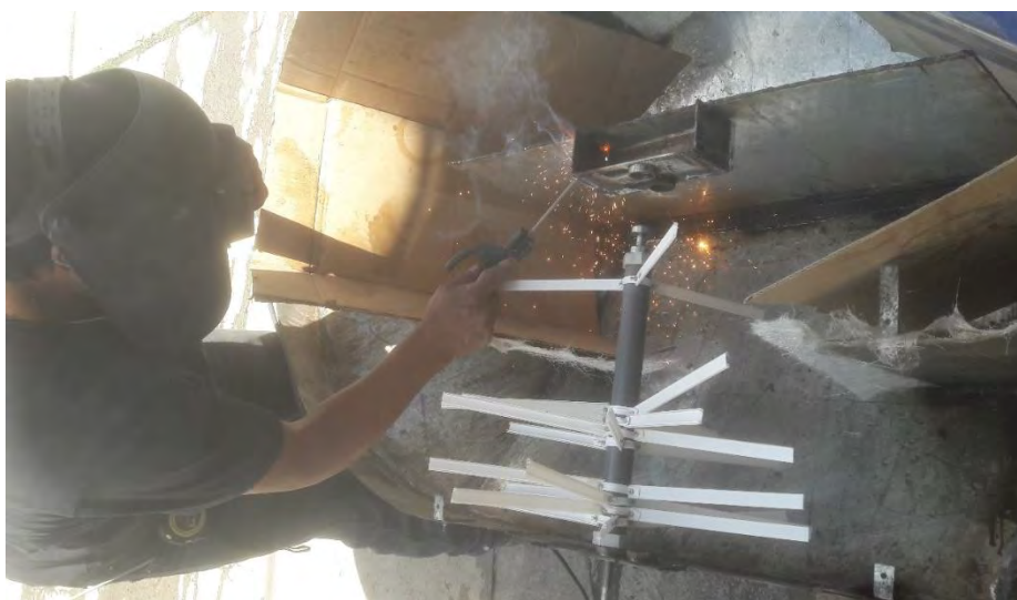
Fotografía 11. Soldadura de la pantalla vertical
