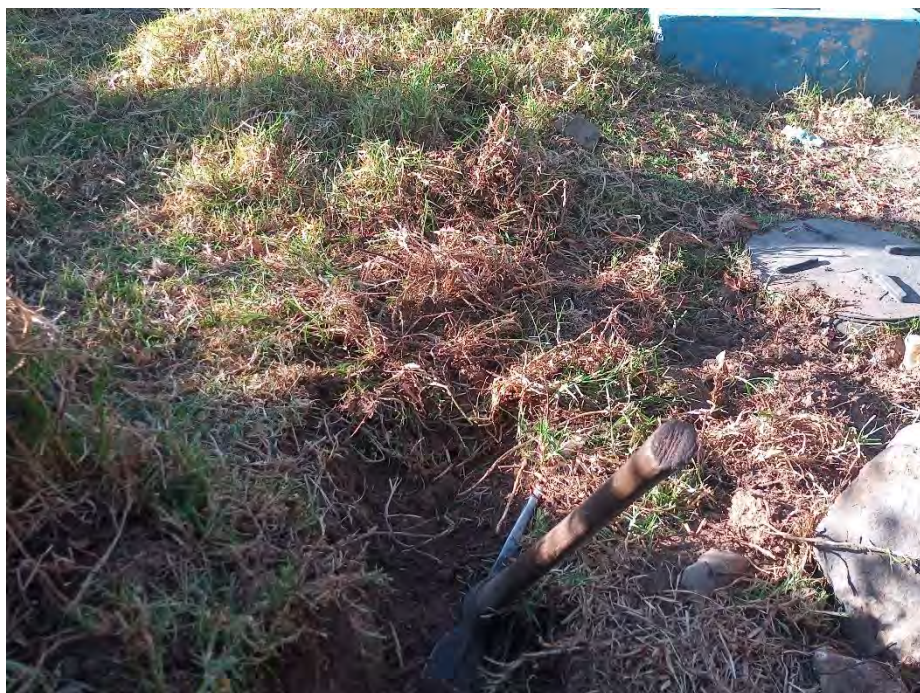
Fotografía 28. Excavación de la línea de conducción.
