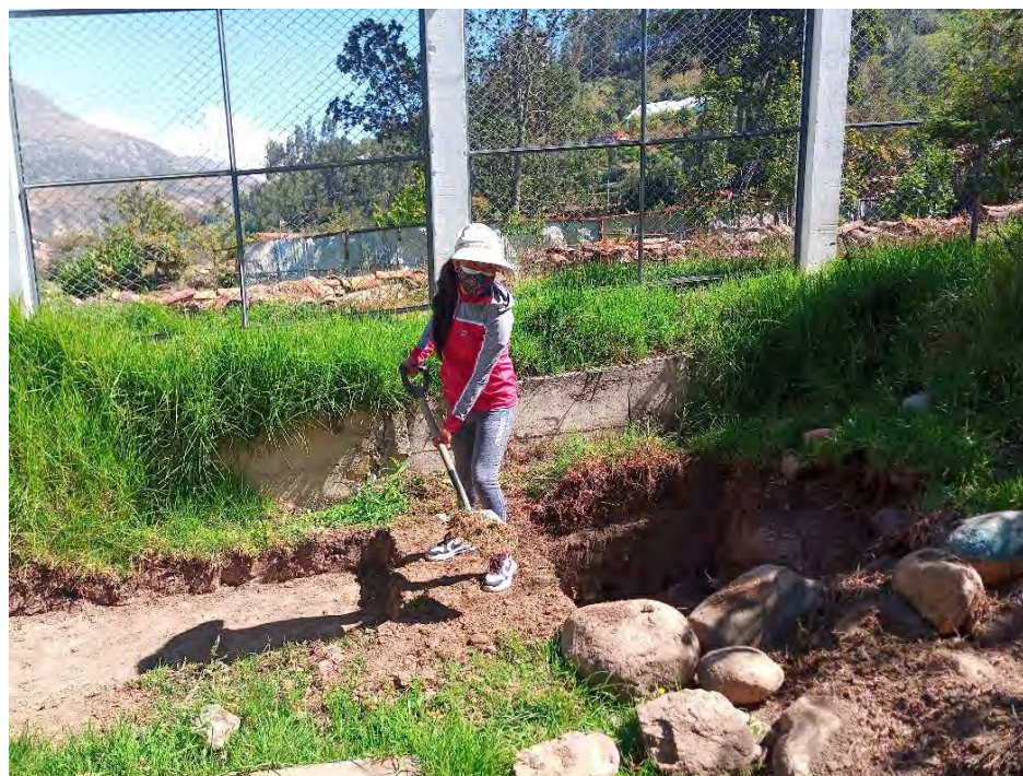
Fotografía 29. Excavación en el área del zanjón
