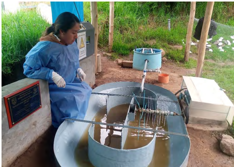
Fotografía 71. Puesta en marcha y operación de la unidad de tratamiento
