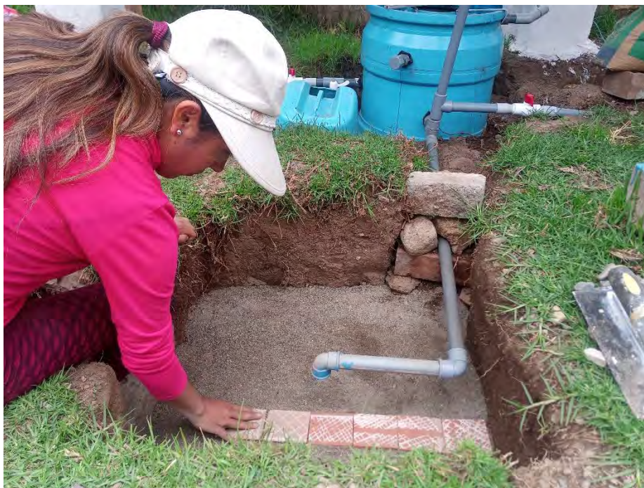
Fotografía 63. Incorporación de ladrillos pasteleros a escala para el lecho de secado
