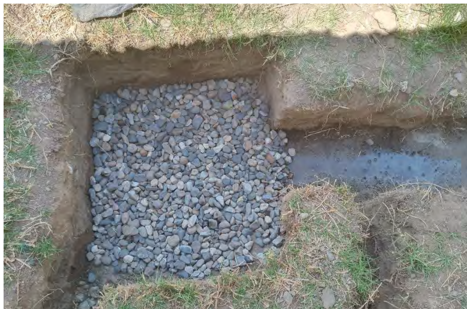
Fotografía 62. Incorporación de grava para el lecho de secado
