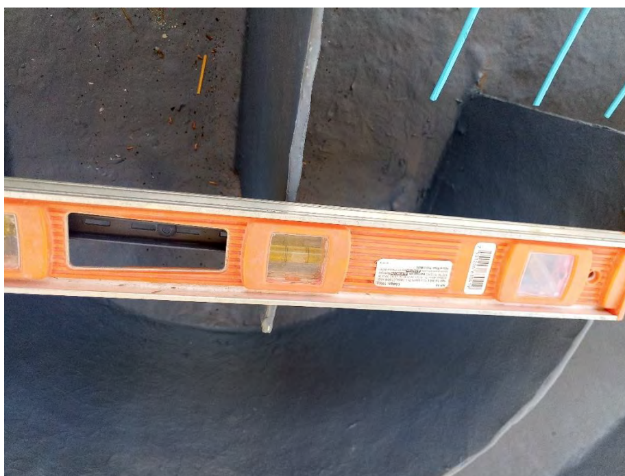
Fotografía 44. Comprobación de la horizontalidad del nivel de burbuja
