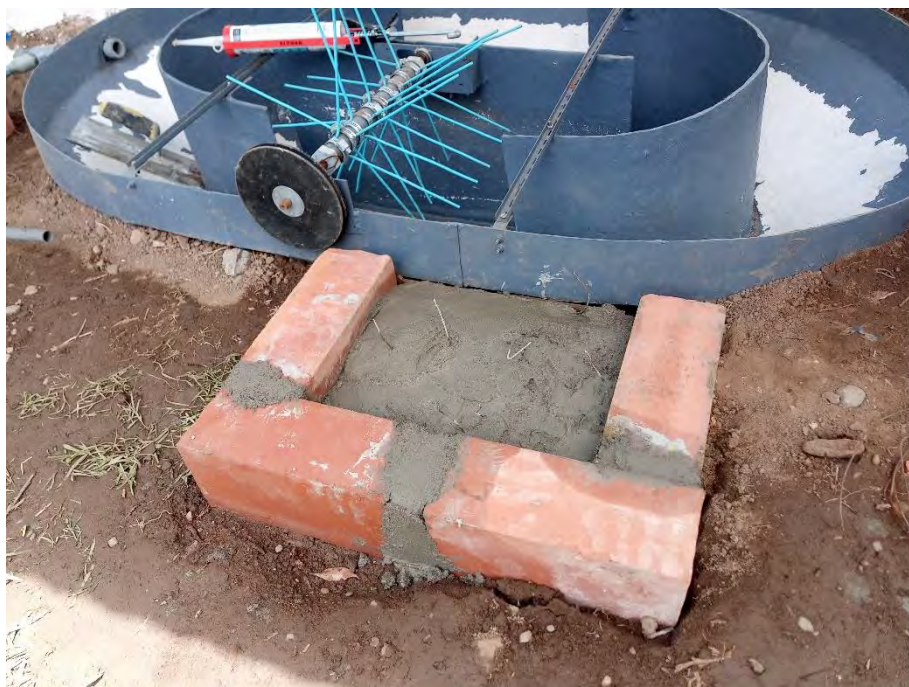
Fotografía 54. Construcción de la base para el motor eléctrico
