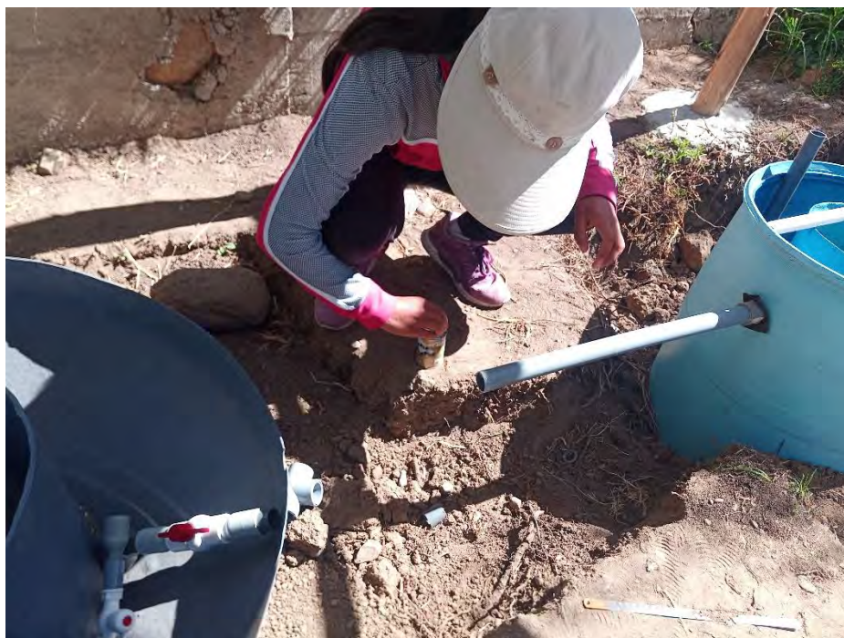
Fotografía 51. Instalación de la tubería de entrada
