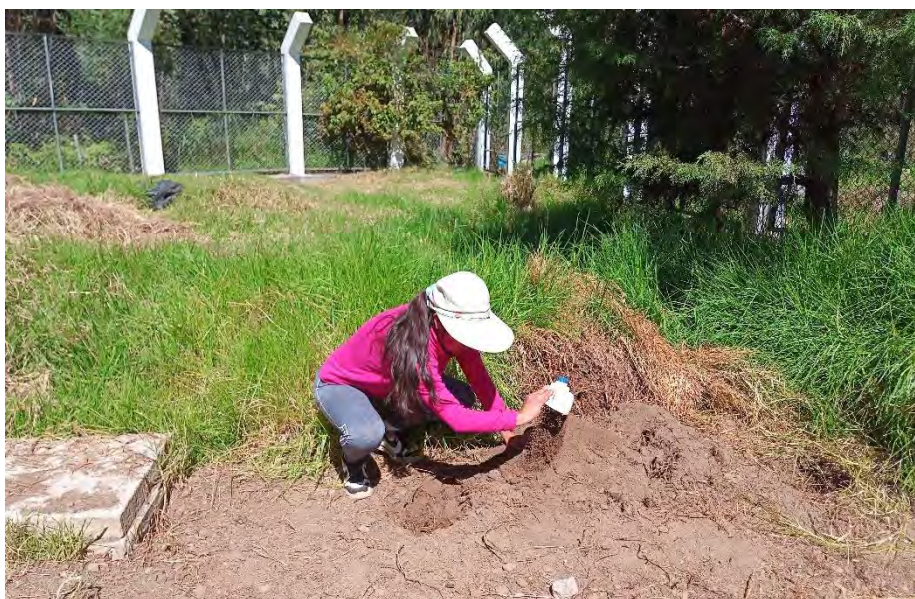
Fotografía 32. Hoyo de 30 x 30 cm para colocar los postes de madera
