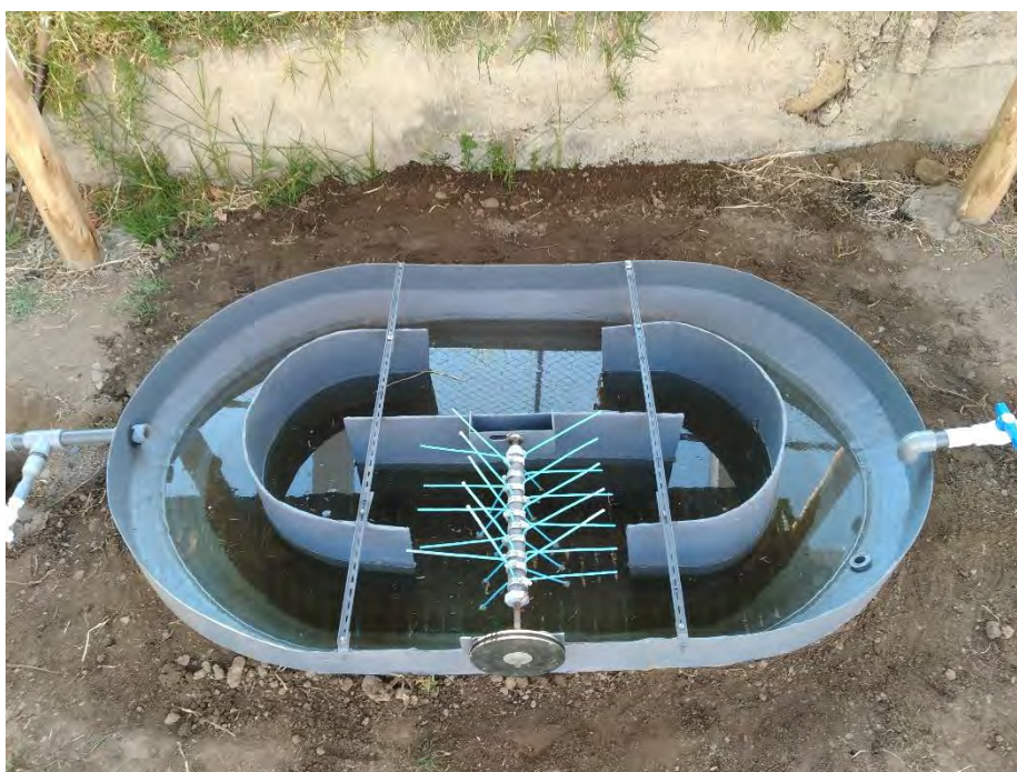
Fotografía 50. Relleno y compactación final de la zanja de oxidación
