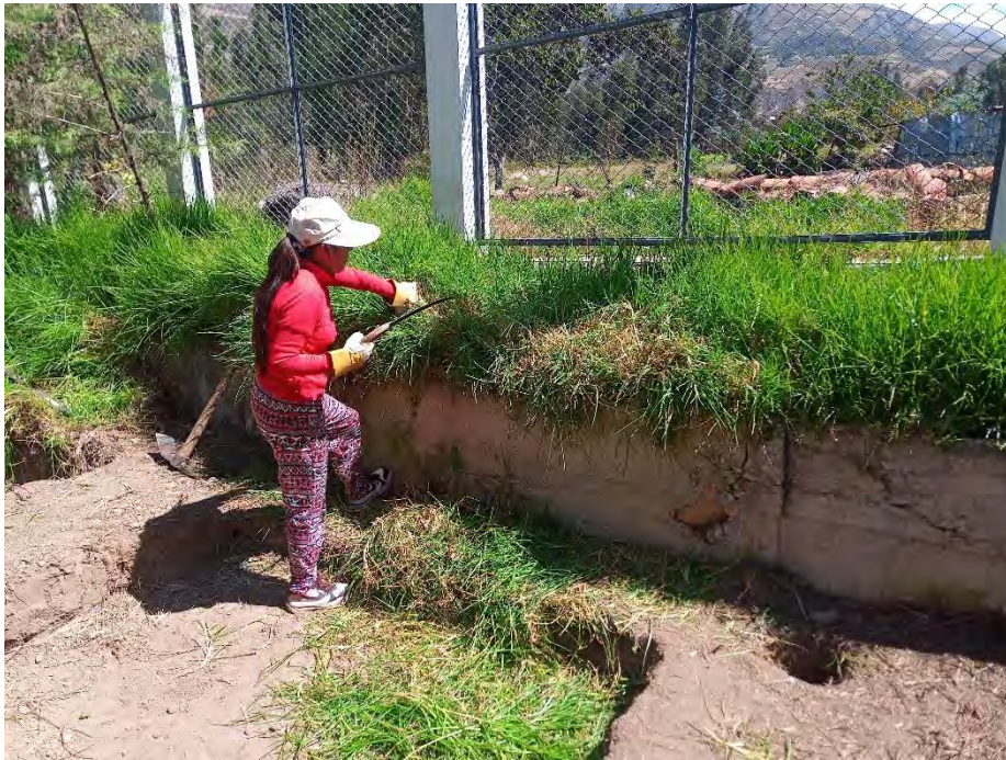
Fotografía 25. Limpieza del área de terreno
