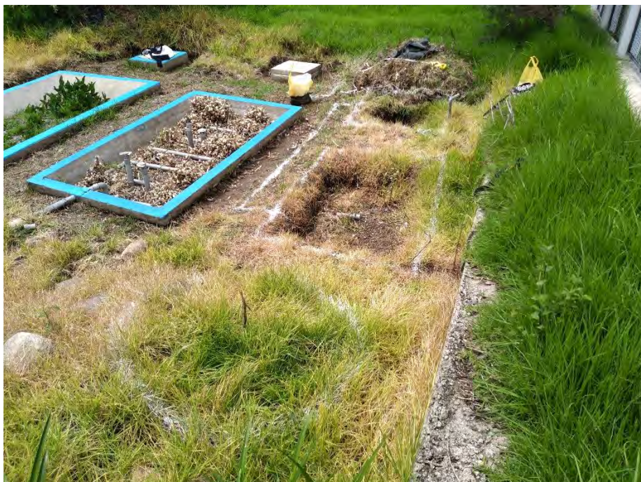
Fotografía 27. Trazo y replanteo
