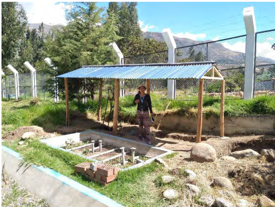
Fotografía 36. Colocación del techo final
