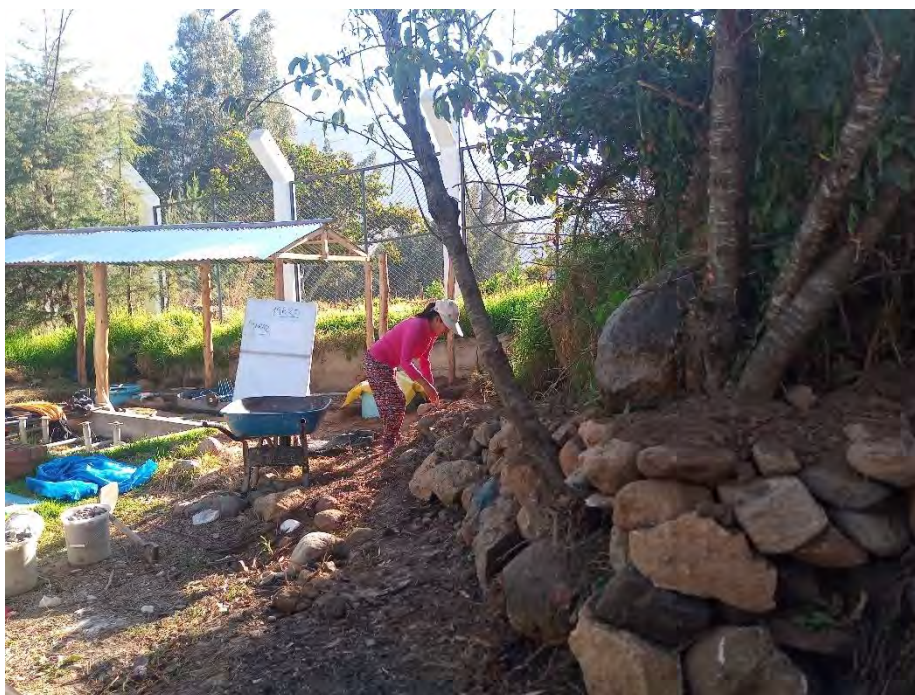
Fotografía 40. Relleno y compactación de la zanja de la línea de conducción
