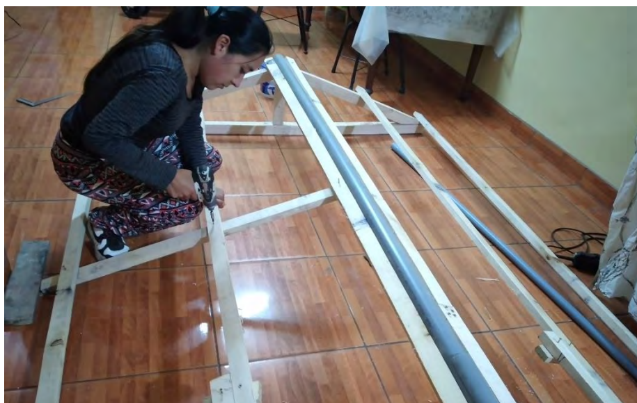
Fotografía 31. Viguetas del techo de madera
