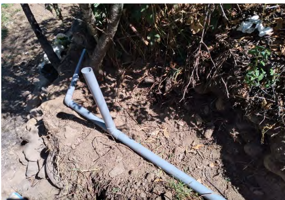
Fotografía 39. Instalación del sombrero de ventilación en la línea de conducción
