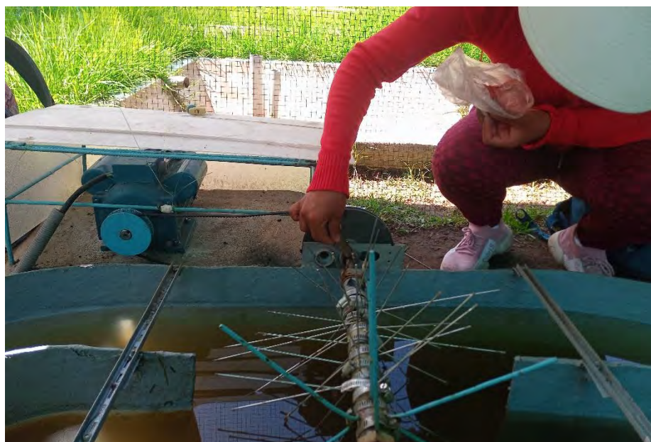
Fotografía 165. Mantenimiento de la polea
