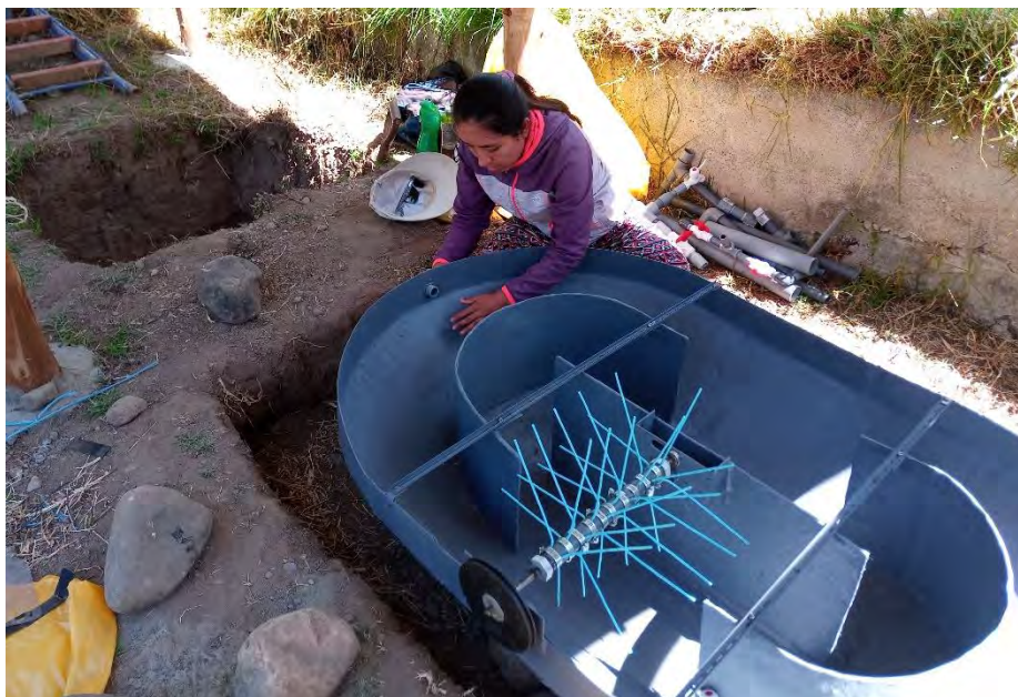
Fotografía 45. Instalación de accesorios
