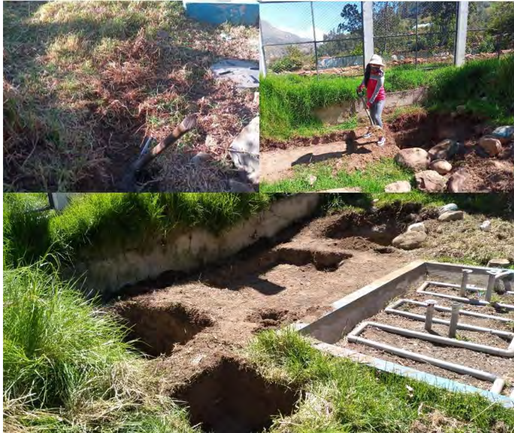
Imagen 11. Excavación manual
