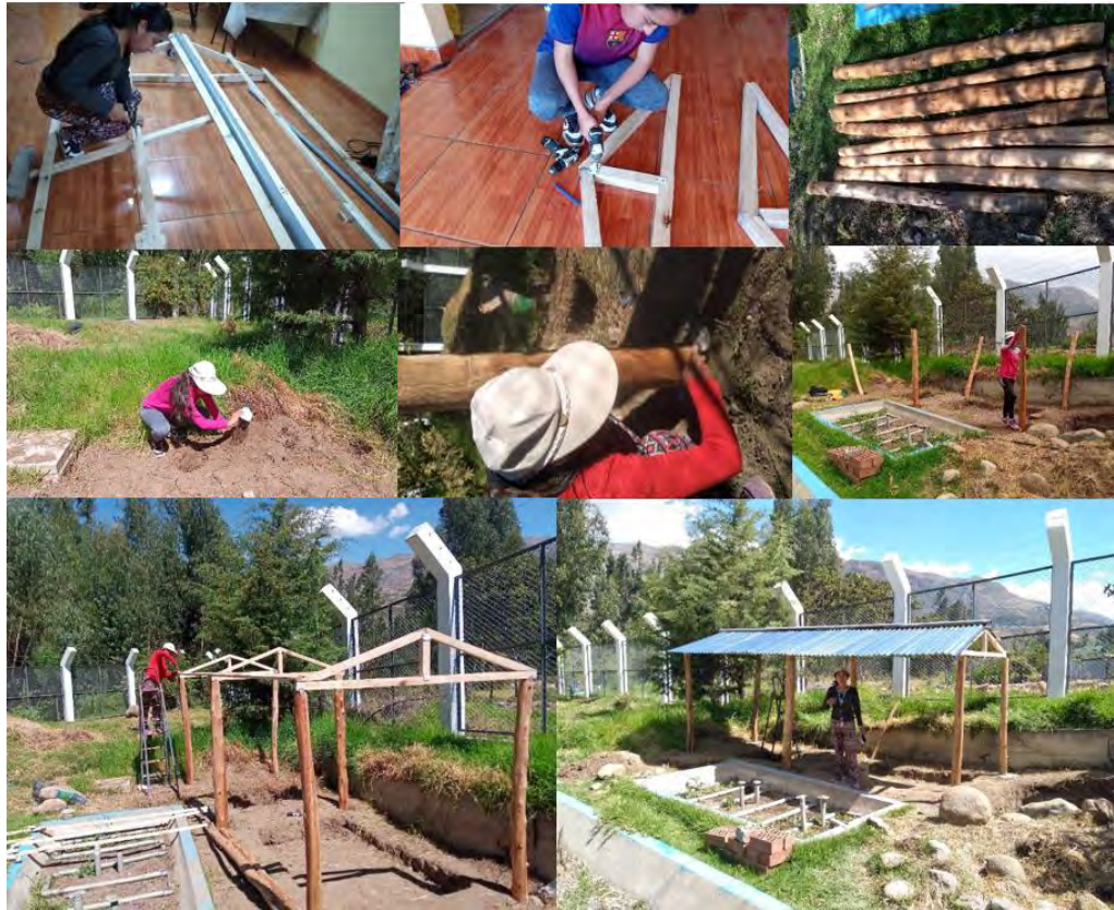
Imagen 12. Instalación del techo
