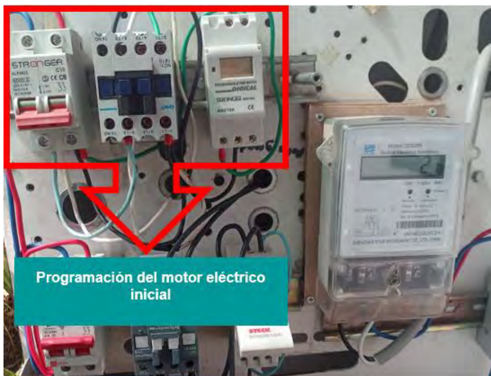
Imagen 25. Programación del funcionamiento del cepillo inicial
