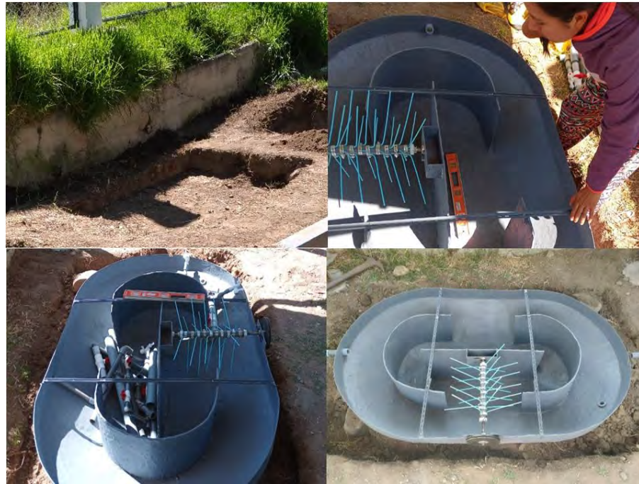
Imagen 15. Instalación del reactor
