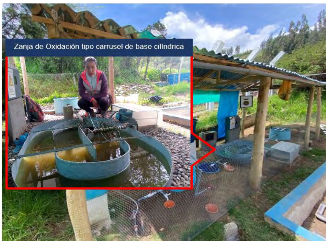
Imagen 2. Ubicación de la Zanja de Oxidación
