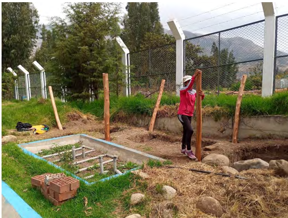
Fotografía 34. Levantamiento de los postes de madera con concreto
