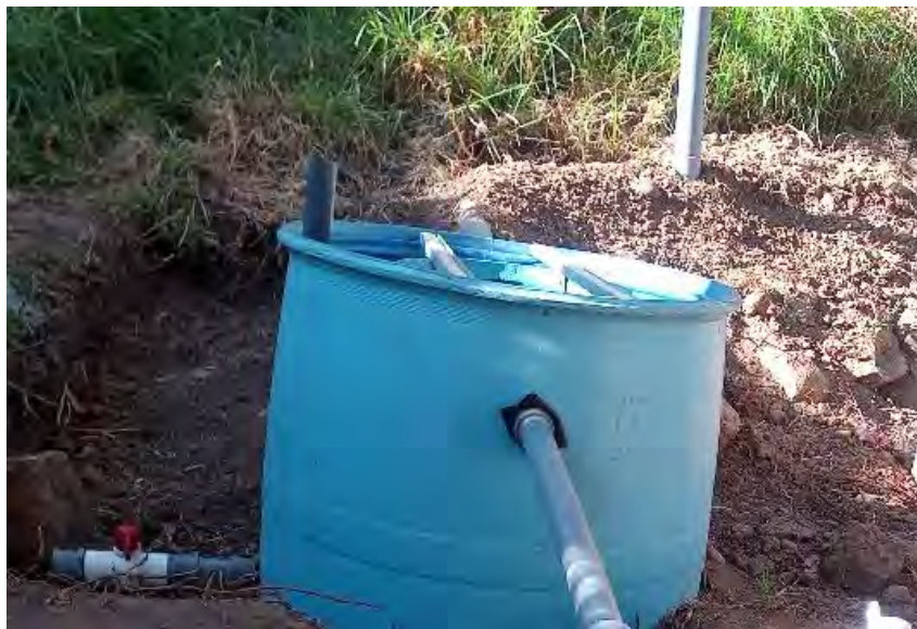
Fotografía 4. Instalación del sedimentador primario circular
