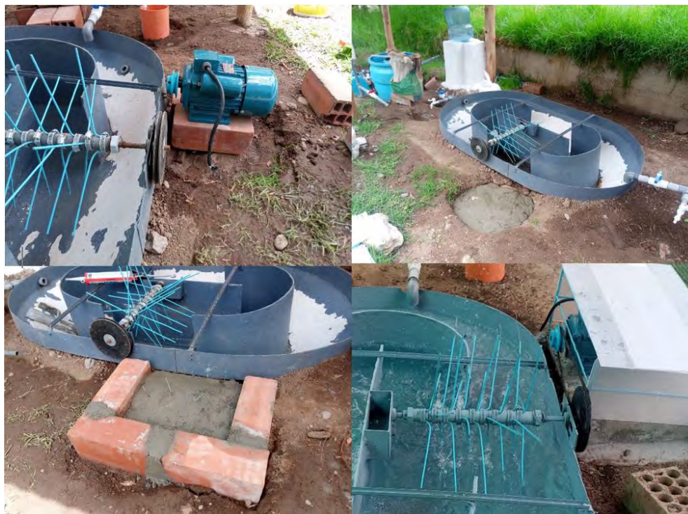
Imagen 19. Instalación del motor eléctrico
