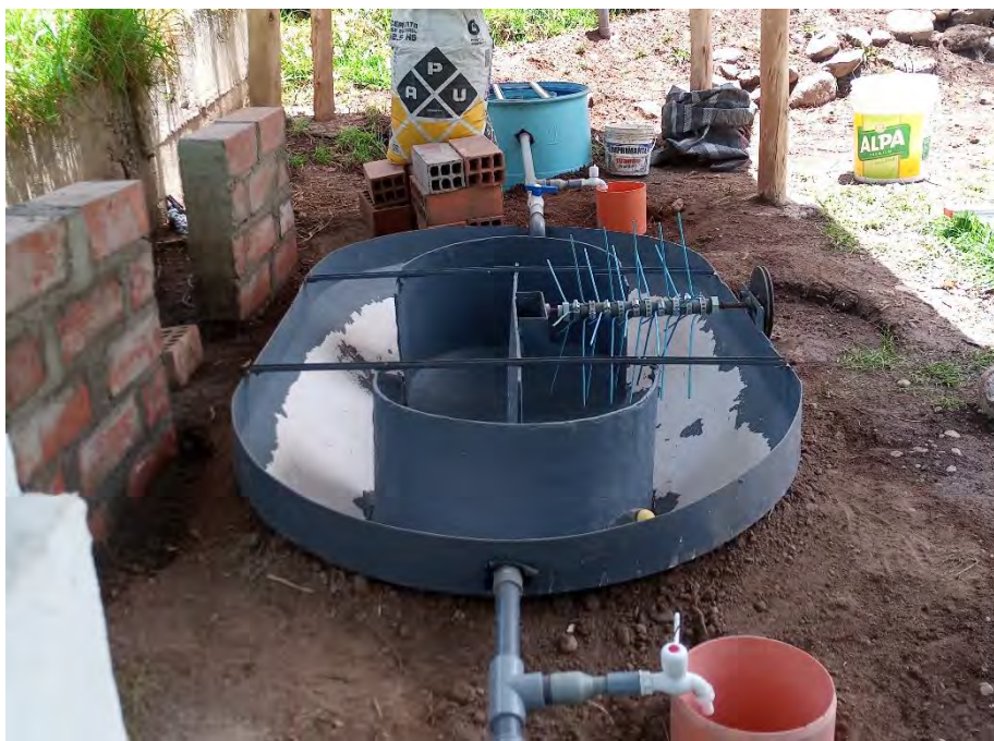
Fotografía 56. Construcción de una pared para colocar el tablero general eléctrico
