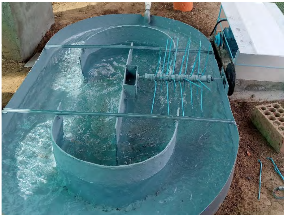
Fotografía 65. Prueba hidráulica de la zanja
