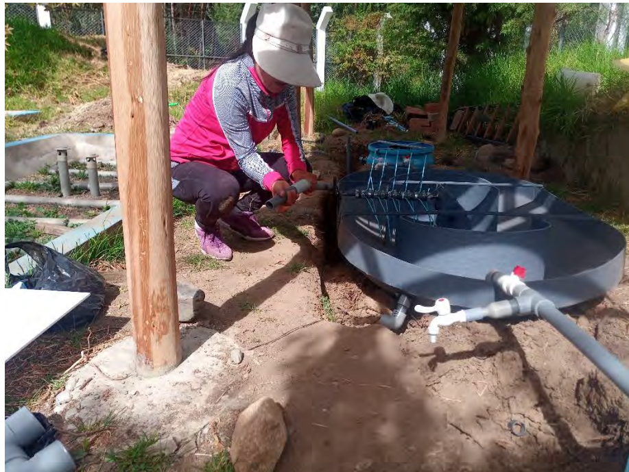
Fotografía 46. Instalación de la tubería de recirculación
