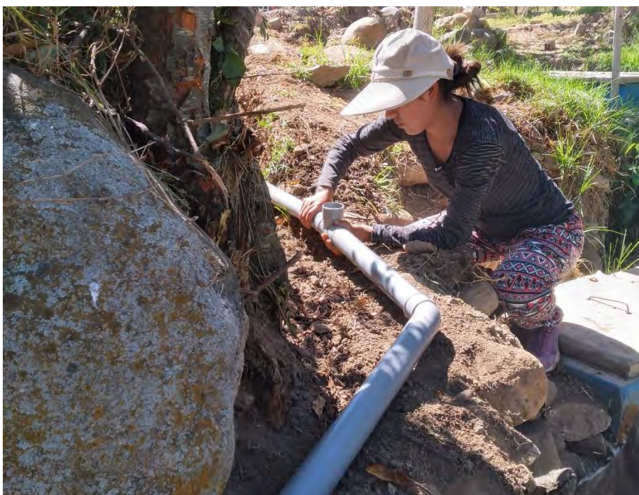
Fotografía 38. Instalación de accesorios en la línea de conducción
