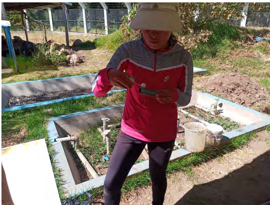
Fotografía 47. Aplicación del pegamento en los accesorios
