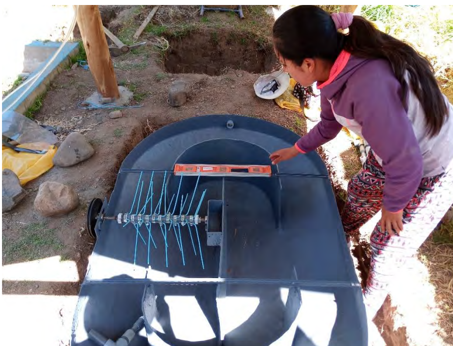
Fotografía 43. Verificación del nivel de burbuja en el reactor
