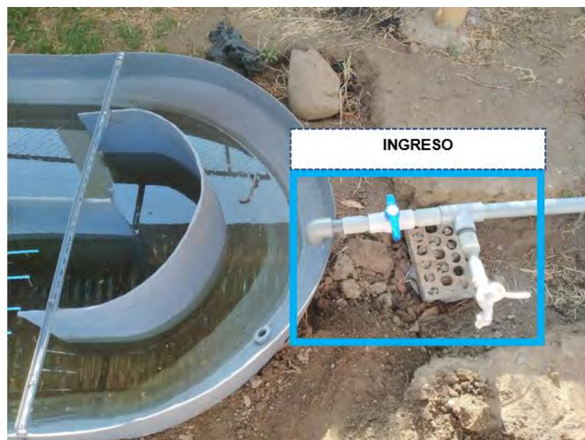
Imagen 16. Ingreso a la Zanja de Oxidación
