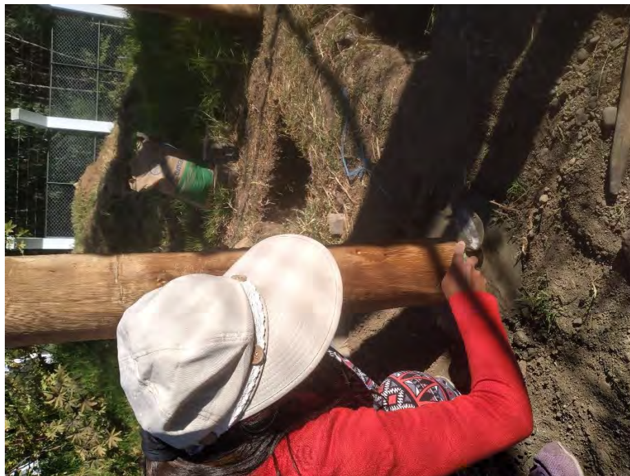
Fotografía 33. Instalación de los postes de madera con concreto
