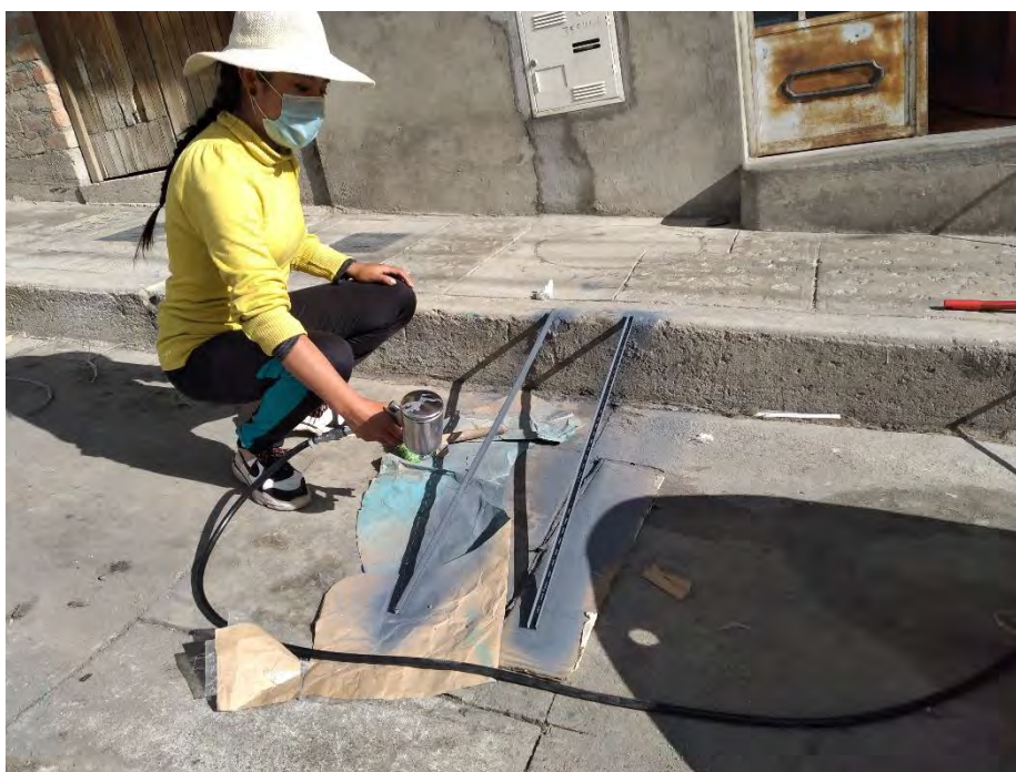
Fotografía 18. Pintado de los medios de soporte con esmalte epóxica de color gris
