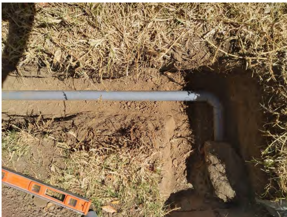
Fotografía 37. Instalación de tubería de 2" en la línea de conducción
