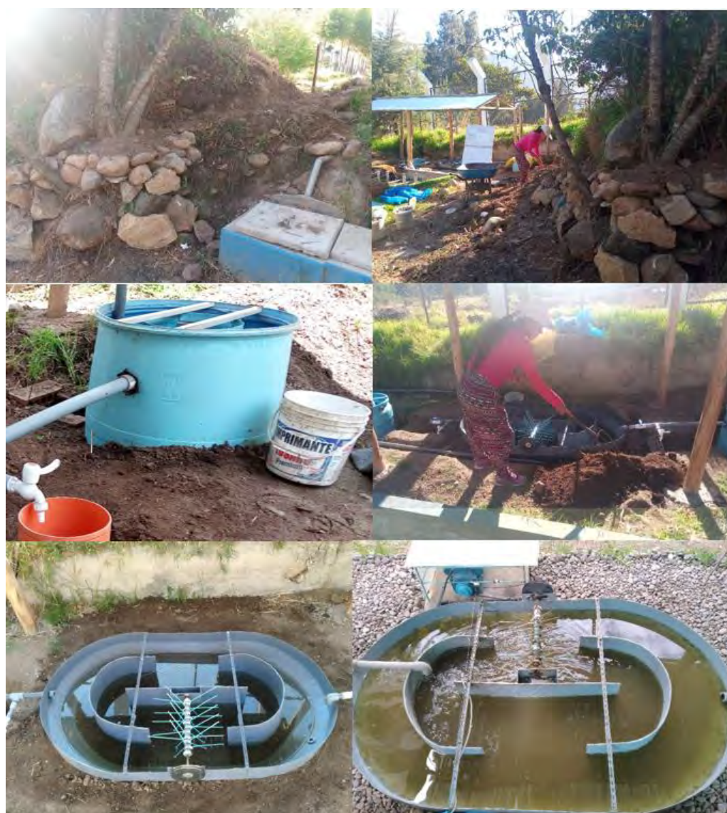
Imagen 21. Rellenos finales y compactación
