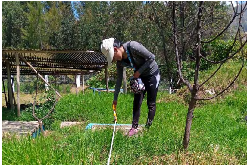
Fotografía 2. Mantenimiento preventivo de la L.C a la cámara de repartición de caudal
