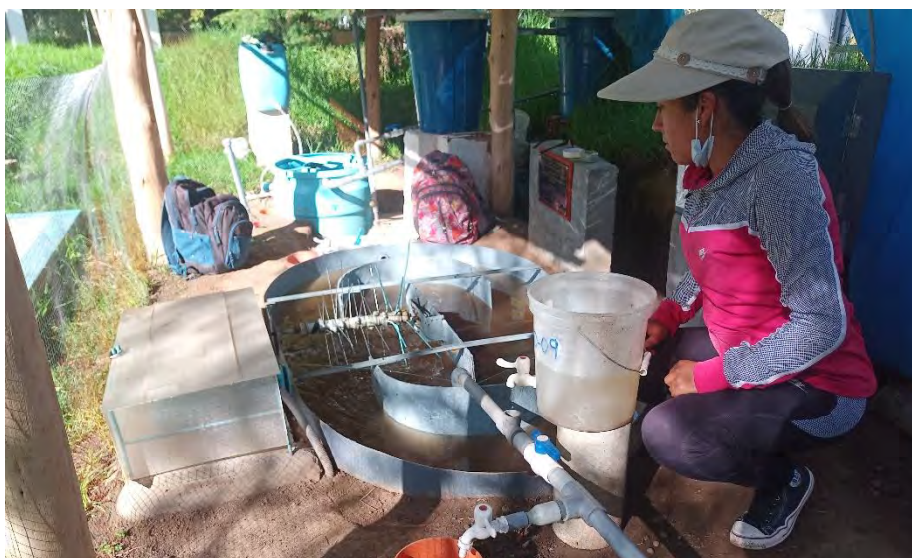
Fotografía 160. Regulación de ingreso de la materia orgánica
