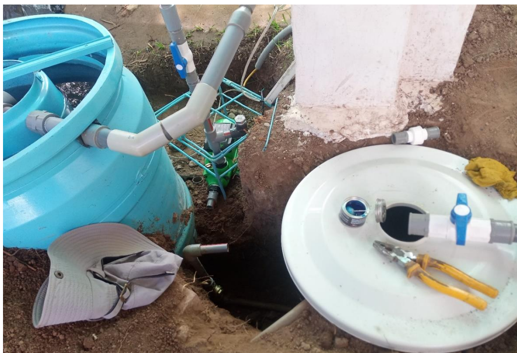
Fotografía 44. Colocación de la cisterna para el sistema de bombeo.
