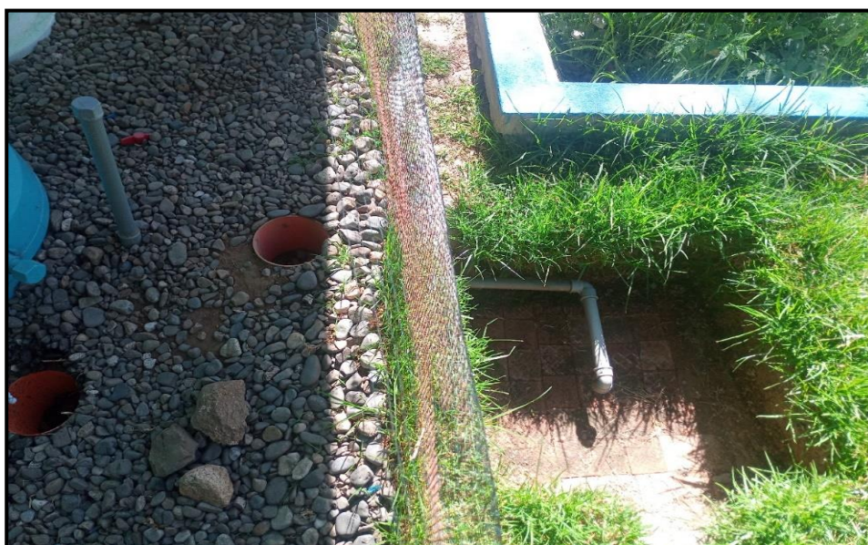
Fotografía 23. Colocación de ladrillo para el lecho de secado.
