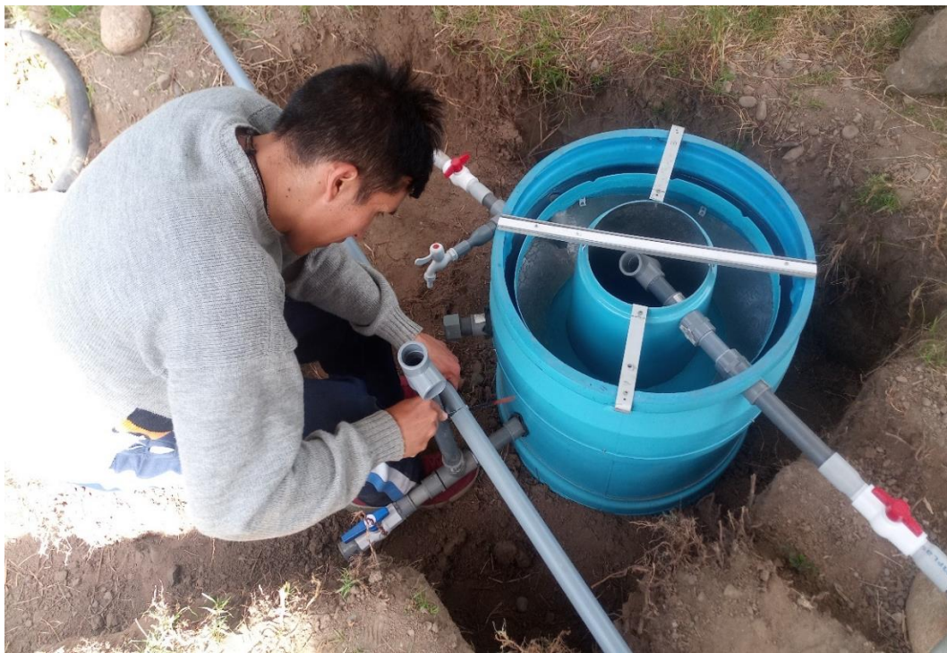
Fotografía 42. Colocación del punto de muestreo en la salida del decantador circular tipo troncocónico doble.
