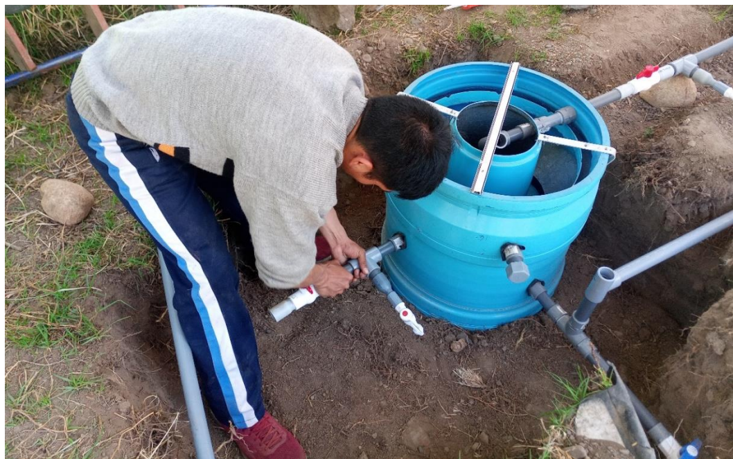
Fotografía 42. Colocación del punto de muestreo en la salida del decantador circular tipo troncocónico doble.
