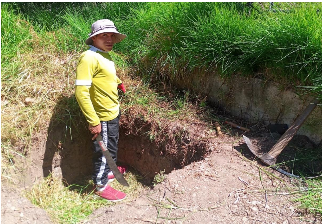
Fotografía 32. Limpieza de la maleza y excavación de la zanja, para el decantador circular tipo troncocónico doble.
