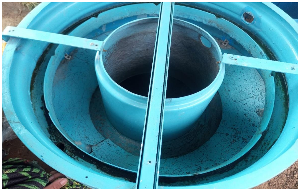
Fotografía 85. Instalación de la falta superior del decantador circular tipo troncocónico doble, luego de realizado el mantenimiento.
