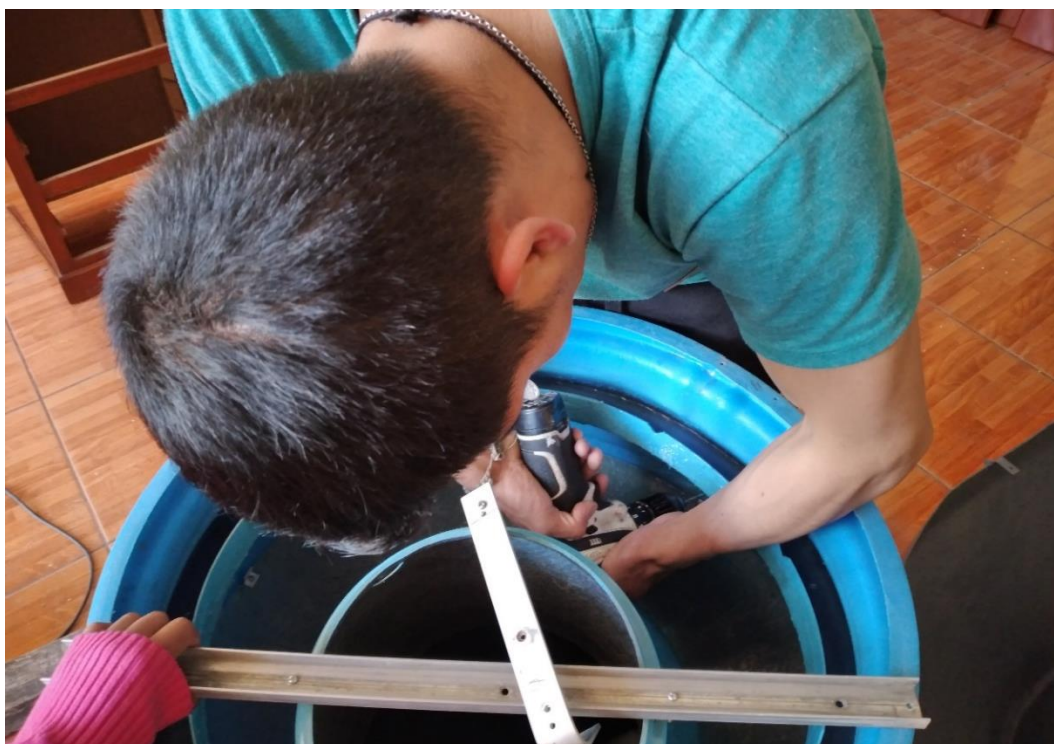
Fotografía 40. Instalación del decantador circular tipo troncocónico doble en la planta piloto ICS.
