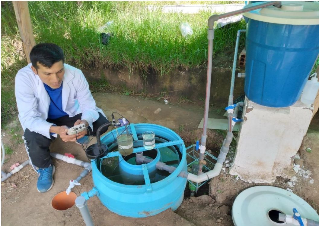
Fotografía 58. Determinación de pH y temperatura del afluente al decantador circular tipo troncocónico doble.
