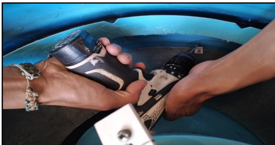
Fotografía 13. Perforación de la parte del decantador circular tipo troncocónico doble, para la instalación de la falda superior.
