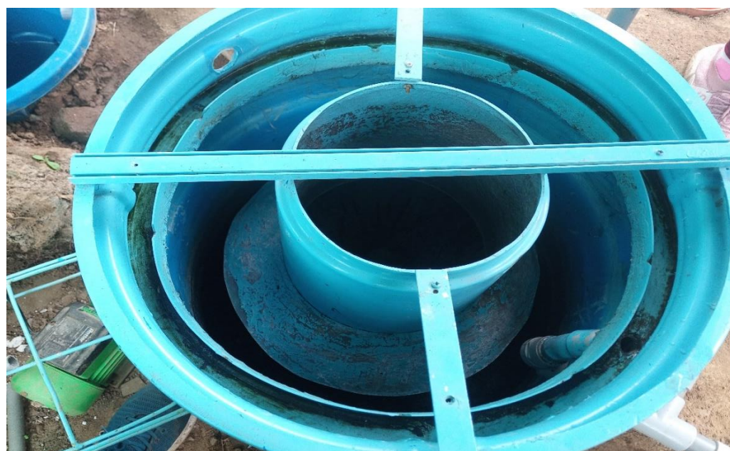
Fotografía 84. Reinstalación de la campana central y la falta inferior del decantador circular tipo troncocónico doble, después de realizar el mantenimiento.
