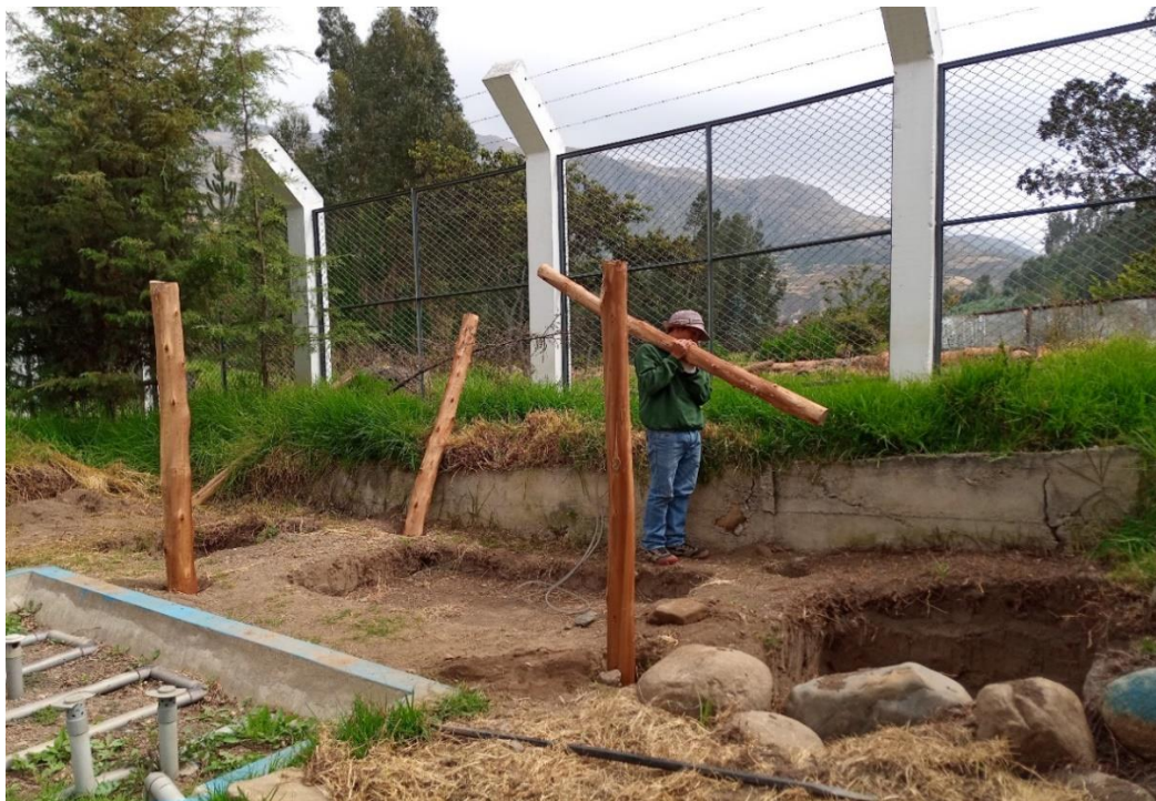
Fotografía 34. Colocación de las columnas de madera de la planta piloto de agua residual ICS.
