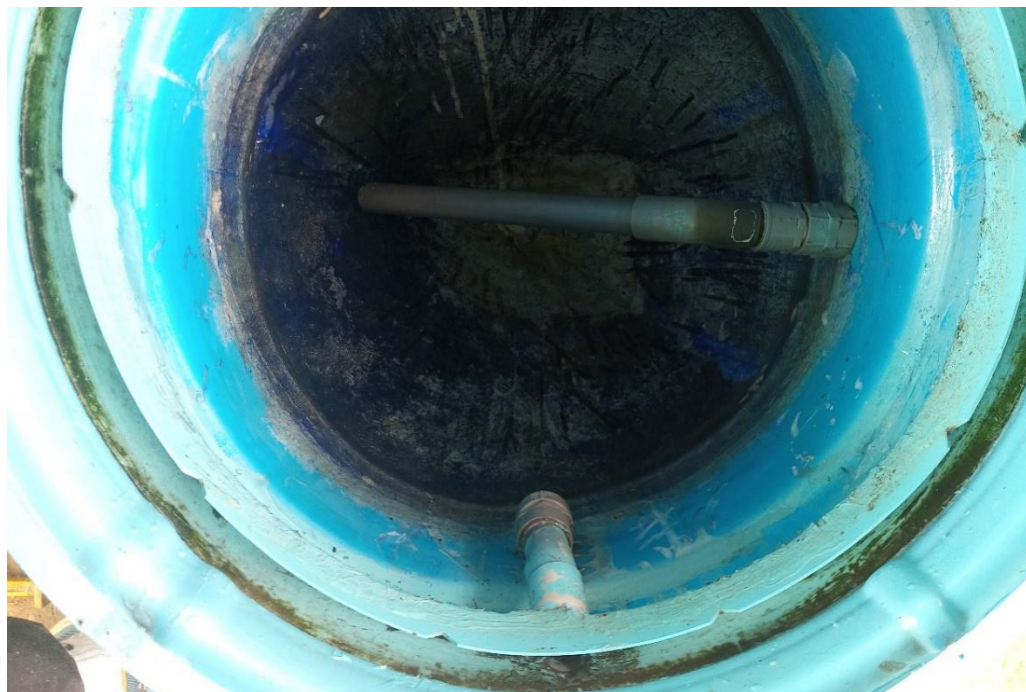
Fotografía 84. Reinstalación de la campana central y la falta inferior del decantador circular tipo troncocónico doble, después de realizar el mantenimiento.
