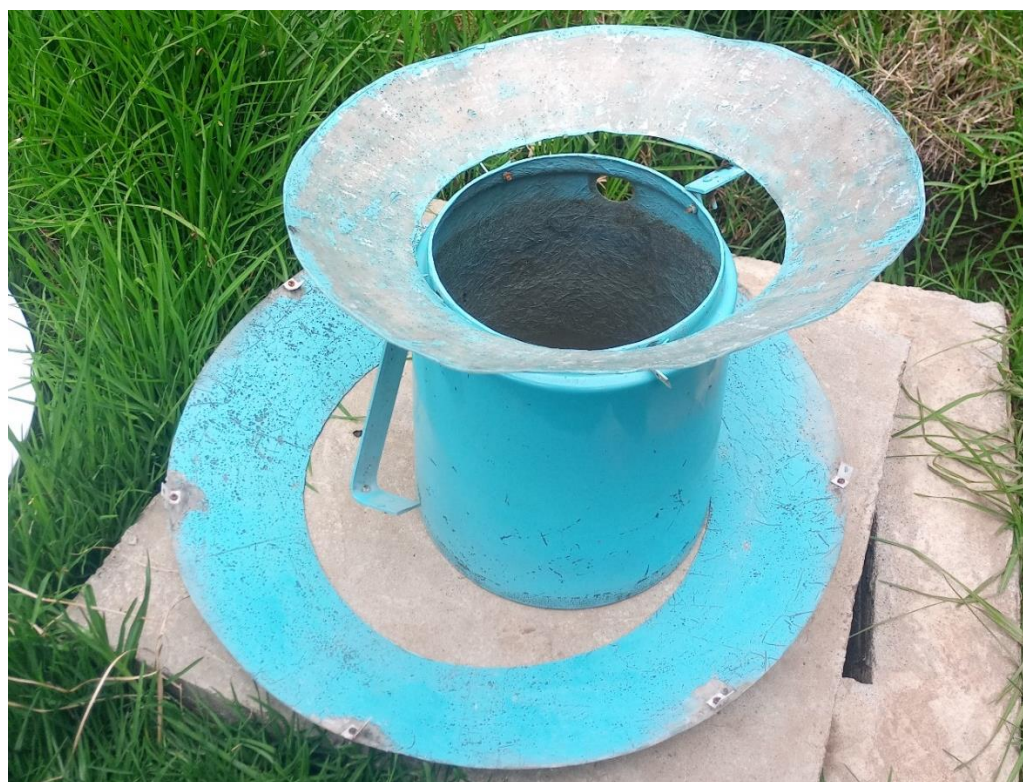
Fotografía 82. Limpieza del cono inferior del decantador circular tipo troncocónico doble.
