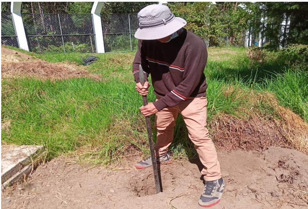
Fotografía 34. Colocación de las columnas de madera de la planta piloto de agua residual ICS.
