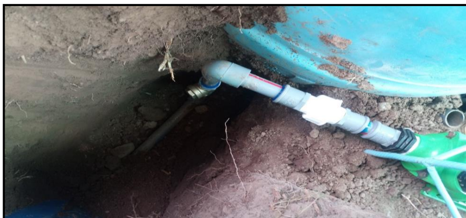
Fotografía 19. Instalación de los accesorios de succión, para el sistema de bombeo.
