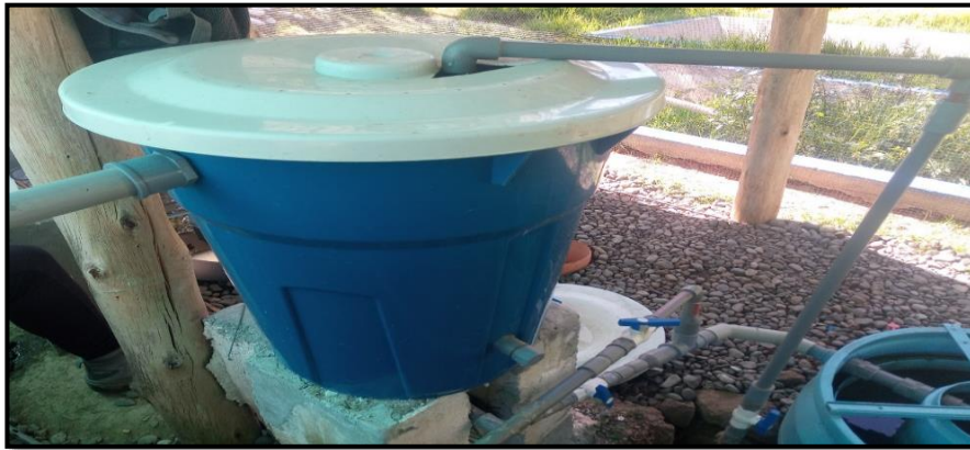
Fotografía 18. Instalación del tanque elevado.
