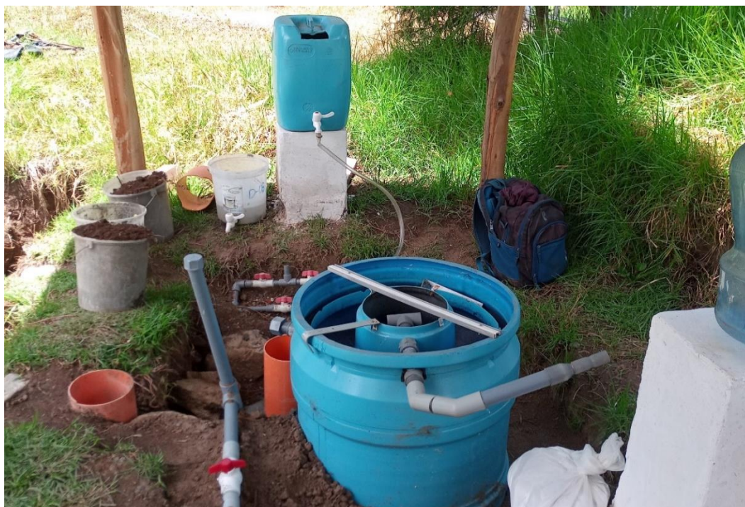
Fotografía 44. Colocación de la cisterna para el sistema de bombeo.
