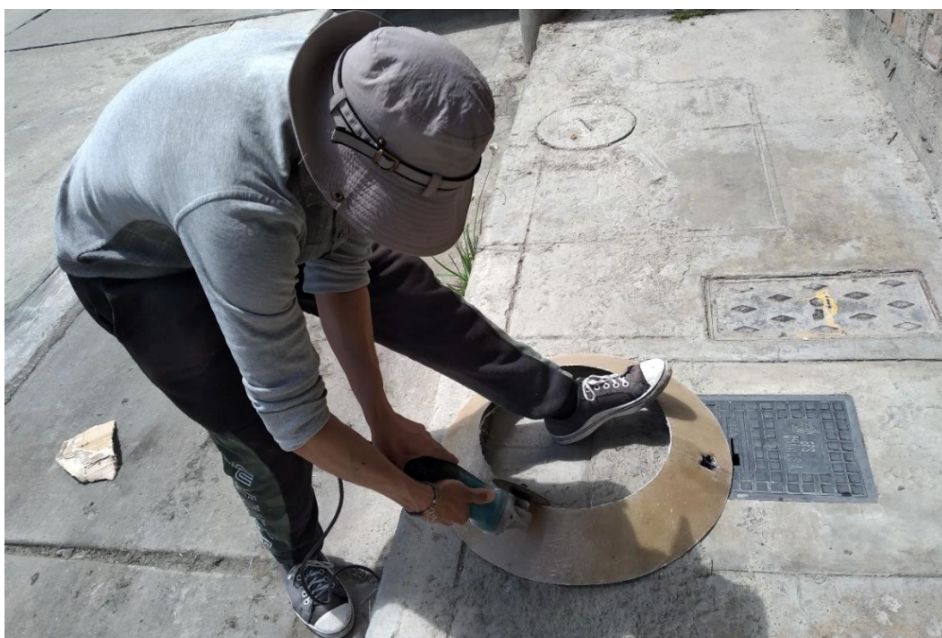
Fotografía 38. Corte y lijado de las faldas de la campana de difusión del decantador circular tipo troncocónico doble.
