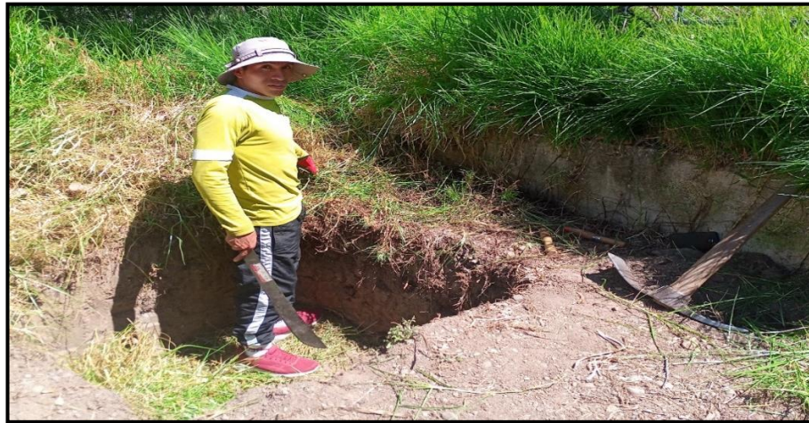
Fotografía 10. Limpieza de la maleza y excavación del decantador.
