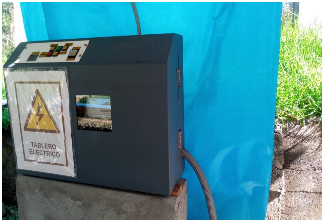
Fotografía 48. Instalación de interruptor termomagnético de 15 A, contactor de 220 V y dos timer de 16 A y 15 A.
