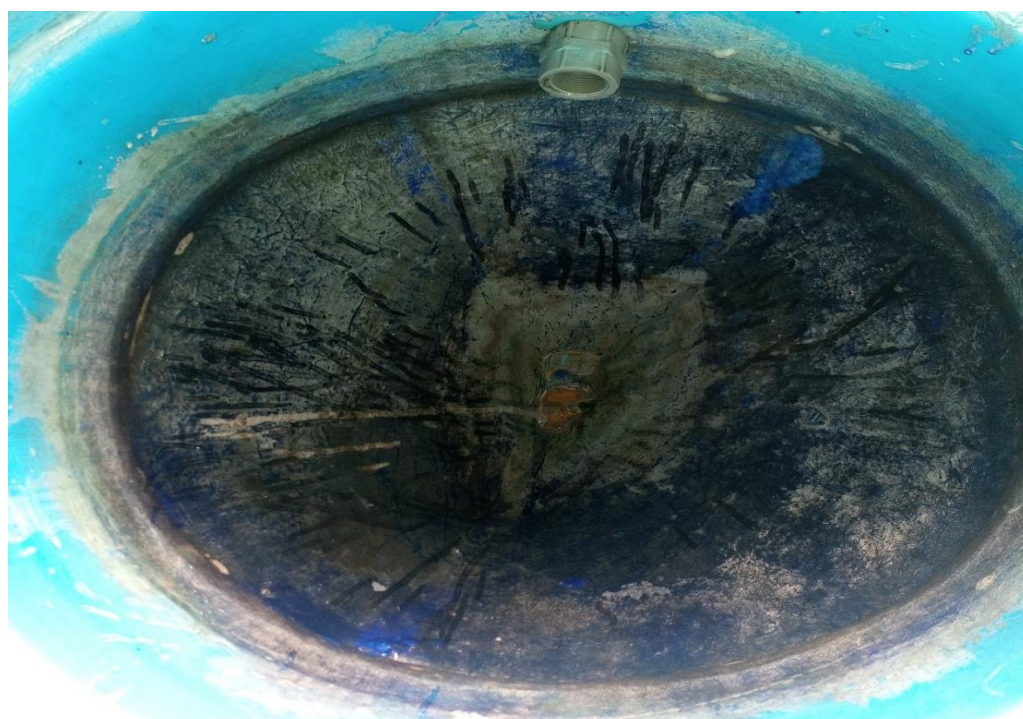
Fotografía 82. Limpieza del cono inferior del decantador circular tipo troncocónico doble.
