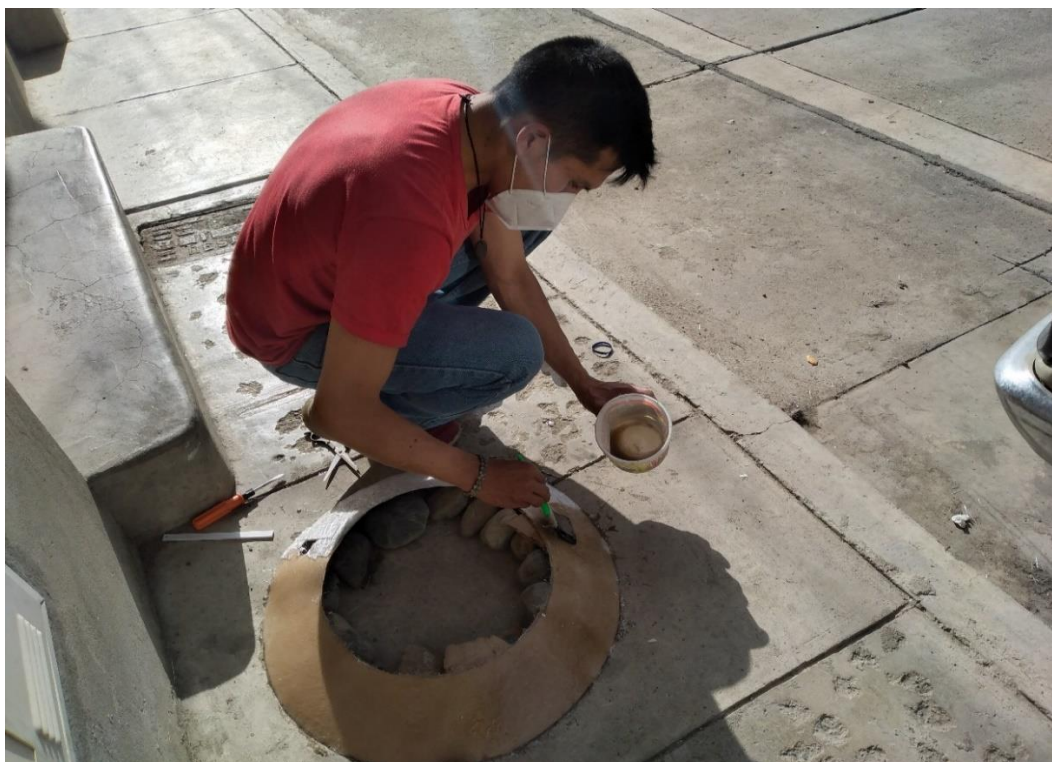
Fotografía 38. Corte y lijado de las faldas de la campana de difusión del decantador circular tipo troncocónico doble.
