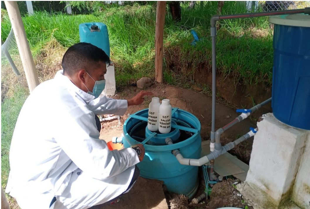
Fotografía 56. Muestra de agua residual que ingresa y sale del decantador circular tipo troncocónico doble.
