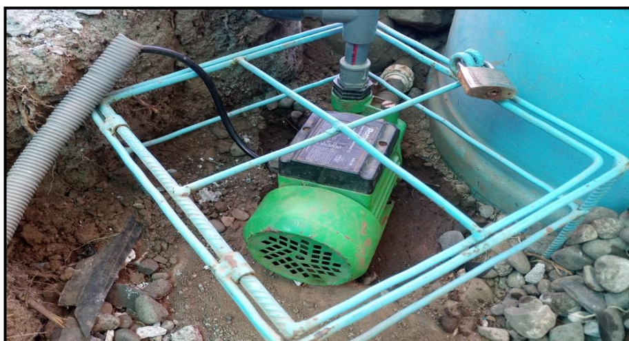
Fotografía 20. Instalación eléctrica para la bomba.
