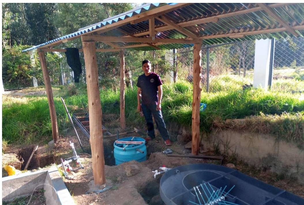
Fotografía 40. Instalación del decantador circular tipo troncocónico doble en la planta piloto ICS.
