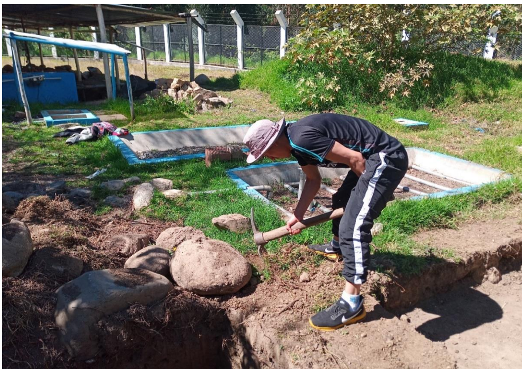
Fotografía 32. Limpieza de la maleza y excavación de la zanja, para el decantador circular tipo troncocónico doble.
