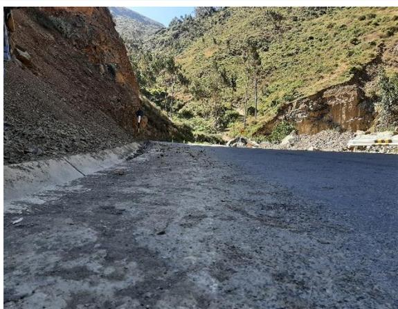
Fotografía 41: Perdida de agregados de la superficie de rodadura del Sector 02
