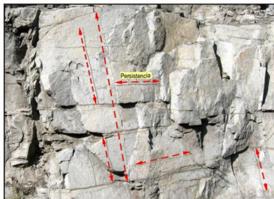
Figura N° 05: Persistencia de una discontinuidad
