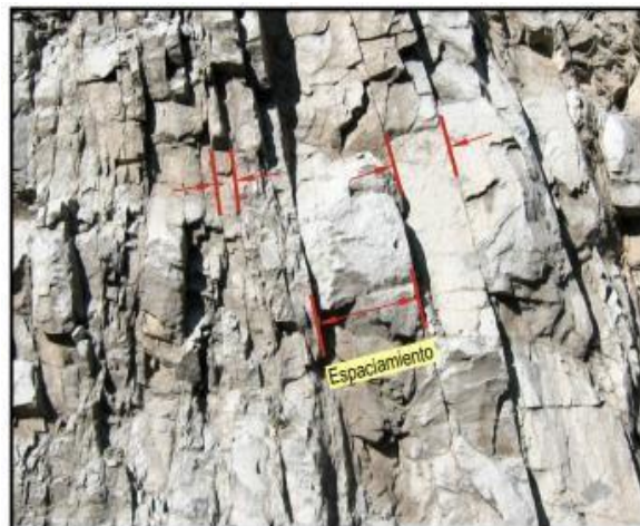
FIGURA N° 04: ESPACIAMIENTO DE UNA DISCONTINUIDAD
