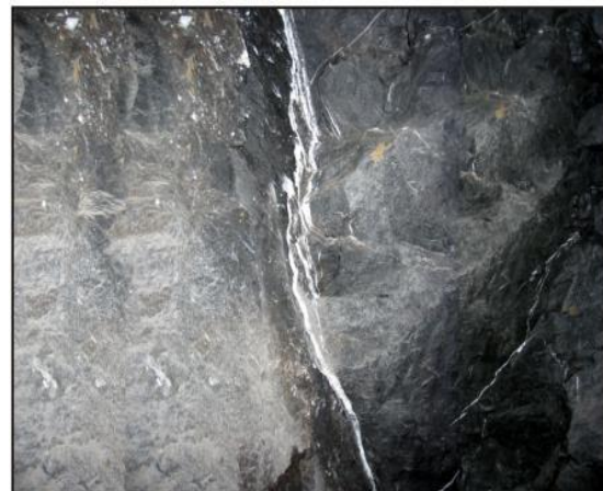
FIGURA N° 08: RELLENO DE UNA DISCONTINUIDAD
