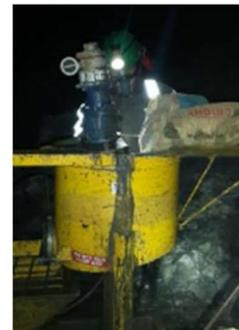
Fuente: JRC Ingeniería y Construcción SAC-Preparación de mezcla de agua y cemento 15l de agua por cada Bolsa de cemento de 42.5kg.
