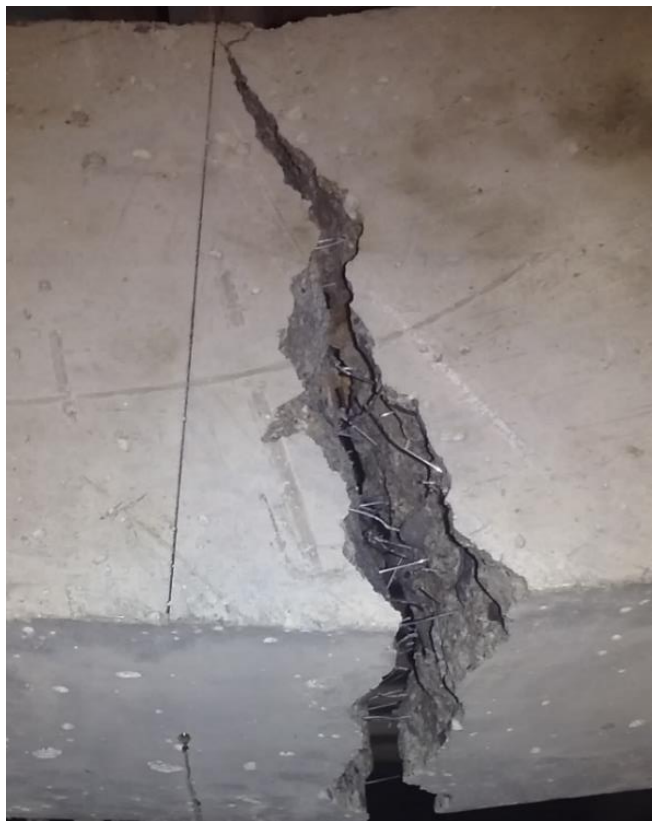
Fotografía N° 22. Sección de probeta prismática con refuerzo de fibra de acero
