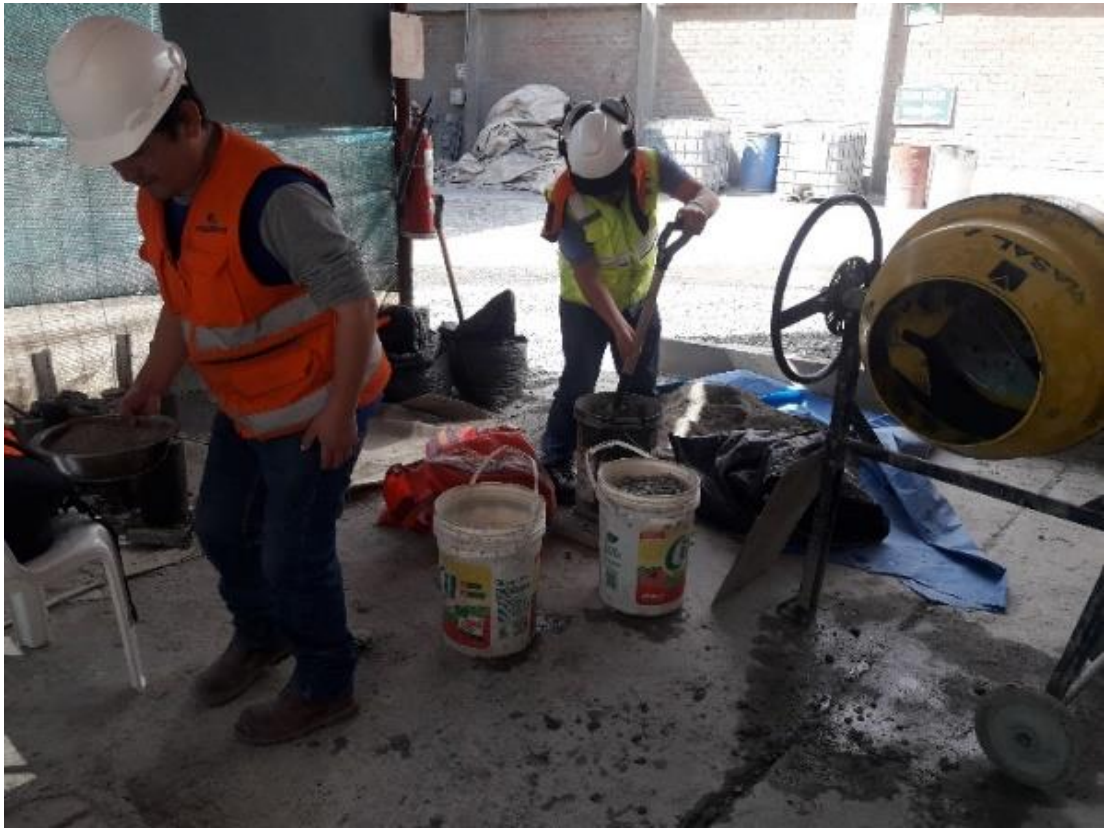
Fotografía N° 1. Dosificación del concreto según diseño de mezcla
