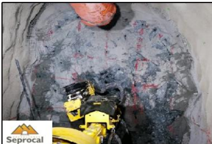
Figura 22. Perforación en el frente de la rampa Patrick.
